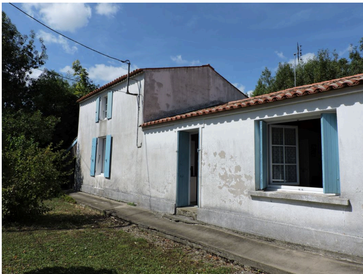
Le logis vu depuis le sud.
