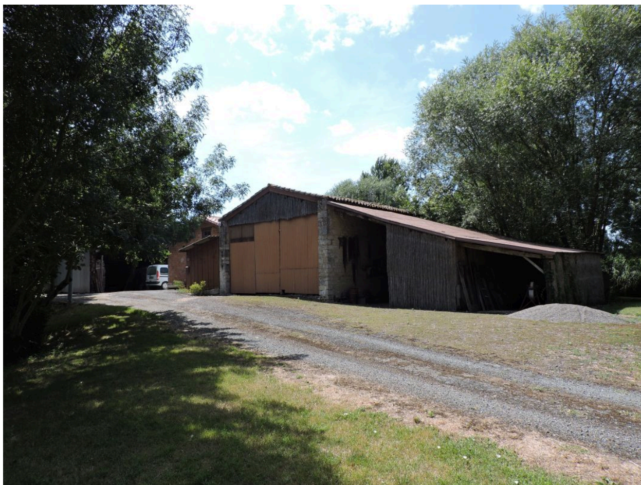
Le hangar en pierre et le hangar en roseau, à l'est de l'ensemble, vus depuis le nord-est.
