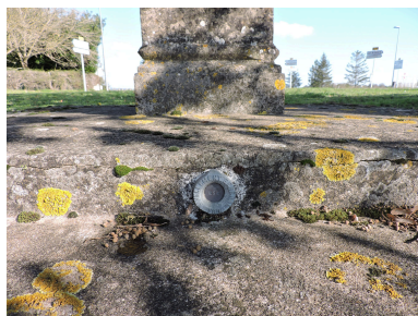
Repère du nivellement général de l'IGN à l'arrière du degré. Phot. Yannis Suire IVR52_20218500622NUCA
