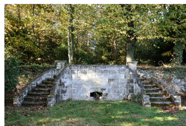
Vue de l'escalier en U permettant d'accéder à la deuxième terrasse. Phot. Bruno Rousseau IVR52_20164901847NUCA
