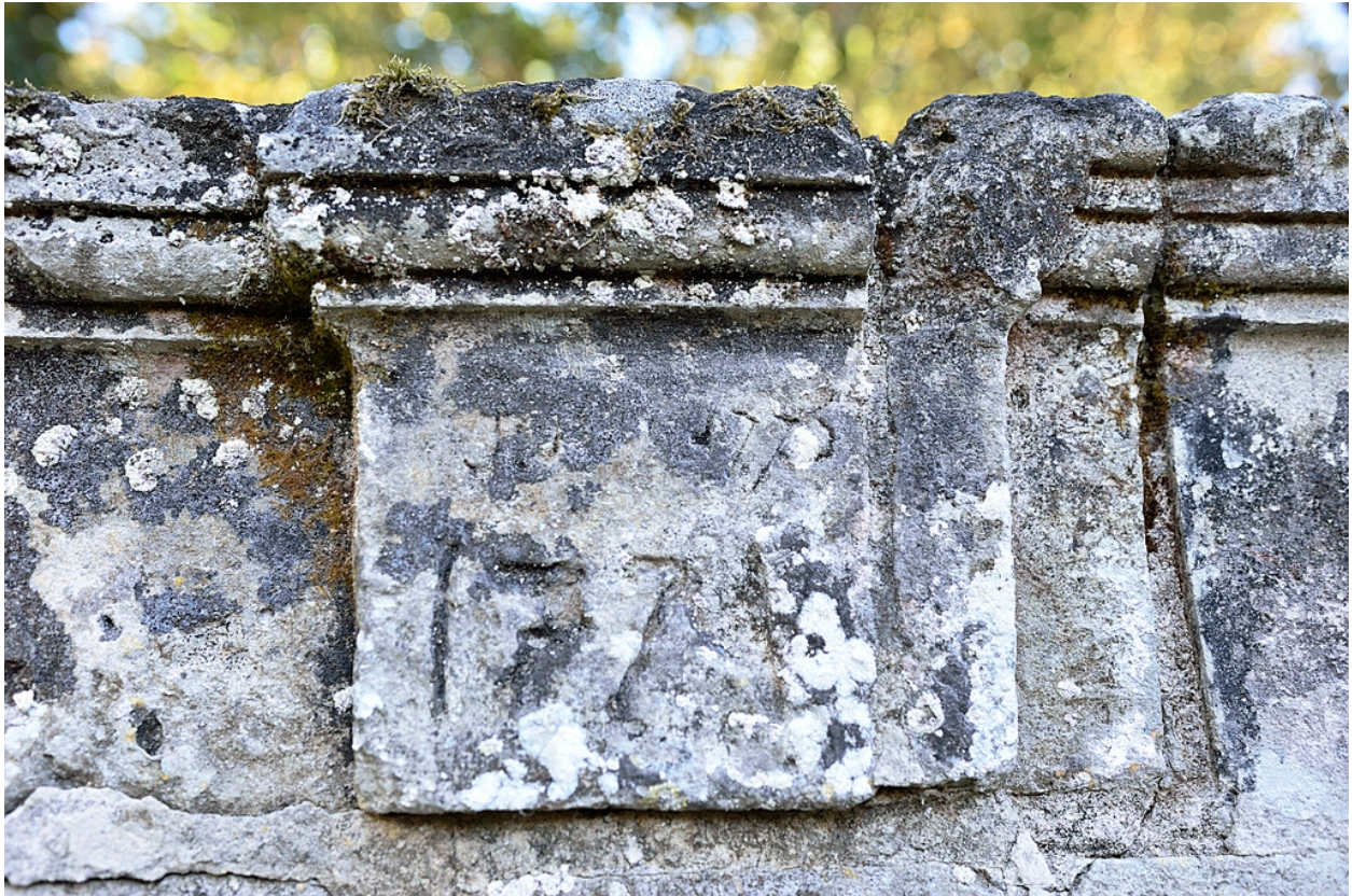
Détail des dates 1771 et 1775 (?) gravées sur l'escalier permettant l'accès à la première terrasse.
