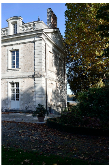
Vue du mur pignon sud. Phot. Bruno Rousseau IVR52_20164901875NUCA
