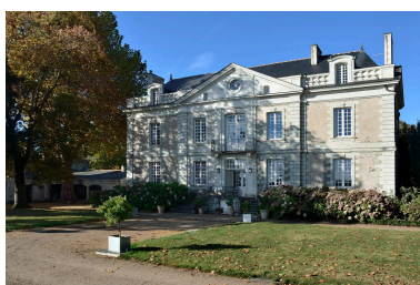
Vue depuis le nord-est. Phot. Bruno Rousseau IVR52_20164901831NUCA
