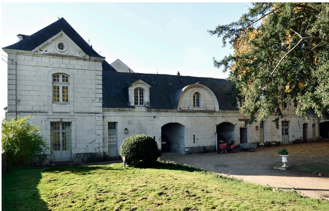
Vue des communs depuis le nord.
