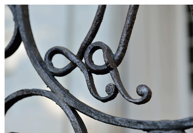
Détail du balcon en fer forgé. Phot. Bruno Rousseau IVR52_20164901840NUCA
