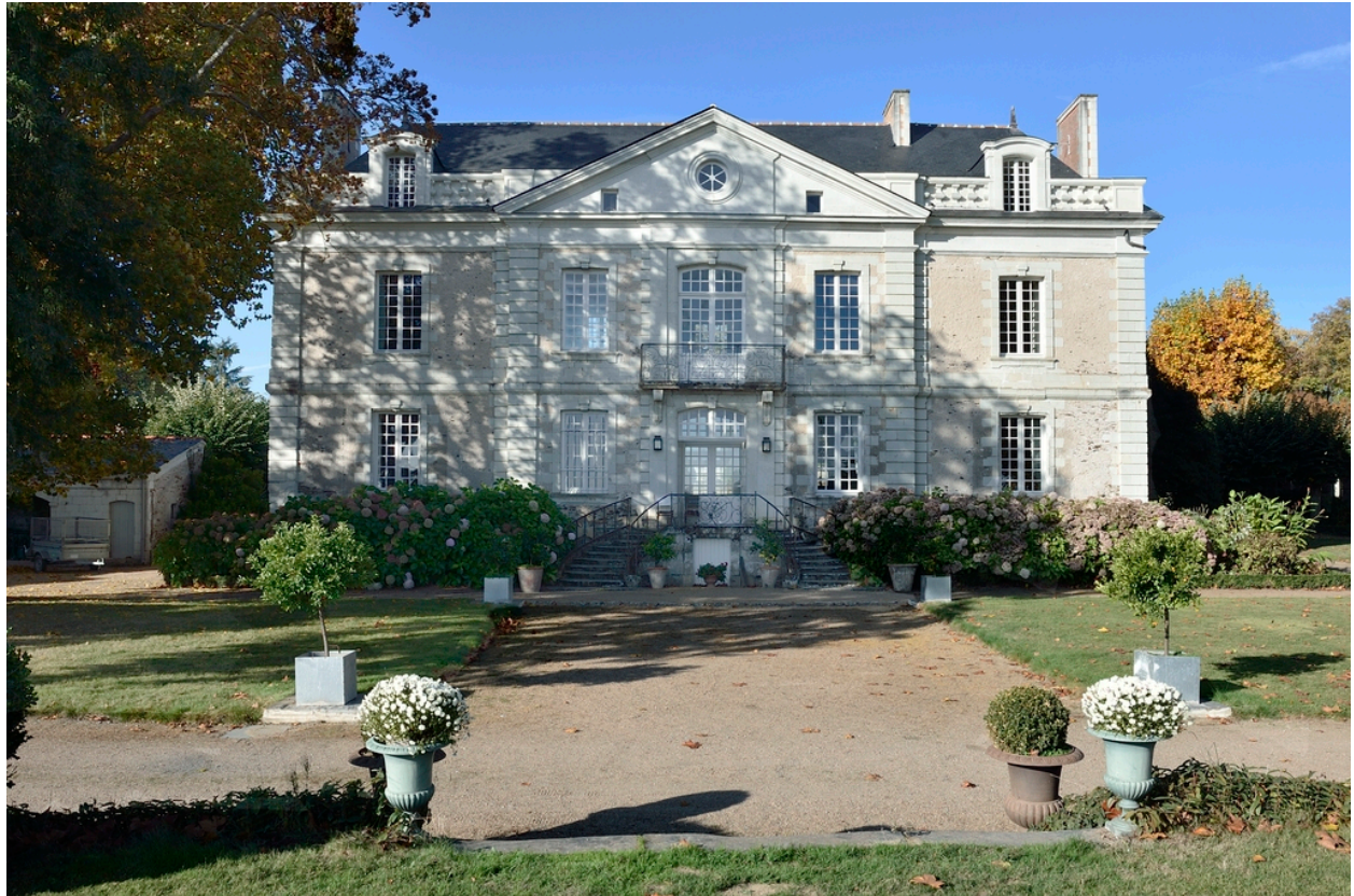
Vue de la façade est.
