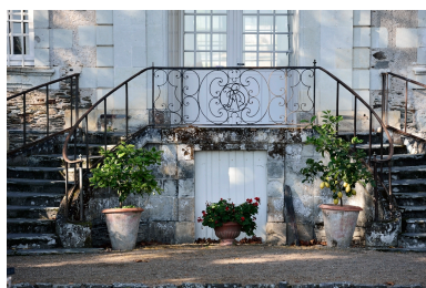
Vue du perron. Escalier en U, volée double à montée parallèle. Phot. Bruno Rousseau IVR52_20164901862NUCA
