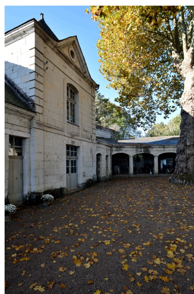
Vue des commons depuis l'est. Phot. Bruno Rousseau IVR52_20164901834NUCA
