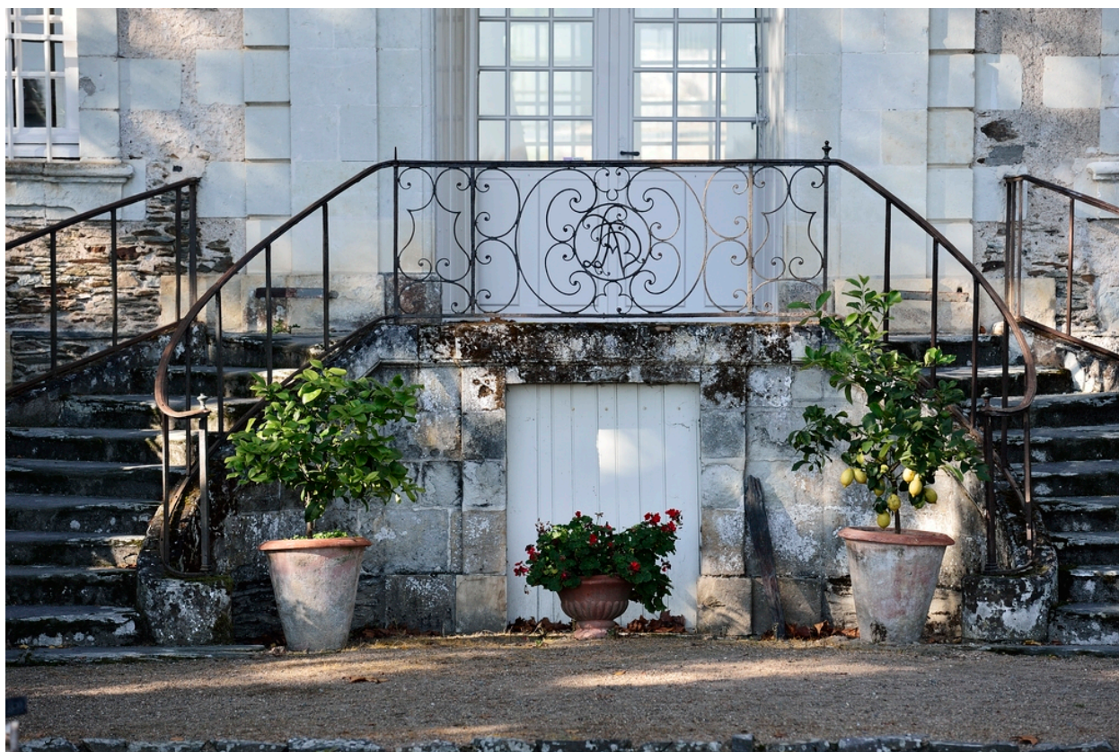
Vue du perron. Escalier en U, volée double à montée parallèle.
