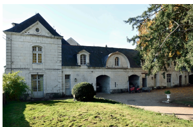
Vue des communs depuis le nord. Phot. Bruno Rousseau IVR52_20164901832NUCA
