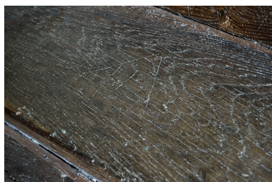
Détail d'un numéro d'assemblage sur une marche de l'escalier. Phot. Bruno Rousseau IVR52_20164901869NUCA
