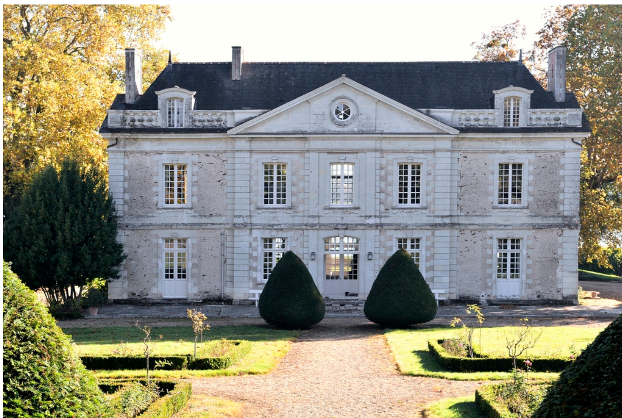
Vue de la façade arrière.
