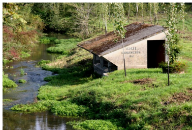
Vue d'ensemble prise du pont. Phot. Jean-Baptiste Darrasse IVR52_20067207512NUCA
