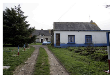
Vue d'ensemble depuis le nord-ouest : au fond, le logis ; au premier plan, l'ancienne dépendance convertie en habitation. Phot. François Lasa IVR52_20075301320NUCA
