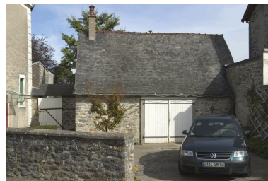
Vue depuis la rue. Phot. François Lasa IVR52_20045303128NUCA
