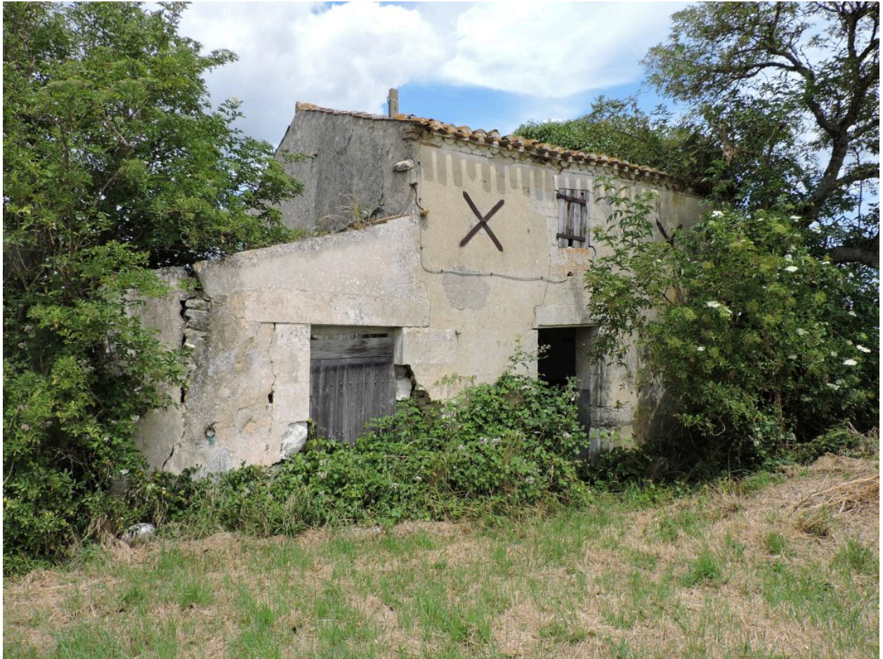
La maison vue depuis le sud-est.
