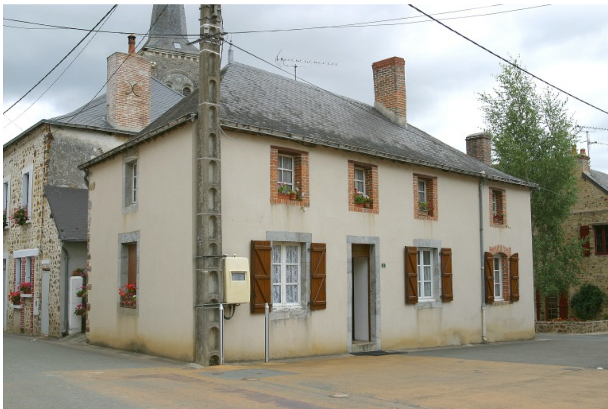
Façade principale sur la rue de la poterie et élévation ouest sur la route de Saint-Pierre.
