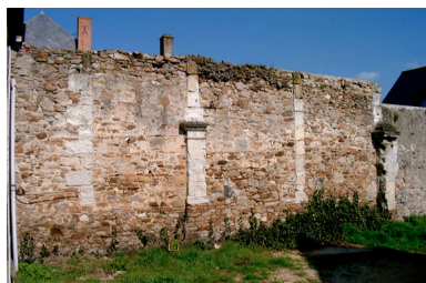
Mur conservant des vestiges de colonnes en tuffeau. Phot. Ronan Durandière IVR52_20064903466NUCA
