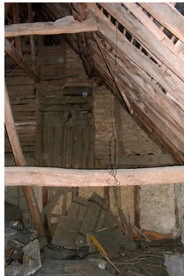
Détail de la charpente. Phot. Ronan Durandière IVR52_20064903465NUCA
