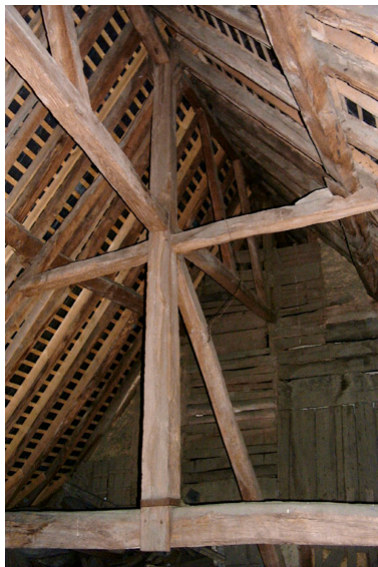
Détail de la charpente. Phot. Ronan Durandière IVR52_20064903464NUCA
