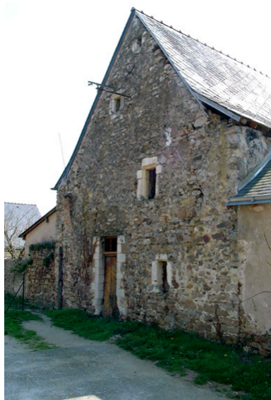
Pignon sur cour. Phot. Ronan Durandière IVR52_20064903463NUCA
