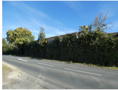
Les vestiges du logis vus depuis le sud. Phot. Yannis Suire IVR52_20228500674NUCA
