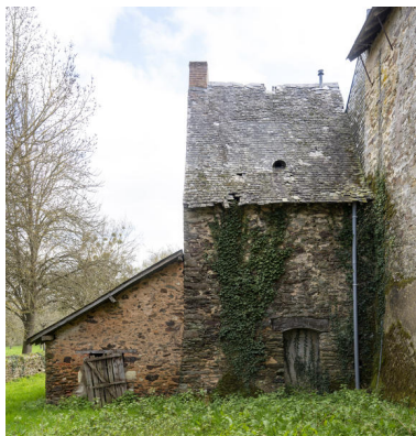
Le bâtiment abritant le four. Phot. Pierre-Bernard Fourny IVR52_20225300313NUCA
