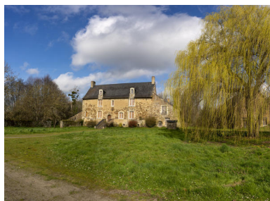
Le logis. Phot. Pierre-Bernard Fourny IVR52_20225300301NUCA
