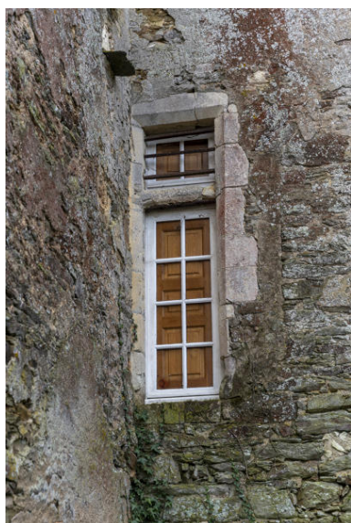
Une demi-croisée de la façade postérieure. Phot. Pierre-Bernard Fourny IVR52_20225300309NUCA
