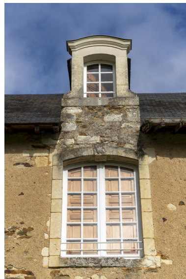
Une fenêtre et une lucarne de la façade antérieure. Phot. Pierre-Bernard Fourny IVR52_20225300324NUCA
