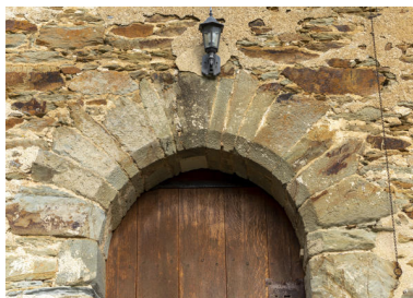
Un détail de l'arc de la porte principale. Phot. Pierre-Bernard Fourny IVR52_20225300327NUCA
