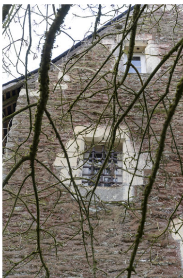
La tour d'escalier, détail des ouvertures. Phot. Pierre-Bernard Fourny IVR52_20225300311NUCA
