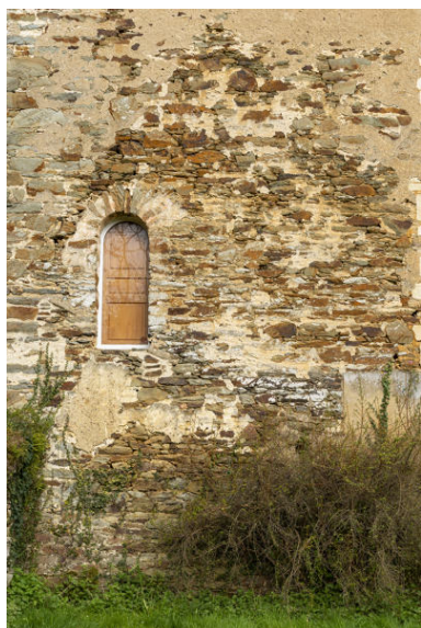
L'accès et l'empreinte de l'ancienne chapelle. Phot. Pierre-Bernard Fourny IVR52_20225300326NUCA
