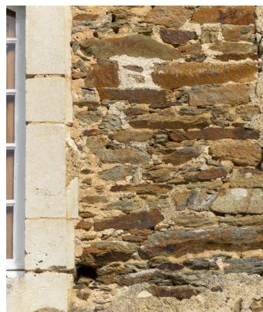
Un détail de la maçonnerie. Phot. Pierre-Bernard Fourny IVR52_20225300323NUCA
