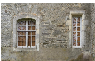
Des fenêtres de la façade postérieure. Phot. Pierre-Bernard Fourny IVR52_20225300314NUCA
