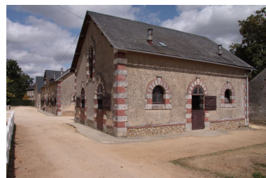
Petit bâtiment est. Phot. Jean-Baptiste Darrasse IVR52_20097200490NUCA
