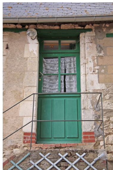
Le vieil hameau, maison 2 en rez- de-chaussée : la porte d'entrée dans une ancienne croisée. Phot. Jean-Baptiste Darrasse IVR52_20097200507NUCA
