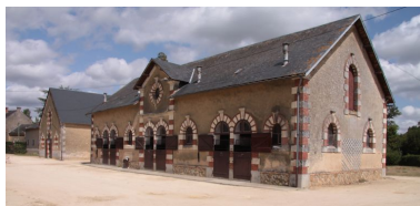
Les mêmes étables en 2009. Phot. Jean-Baptiste Darrasse IVR52_20097200489NUCA
