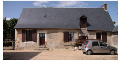
Le vieil hameau : maison 3 en rez-de-chaussée. Phot. Jean-Baptiste Darrasse IVR52_20097200510NUCA
