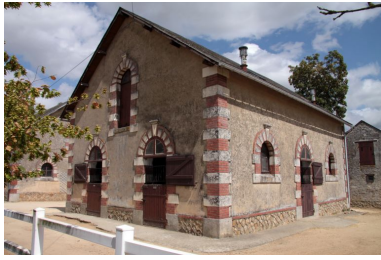
Petit bâtiment est : vue de volume. Phot. Jean-Baptiste Darrasse IVR52_20097200491NUCA
