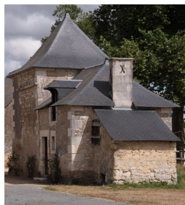
Le vieil hameau : pigeonnier du XVIIe siècle et buanderie accolée. Phot. Jean-Baptiste Darrasse IVR52_20097200503NUCA
