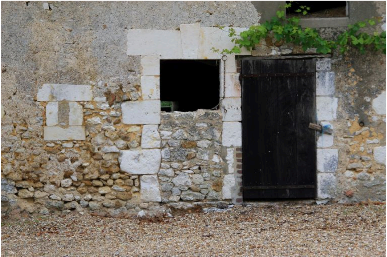
La grange : porte remaniée.
