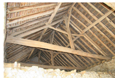
La grange : charpente à pannes. Phot. Jean-Baptiste Darrasse IVR52_20087202092NUCA
