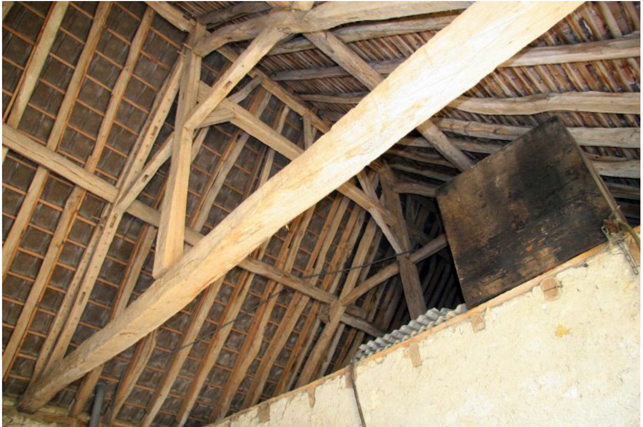
La grange : charpente à pannes avec sous-faîtage.
