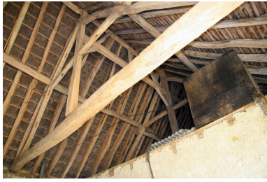
La grange : charpente à pannes avec sous-faîtage. Phot. Jean-Baptiste Darrasse IVR52_20087202094NUCA
