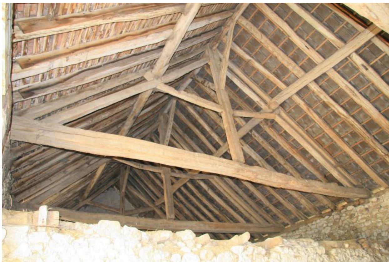
La grange : charpente à pannes.
