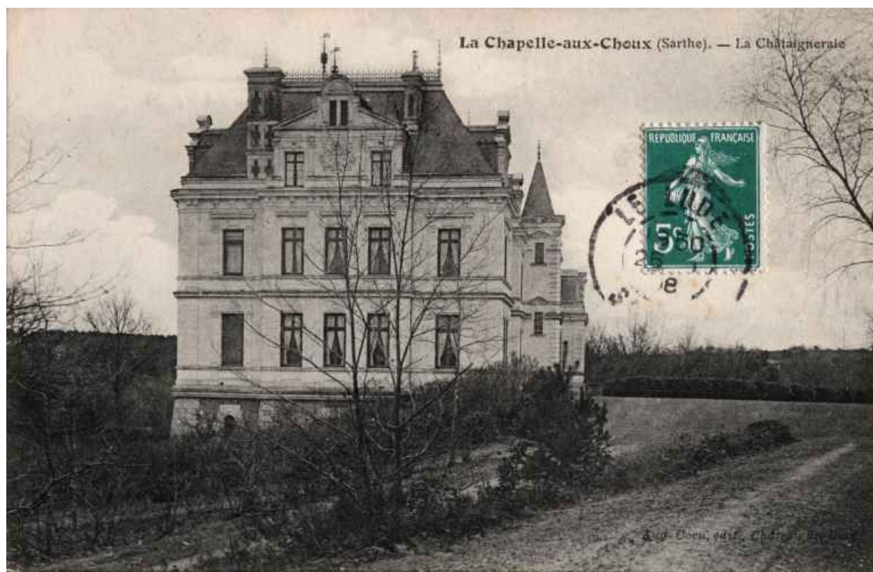
Vue générale de la façade ouest.
