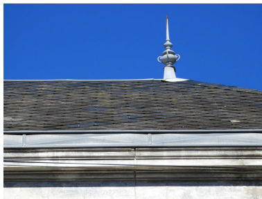
Détail du toit : ardoise, épi de faîtage en zinc. Phot. Yannis Suire IVR52_20198500282NUCA
