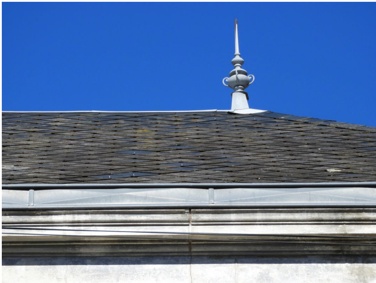
Détail du toit : ardoise, épi de faîtage en zinc.
