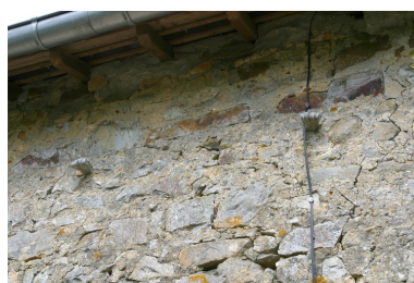
Détail de la façade principale du logis : attaches en os. Phot. François Lasa IVR52_20035301477NUCA
