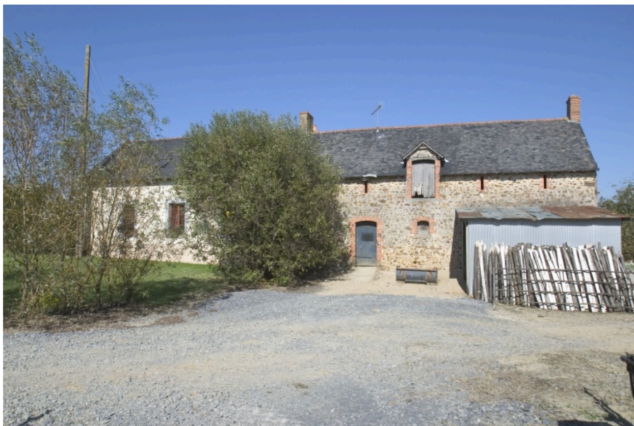
Le bâtiment de logis vu depuis l'ouest.
