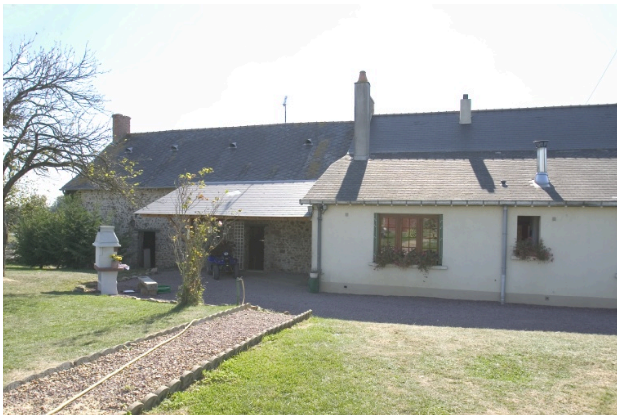
Le bâtiment de logis vu depuis l'est.
