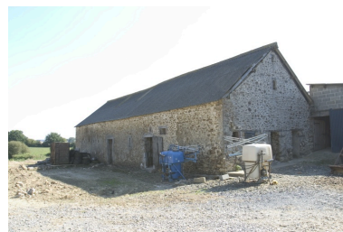
L'étable. Phot. François Lasa IVR52_20045302530NUCA
