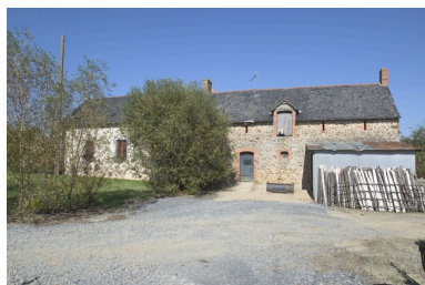
Le bâtiment de logis vu depuis l'ouest. Phot. François Lasa IVR52_20045302531NUCA
