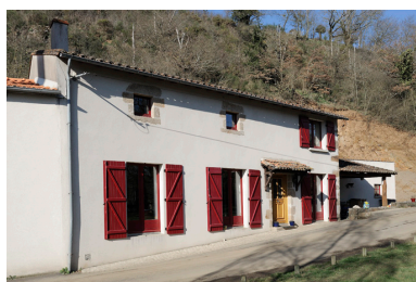
La maison de maître du moulin Bodin. Phot. Bruno Rousseau IVR52_20114900491NUCA
