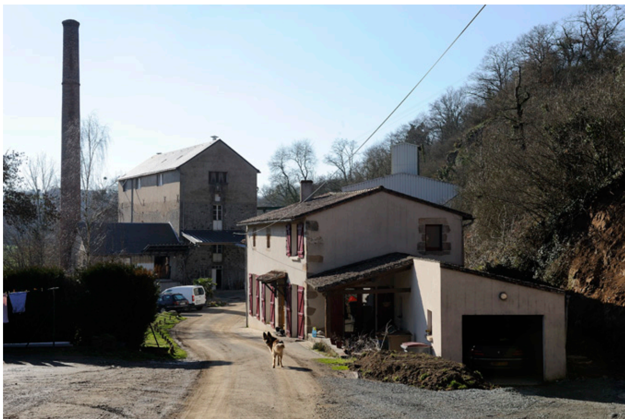
La minoterie Bodin, vue depuis la route d'accès.
