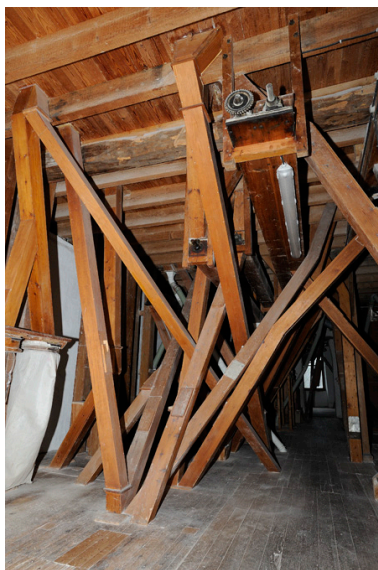
Tubes permettant l'acheminement du blé aux différentes étapes de sa transformation. Phot. Bruno Rousseau IVR52_20114900018NUCA
