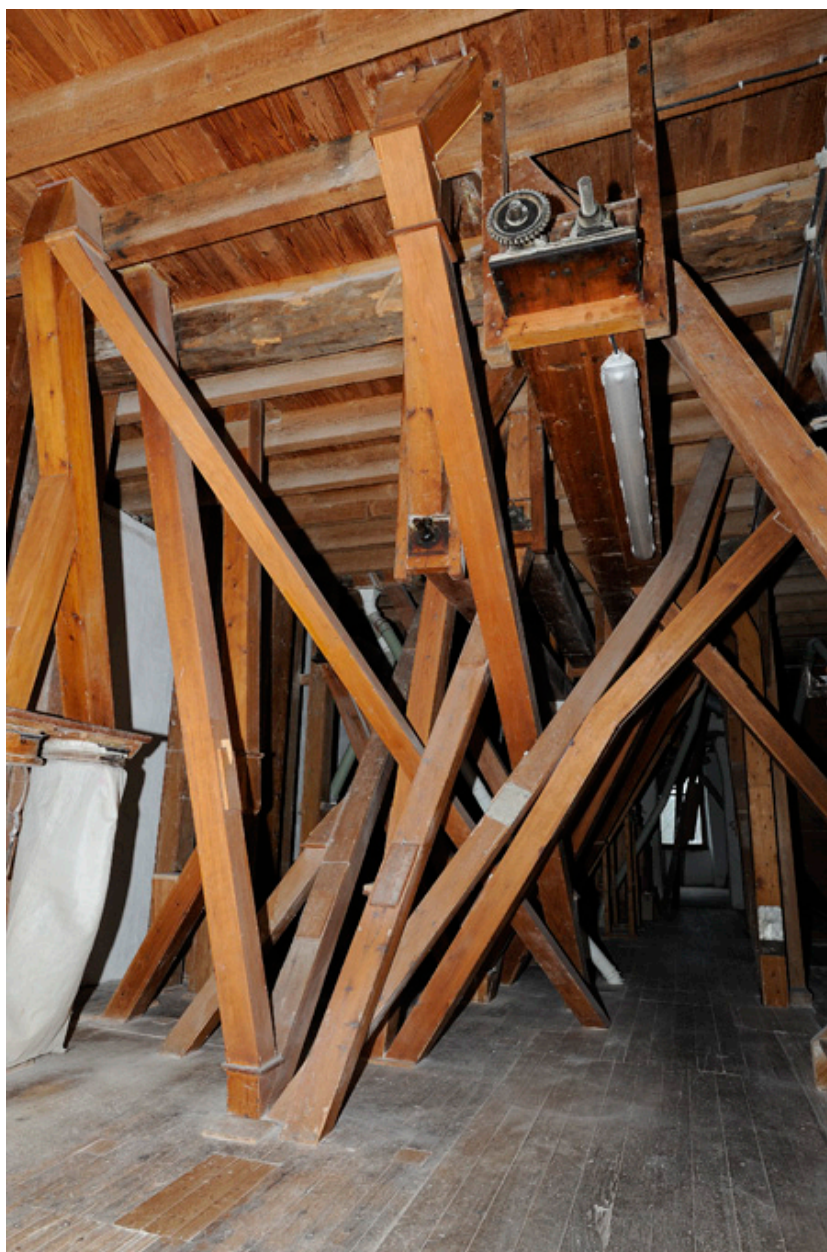
Tubes permettant l'acheminement du blé aux différentes étapes de sa transformation.
