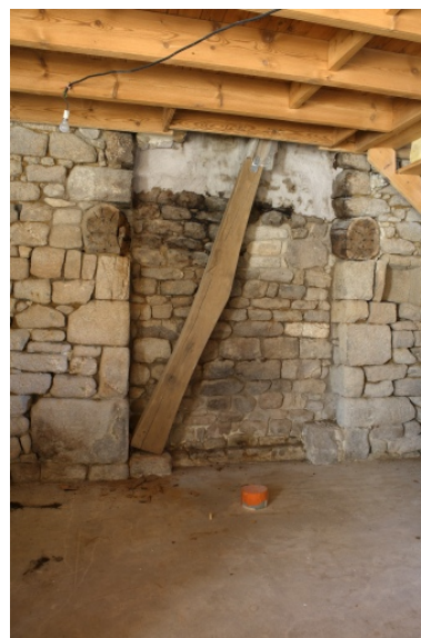
1er logis. Pignon sud. Cheminée. Phot. Denis Pillet IVR52_20074401499NUCA
