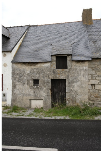
Vue du 7e logis. Phot. Denis Pillet IVR52_20074401697NUCA
