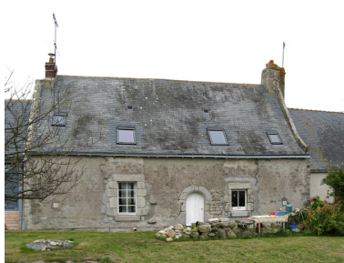
1er logis. Façade ouest. Phot. Denis Pillet IVR52_20074401963NUCA
