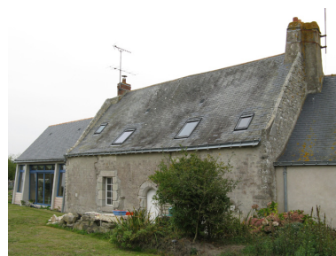
1er logis. Façade ouest, depuis le sud-ouest. Phot. Denis Pillet IVR52_20074401962NUCA
