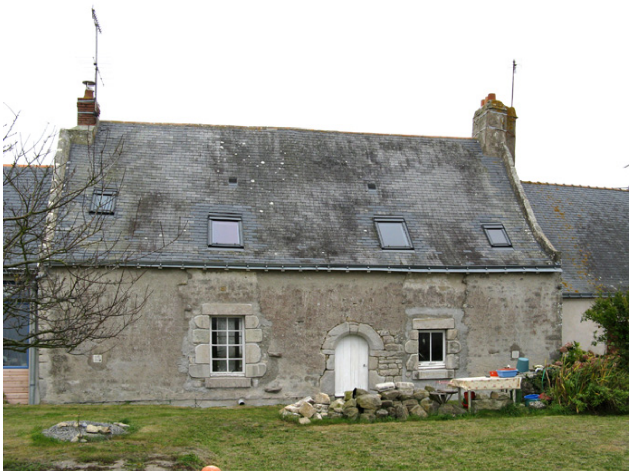
1er logis. Façade ouest.
