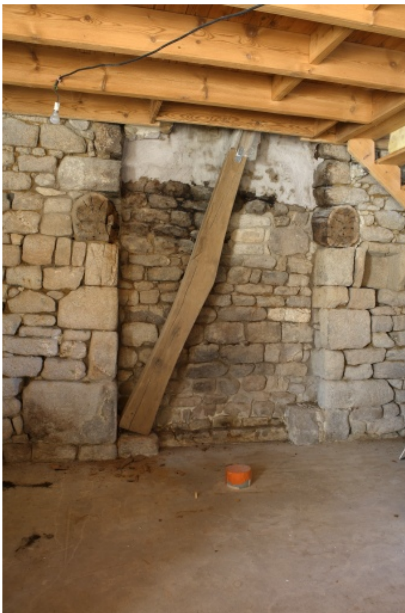
1er logis. Pignon sud. Cheminée.
