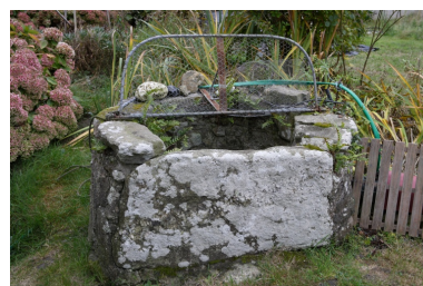
Puits. Phot. Denis Pillet IVR52_20074401690NUCA
