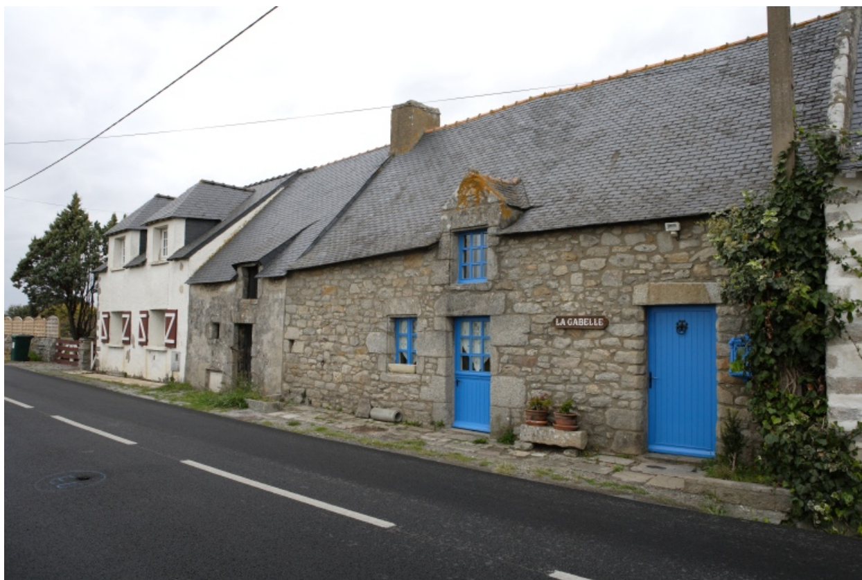
Vue d'ensemble des 6 et 7e logis.
