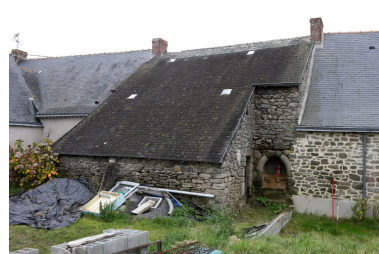
4e logis. Porte du logis et porte de l'appentis. Phot. Denis Pillet IVR52_20074401688NUCA
