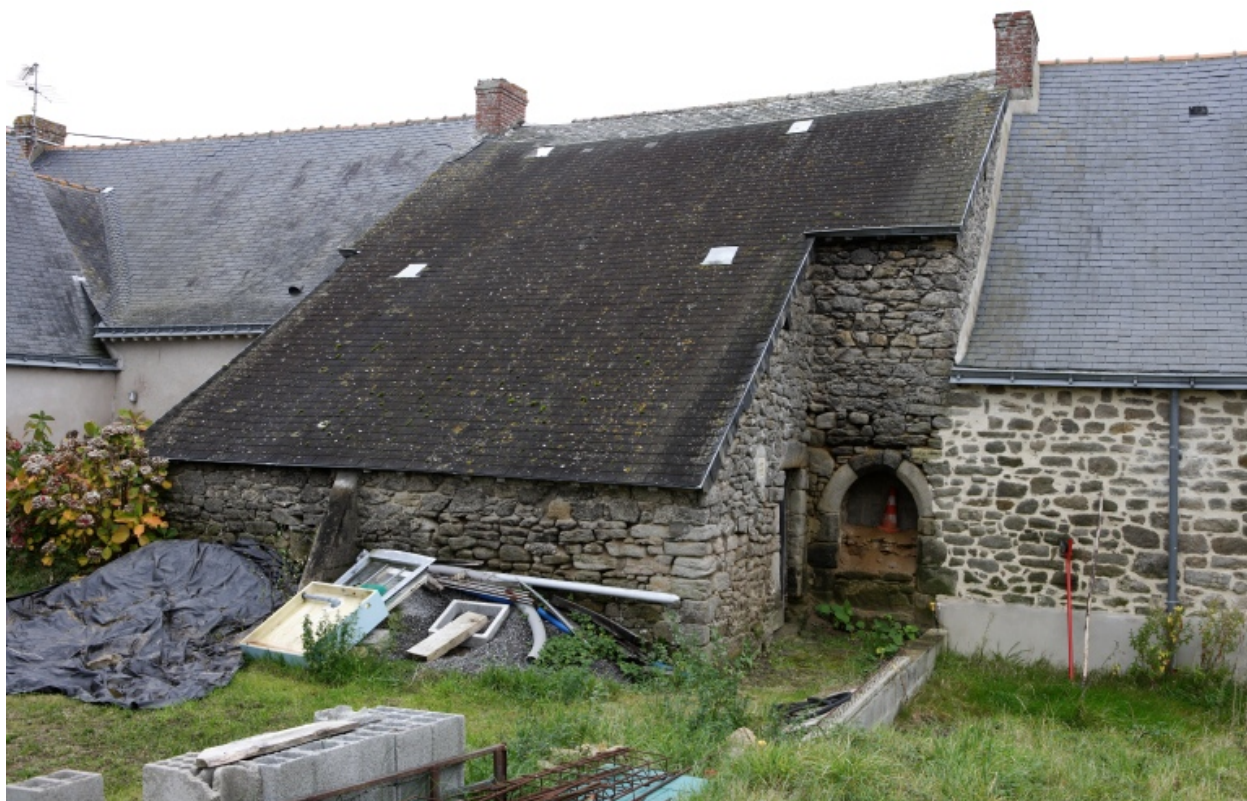
4e logis. Porte du logis et porte de l'appentis.
