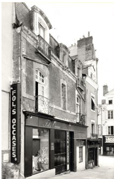
Elévation antérieure. Phot. Patrice Giraud IVR52_19834901799V
