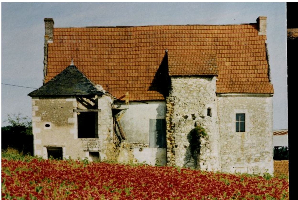
Le logis avant restauration. Photographie (collection particulière).
