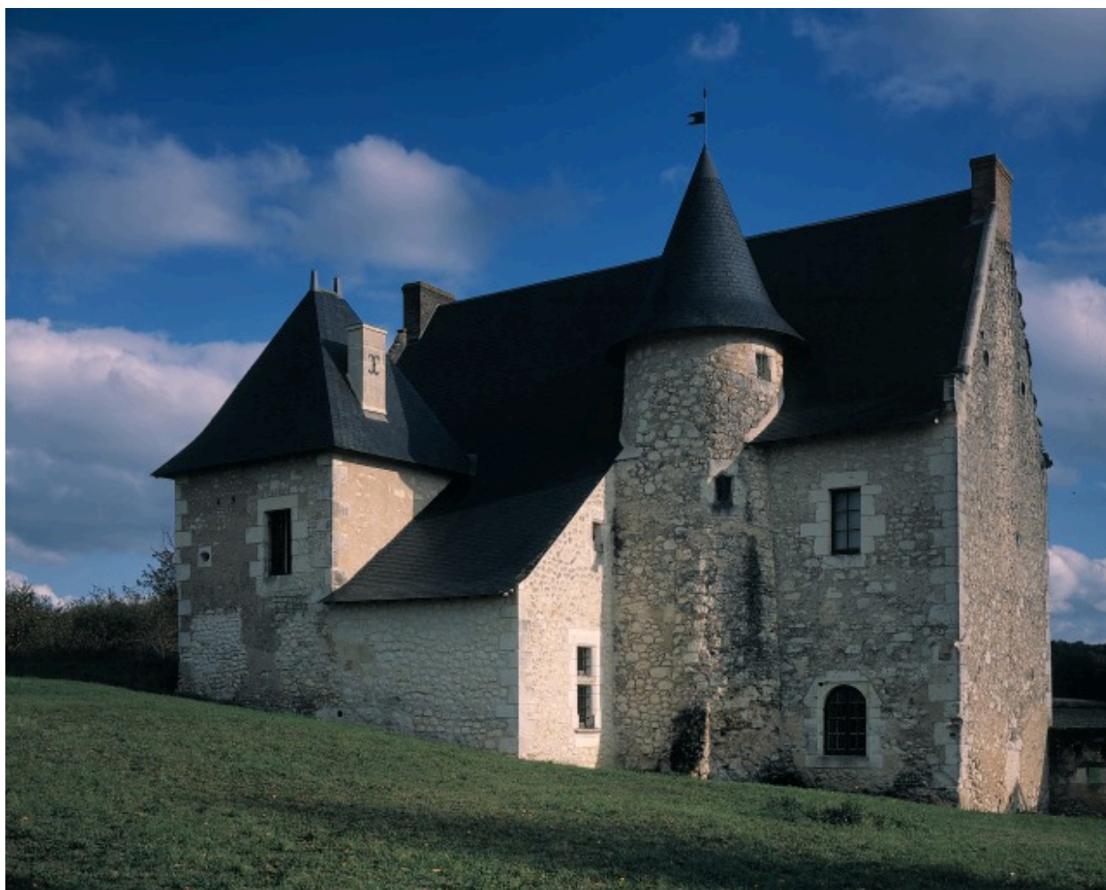
Vue de volume de la façade postérieure.
