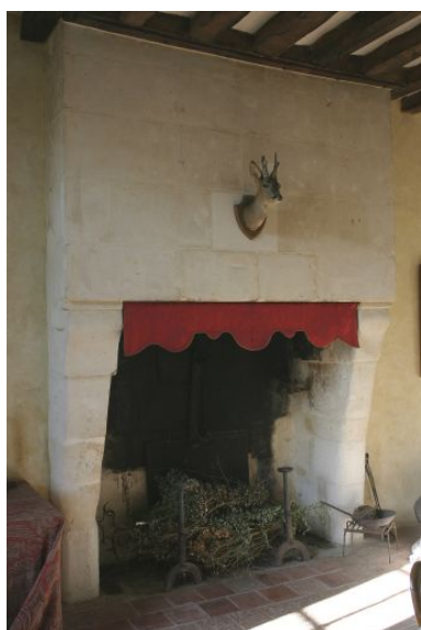
Salle ouest au rez-de- chaussée : cheminée. Phot. Jean-Baptiste Darrasse IVR52_20047204064NUCA
