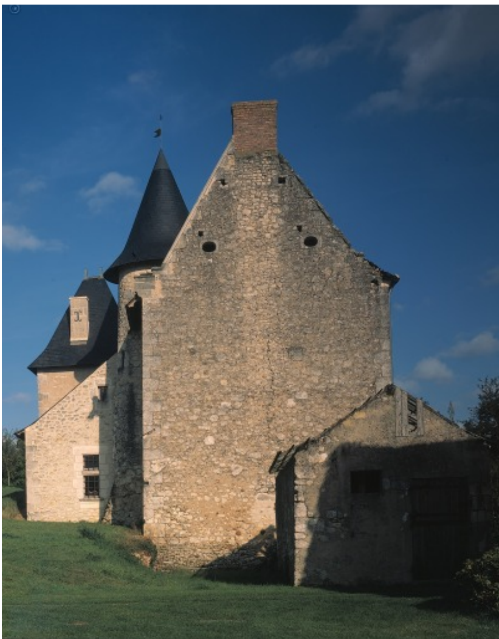
Pignon ouest du logis.
