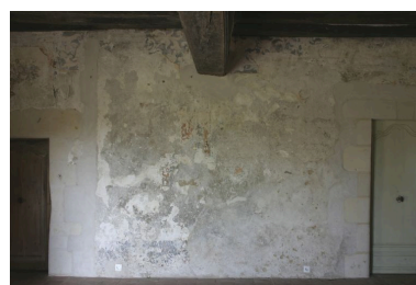
Rez-de-chaussée du logis, salle est : mur nord. Phot. Jean-Baptiste Darrasse IVR52_20047204059NUCA
