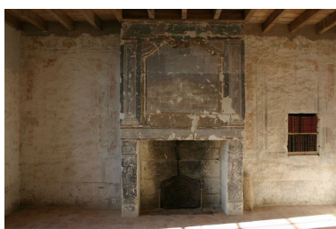
1er étage, salle ouest : cheminée. Phot. Jean-Baptiste Darrasse IVR52_20047204065NUCA
