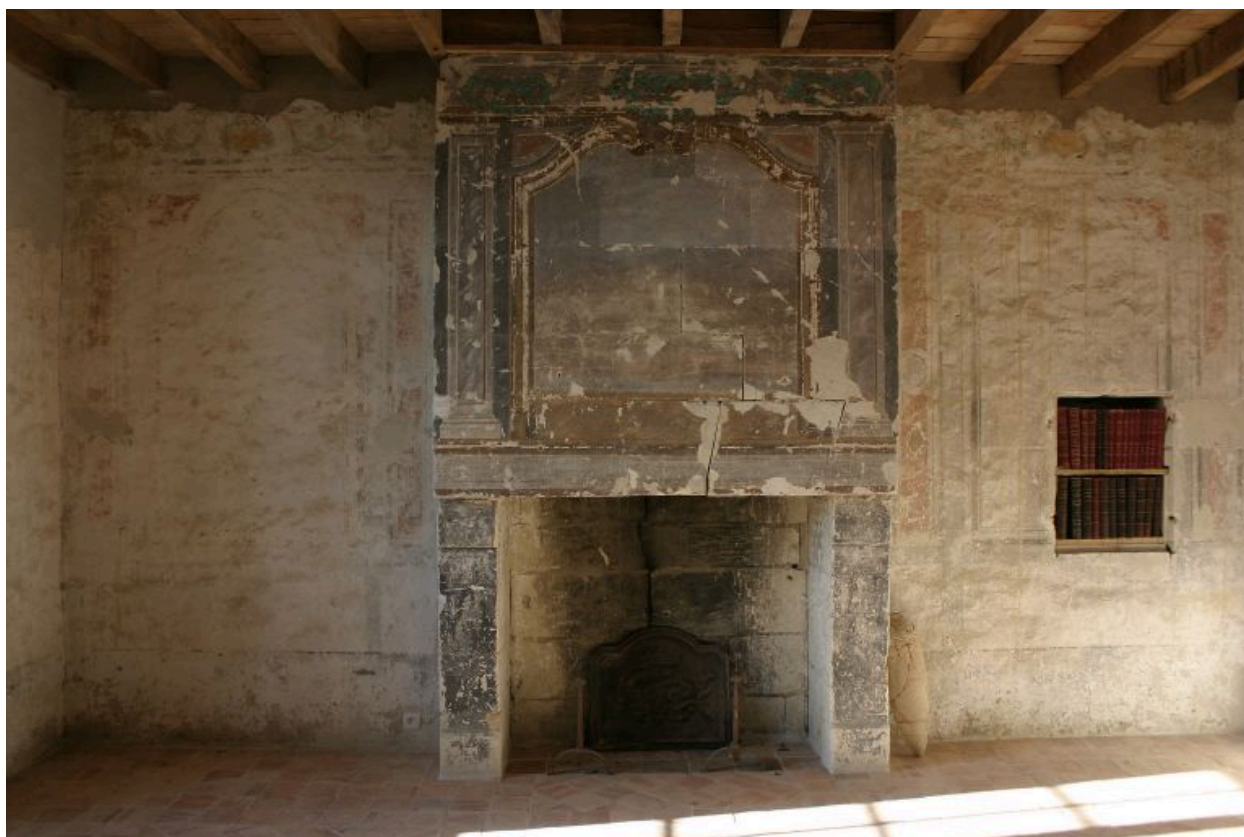
1er étage, salle ouest : cheminée.
