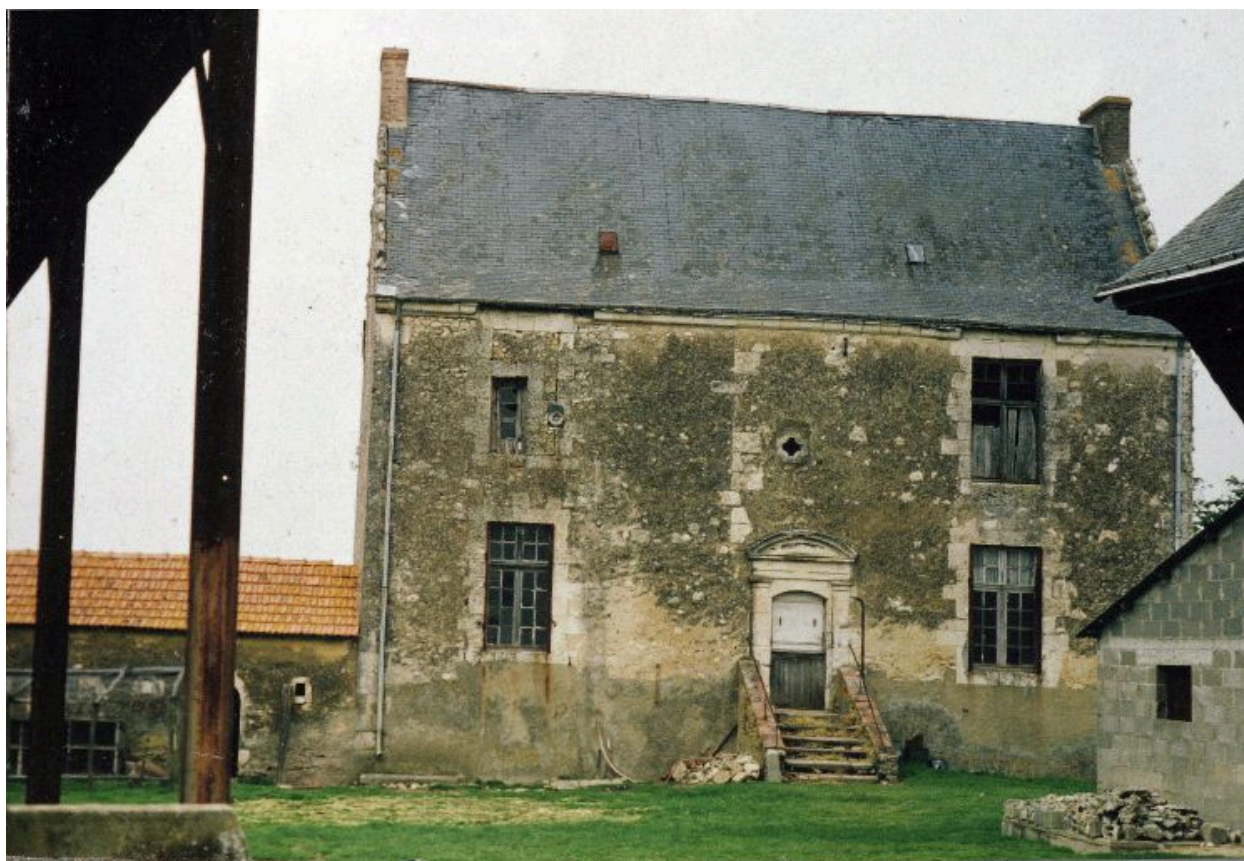
Le logis avant restauration. Photographie (collection particulière).
