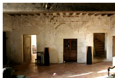
Rez-de-chaussée du logis, salle est : mur de refend avec des traces de peintures murales. Phot. Jean-Baptiste Darrasse IVR52_20047204054NUCA
