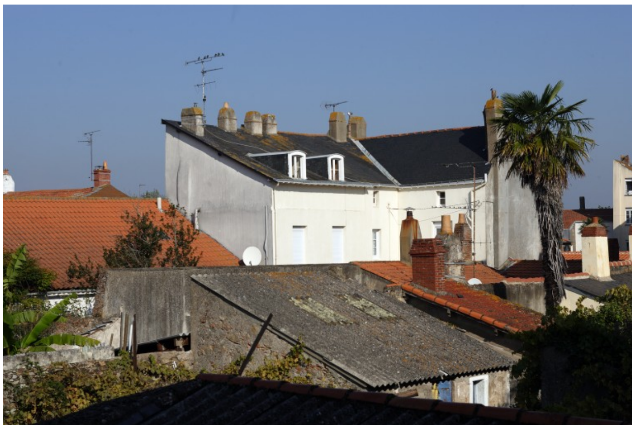
Les façades postérieures.
