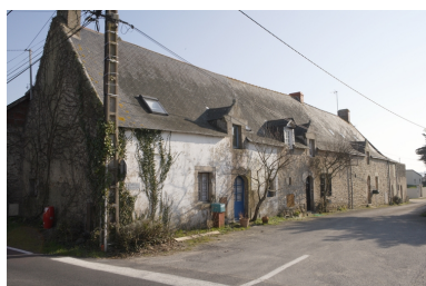
Mouzac, rangée d'habitations, vue vers le sud-est. Phot. Denis Pillet IVR52_20084400335NUCA
