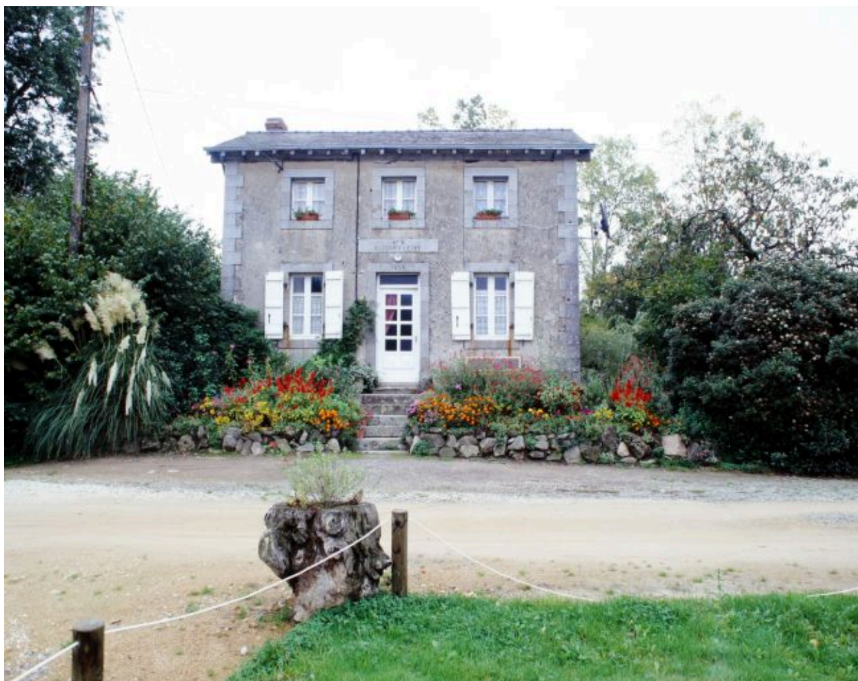
La maison éclusière.
