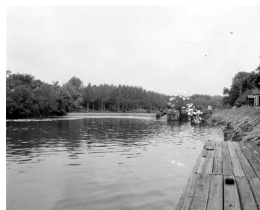
Vue d'ensemble du site d'écluse depuis le ponton situé en aval sur la rive gauche : barrage, centrale hydroélectrique, écluse, transformateur. Phot. François Lasa IVR52_20015300555X
