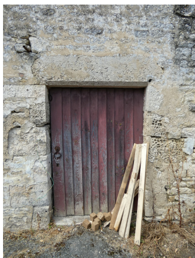
La porte de la remise, à linteau chanfreiné. Phot. Yannis Suire IVR52_20228501570NUCA
