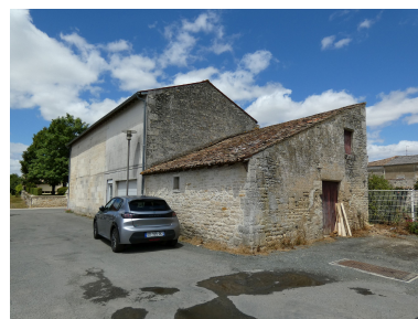
La remise vue depuis le sud. Phot. Yannis Suire IVR52_20228501569NUCA
