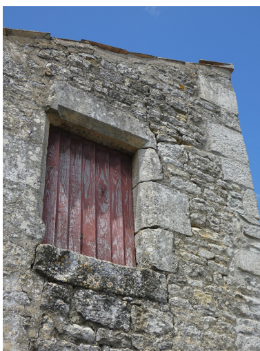
La baie de la remise, à encadrement chanfreiné. Phot. Yannis Suire IVR52_20228501571NUCA
