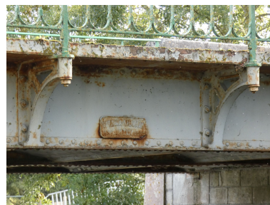
La marque du fondeur sur la poutre en fonte côté sud. Phot. Yannis Suire IVR52_20228500308NUCA
