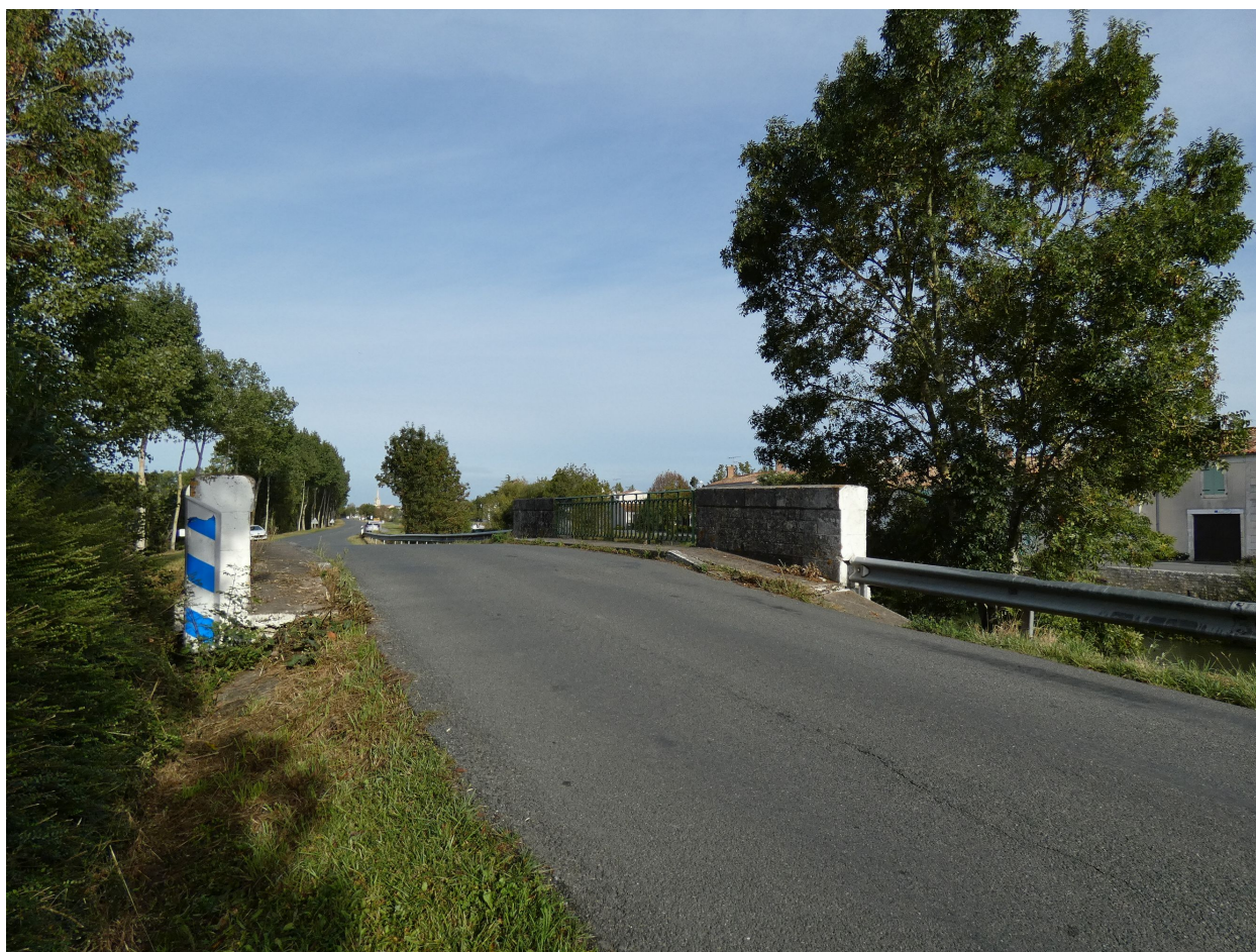
Le pont vu depuis le sud-est.
