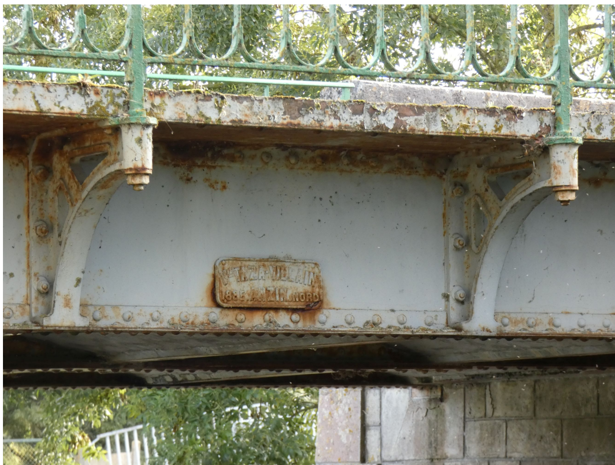
La marque du fondeur sur la poutre en fonte côté sud.
