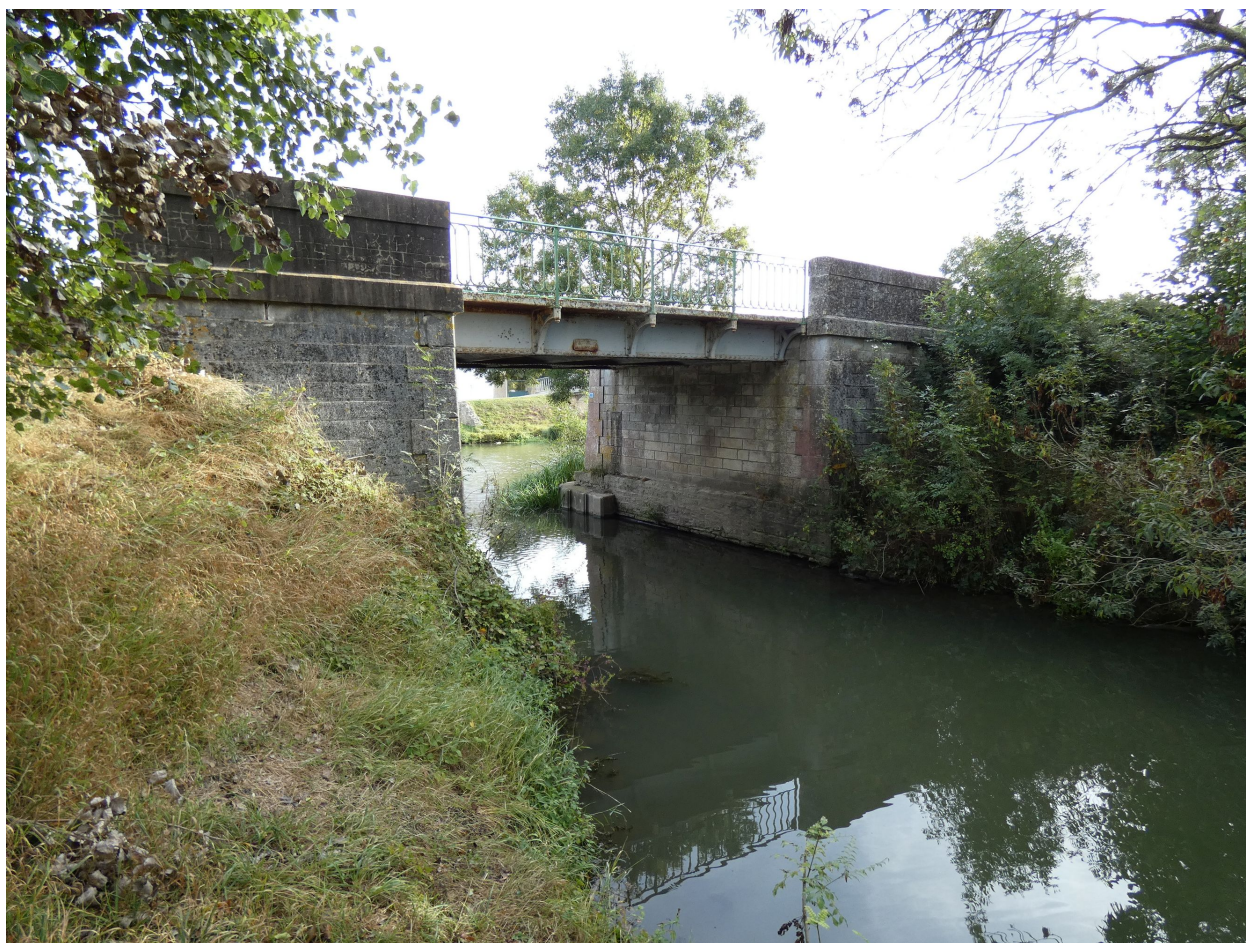
Le pont vu depuis le sud-ouest.
