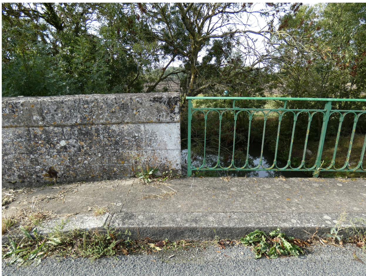
Détail de parapet et de garde-corps.
