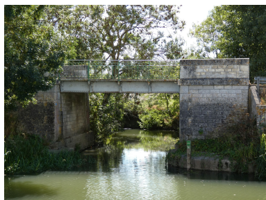
Le pont vu depuis la rive opposée de la Sèvre Niortaise, au nord. Phot. Yannis Suire IVR52_20228500297NUCA
