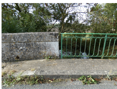
Détail de parapet et de garde-corps. Phot. Yannis Suire IVR52_20228500319NUCA
