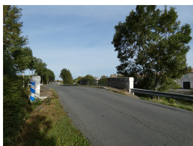
Le pont vu depuis le sud-est. Phot. Yannis Suire IVR52_20228500320NUCA
