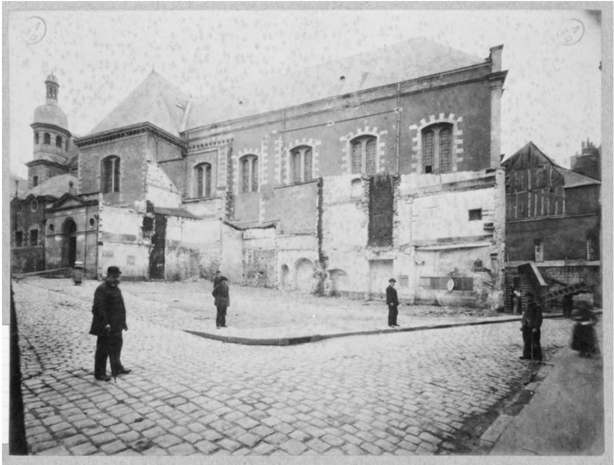
Façade latérale gauche après la démolition des maisons accolées à la nef, fotogr., [v. 1898].
