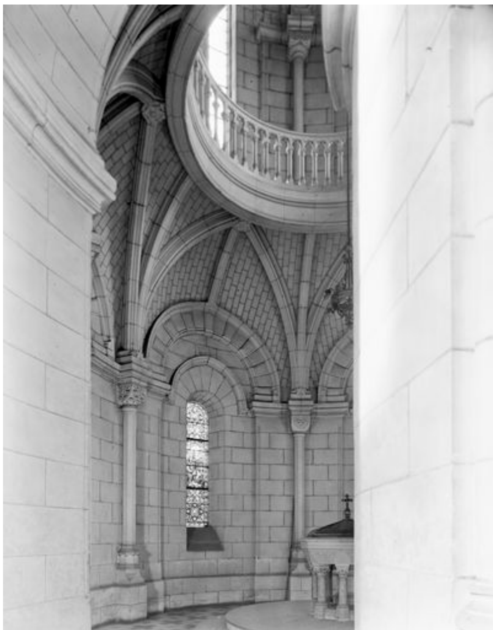
Chapelle située à gauche (à l'est) du porche d'entrée : élévation intérieure, niveau inférieur, avec vue partielle de la voûte à éclairage zénithal.
