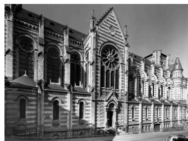
Façade latérale gauche (est). Phot. François Lasa IVR52_19974900398V
