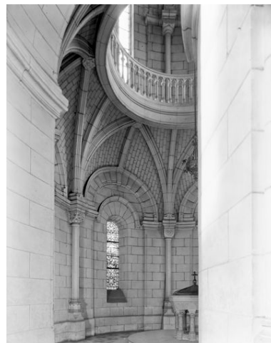
Chapelle située à gauche (à l'est) du porche d'entrée : élévation intérieure, niveau inférieur, avec vue partielle de la voûte à éclairage zénithal. Phot. François Lasa IVR52_19754902259V
