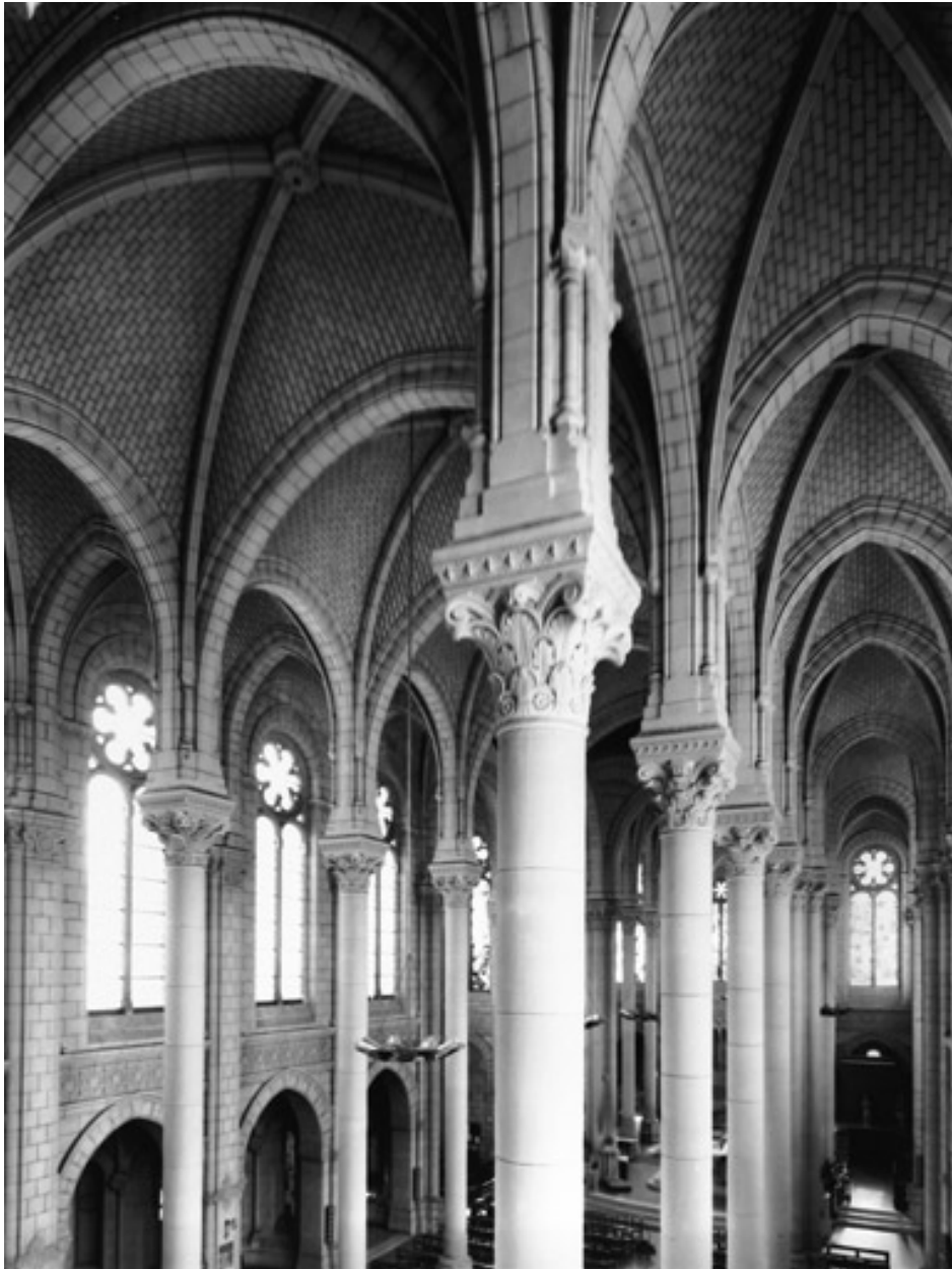
Vue intérieure de la nef et des collatéraux, depuis la tribune à l'entrée de la nef.
