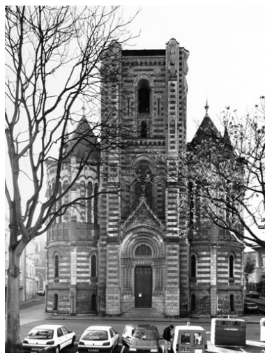
Façade antérieure (nord).
