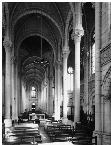
Vue intérieure du transept et de la nef, depuis le chœur. Phot. François Lasa IVR52_19974900400V
