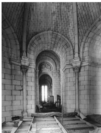
Tribune : vue d'ensemble en axe ouest-est. Phot. François Lasa IVR52_19974900404V
