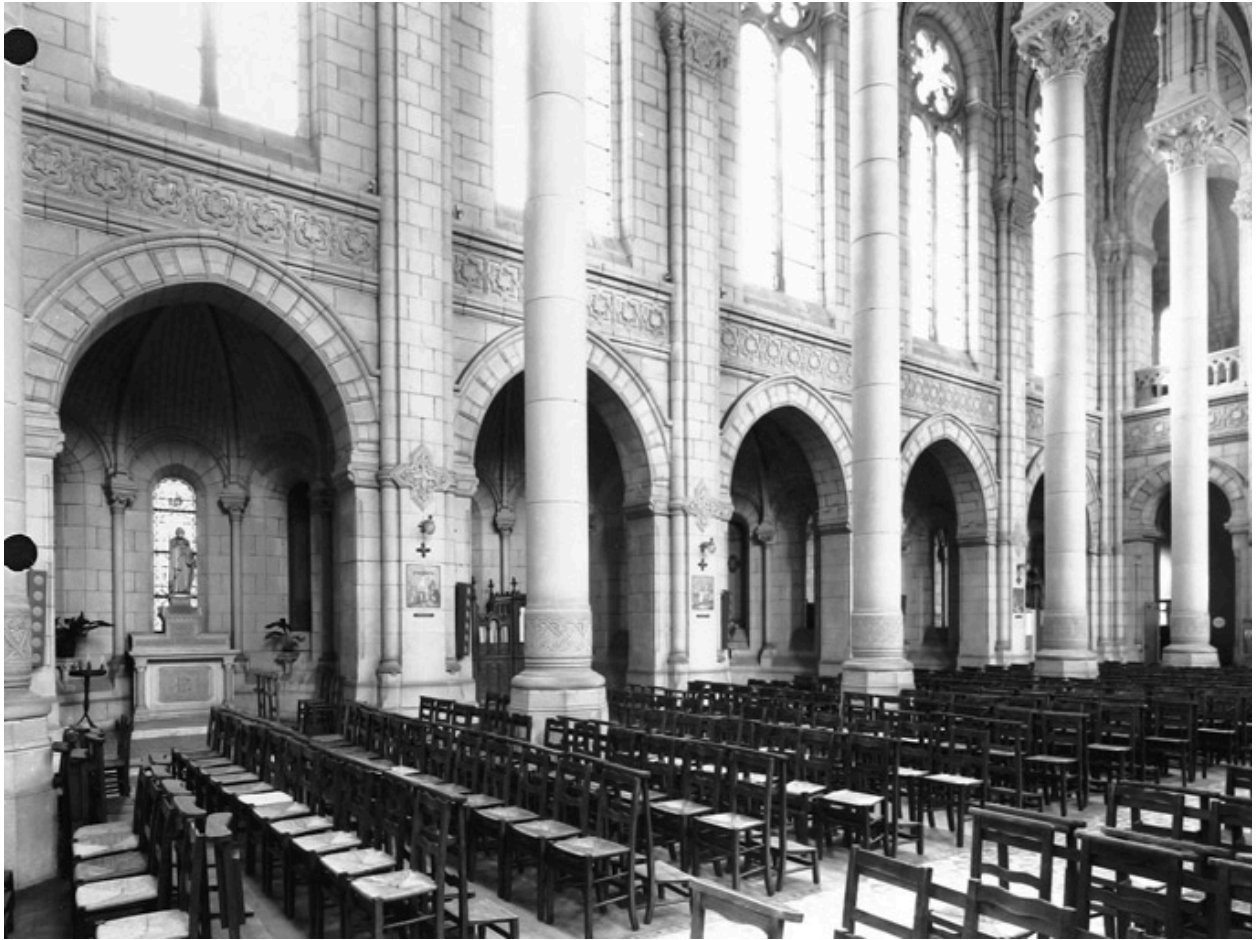
Nef, élévation intérieure droite (ouest), premier niveau : vue d'ensemble des chapelles.
