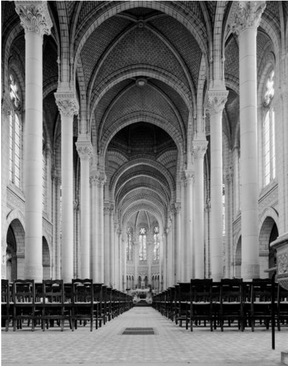
Vue d'ensemble de la nef en axe nord-sud, vers le chœur.
