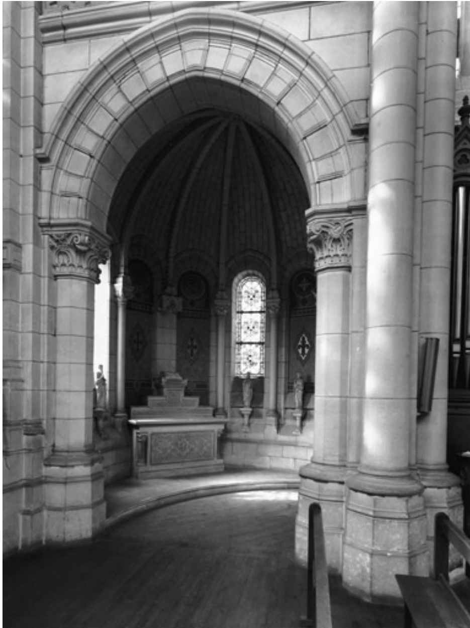
Chevet : chapelle à droite (à l'ouest) du chœur : vue d'ensemble depuis le chœur.
