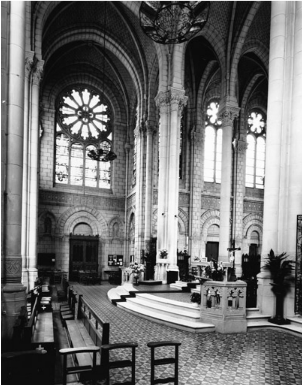
Vue intérieure du bras gauche du transept et de l'entrée du chœur, depuis le bras droit.
