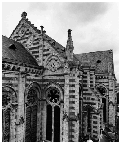
Chevet : angle sud-est, partie haute. Phot. François Lasa IVR52_19914900997X
