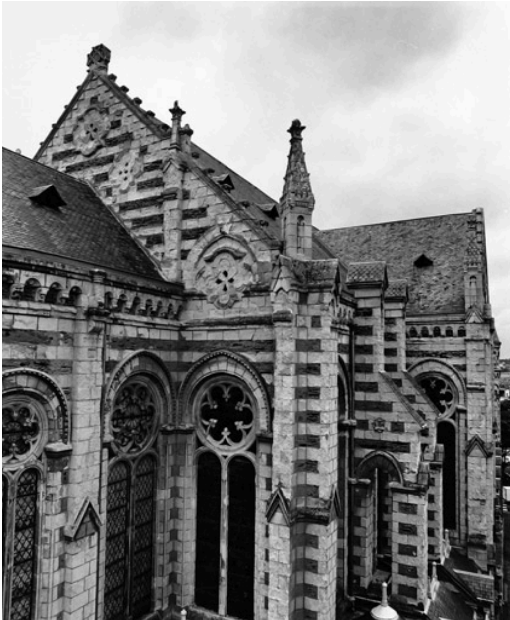
Chevet : angle sud-est, partie haute.
