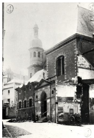
Façade latérale gauche sur la rue Flore de l'église Notre-Dame, peu avant la démolition, fotogr., [v. 1898]. Phot. Patrice (reproduction) Giraud, Phot. François Lasa IVR52_19754901990X
