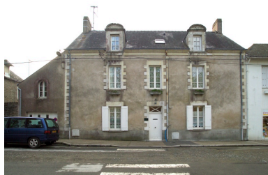
Vue de la façade sur rue.
