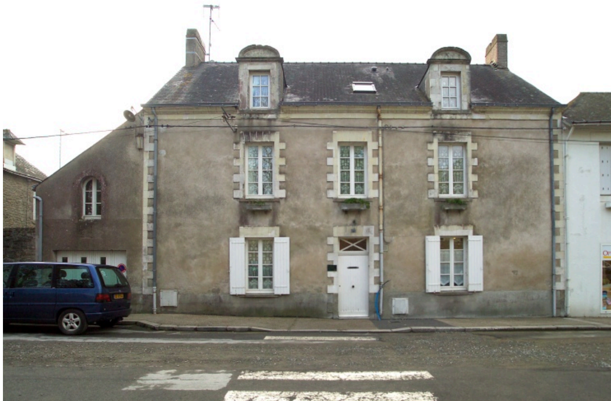
Vue de la façade sur rue.
