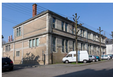
Arrière des salles de classe de l'ancienne école des filles. Phot. Denis Pillet IVR52_20134401358NUCA
