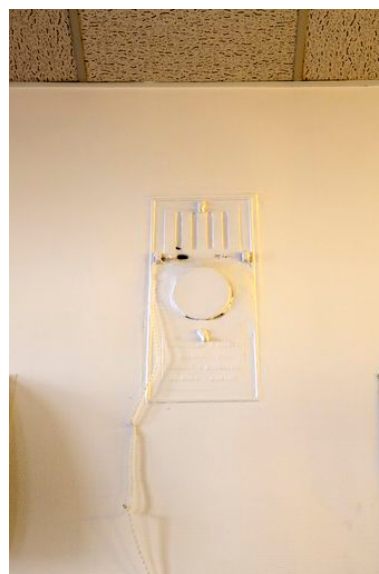
Conduit d'évacuation du poêle. Phot. Denis Pillet IVR52_20134401255NUCA
