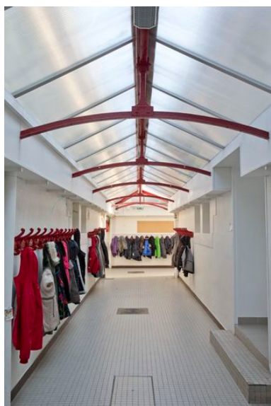
Couloir couvert desservant les salles de classe. Phot. Denis Pillet IVR52_20134401257NUCA
