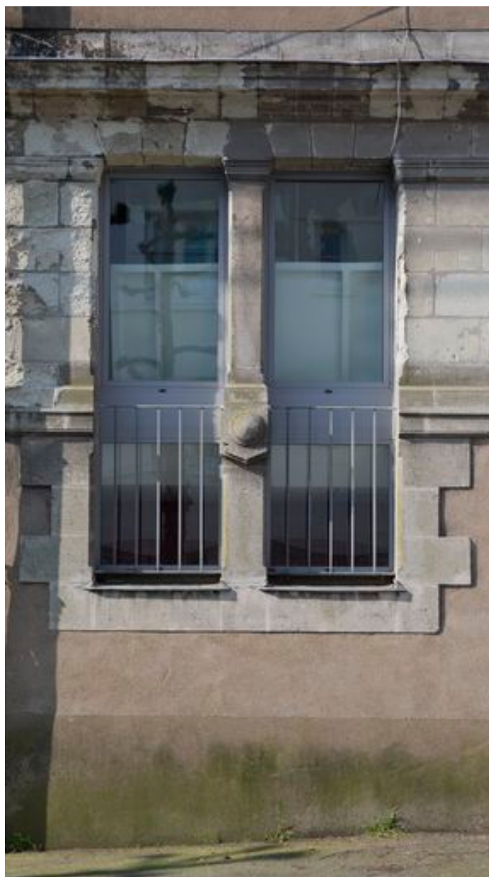
Travée du bâtiment abritant les salles de classe de l'ancienne école des filles.
