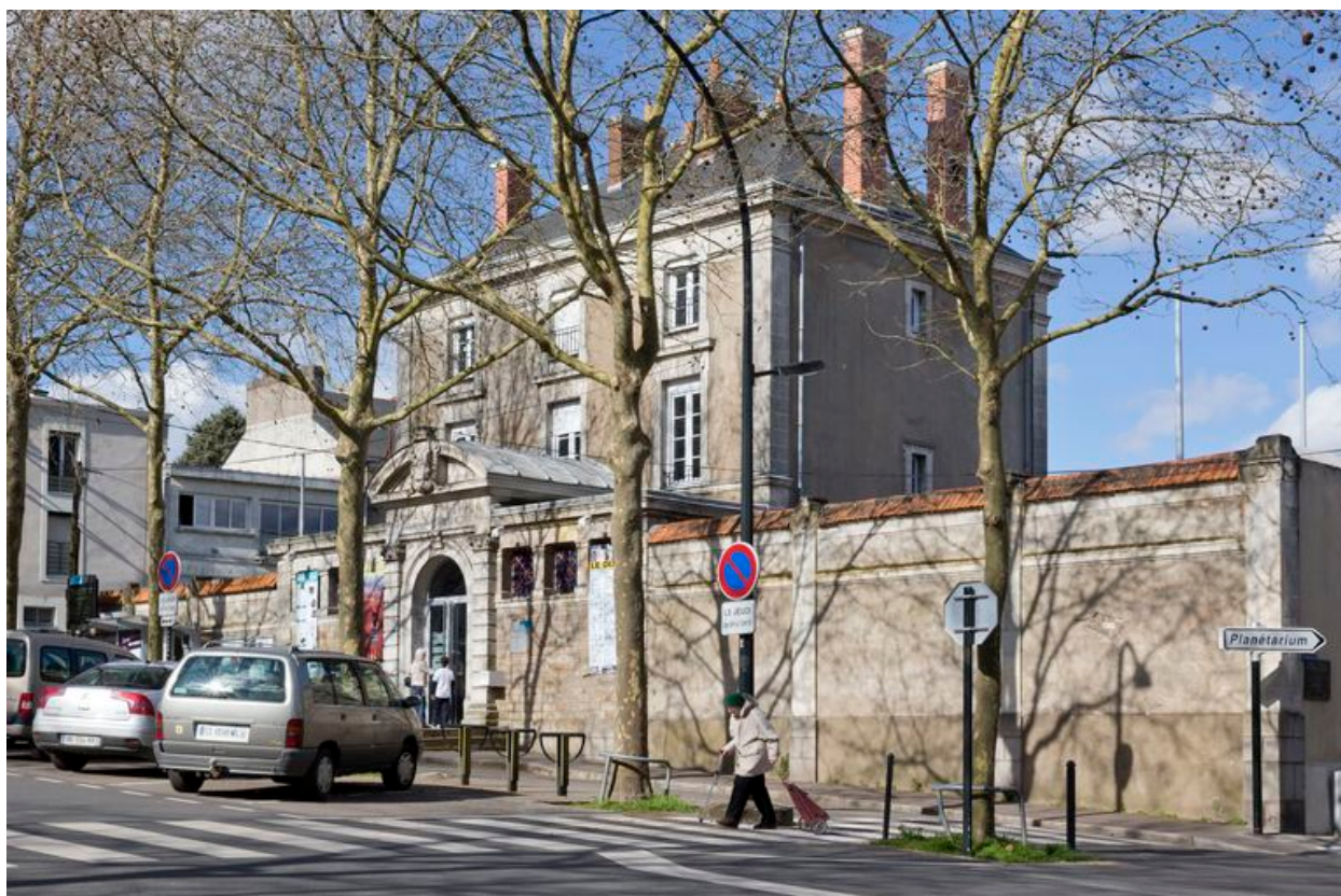
Façade côté rue de l'ancienne école de filles.
