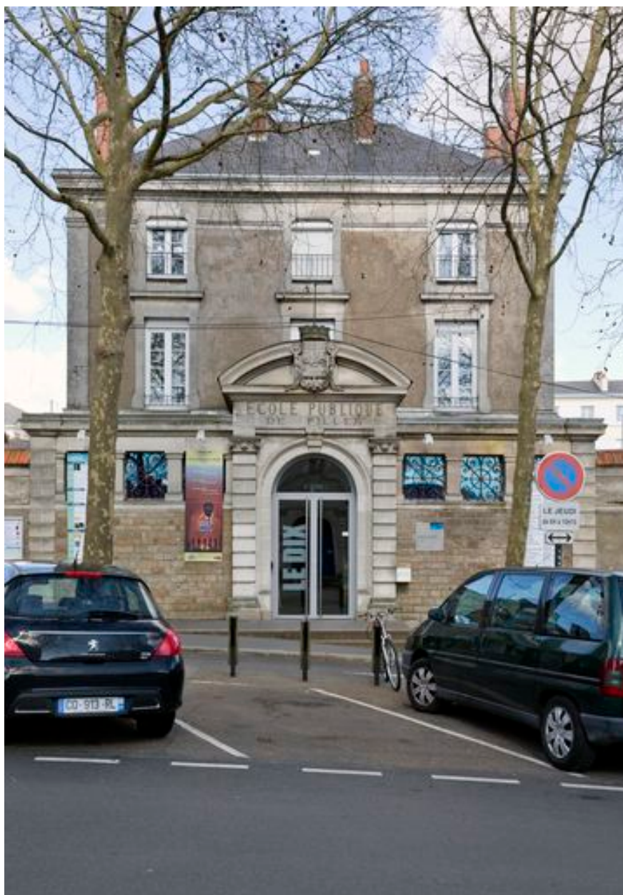
Façade côté rue de l'ancienne école de filles
