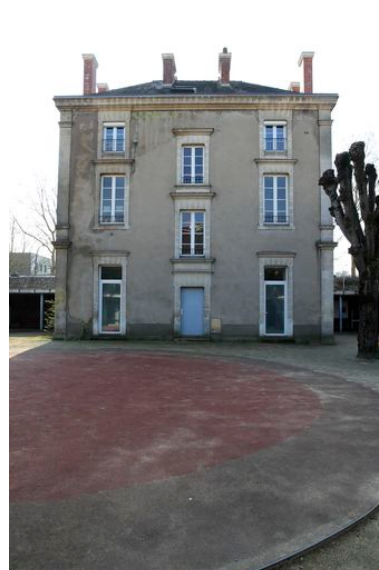
Arrière de l'ancien bâtiment de logements de l'école des filles. Phot. Denis Pillet IVR52_20134401260NUCA
