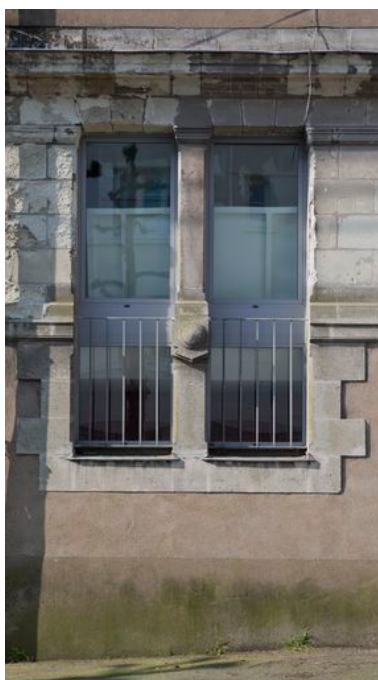
Travée du bâtiment abritant les salles de classe de l'ancienne école des filles. Phot. Denis Pillet IVR52_20134401359NUCA
