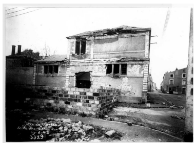
Dommages sur le bâtiment abritant les classes de l'école des filles lors des bombardements de 1943. Phot. Patrick (reproduction) Jean IVR52_20134400833NUCA
