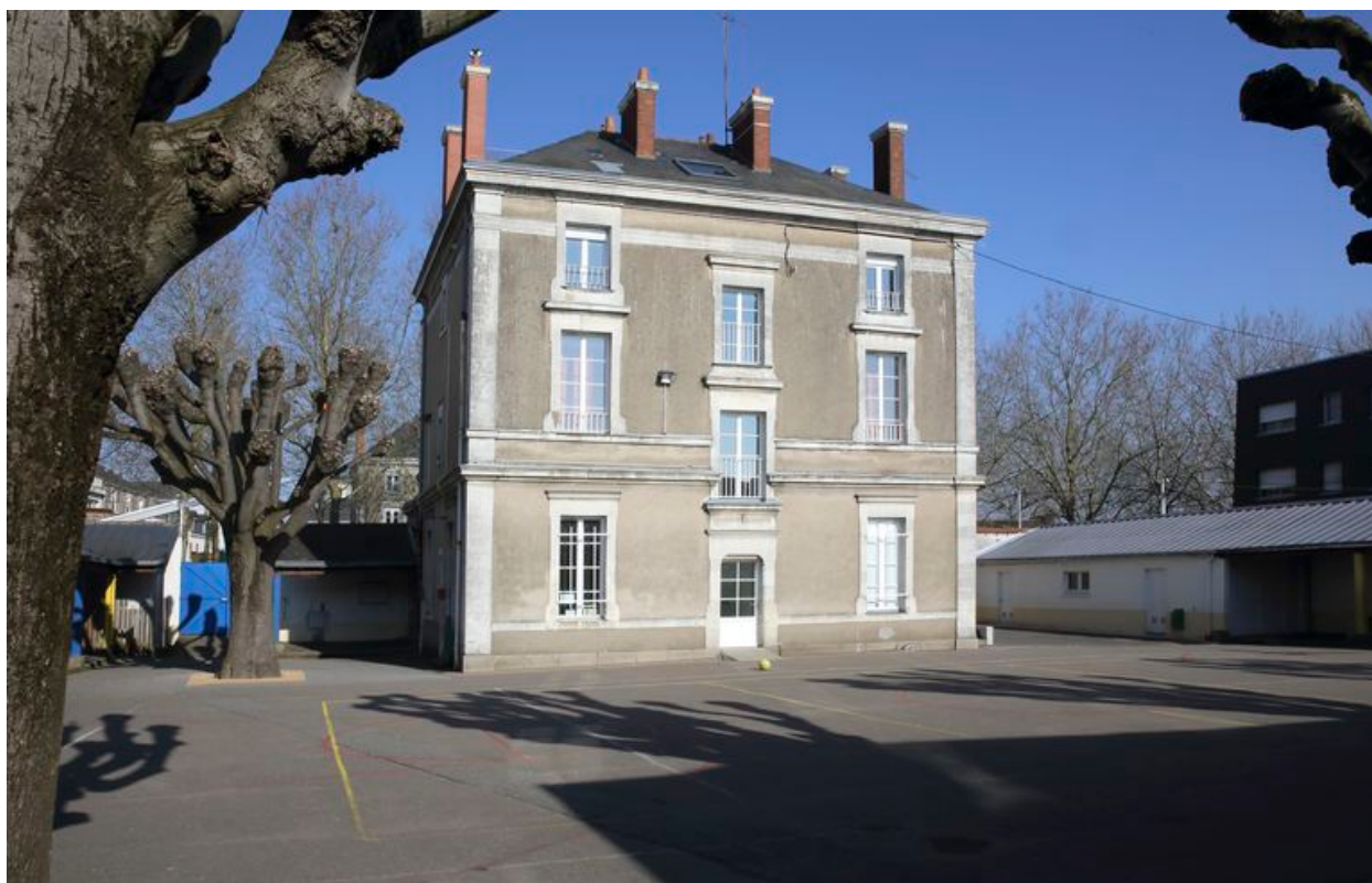
Arrière de l'ancien bâtiment de logements de l'école des garçons.
