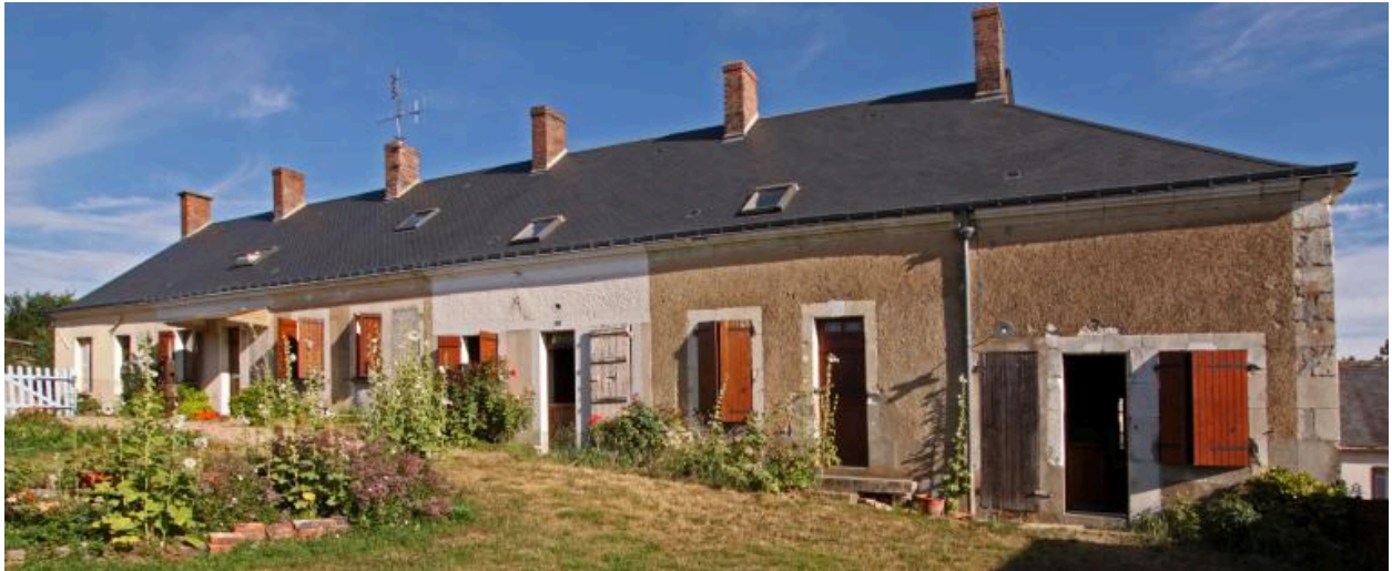
Façade sur cour.
