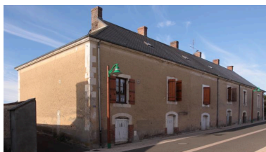
Vue de volume depuis la rue. Phot. Jean-Baptiste Darrasse IVR52_20107201318NUCA
