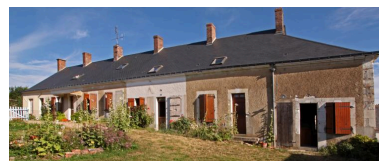
Façade sur cour. Phot. Jean-Baptiste Darrasse IVR52_20107201321NUCA
