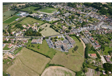
Vue aérienne de la rue Horncastle et du centre hospitalier édifié en limite de la ville. Phot. Yves Guillotin IVR52_20137201229NUCA
