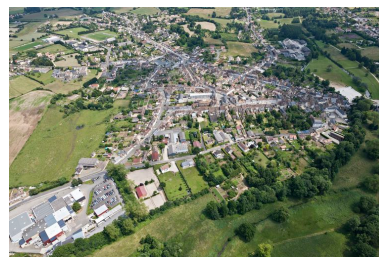
Vue aérienne de la ville haute. Phot. Yves Guillotin IVR52_20137201167NUCA
