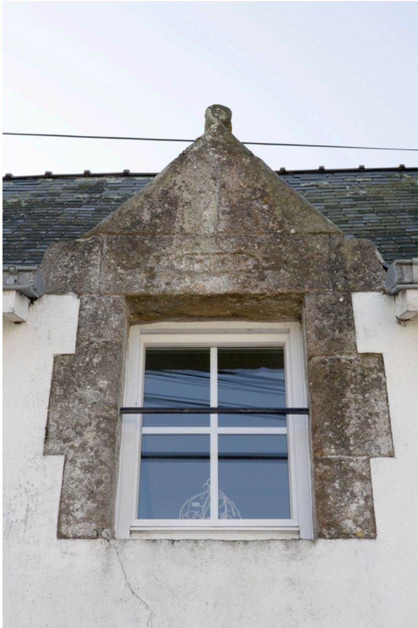
Détail de la lucarne datée 1701.
