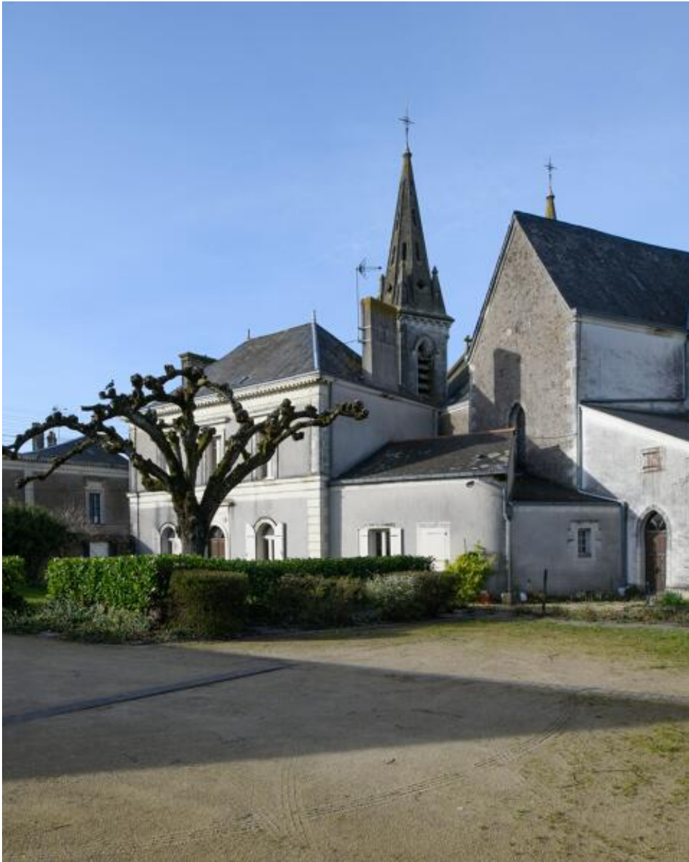
Vue générale depuis l'est.
