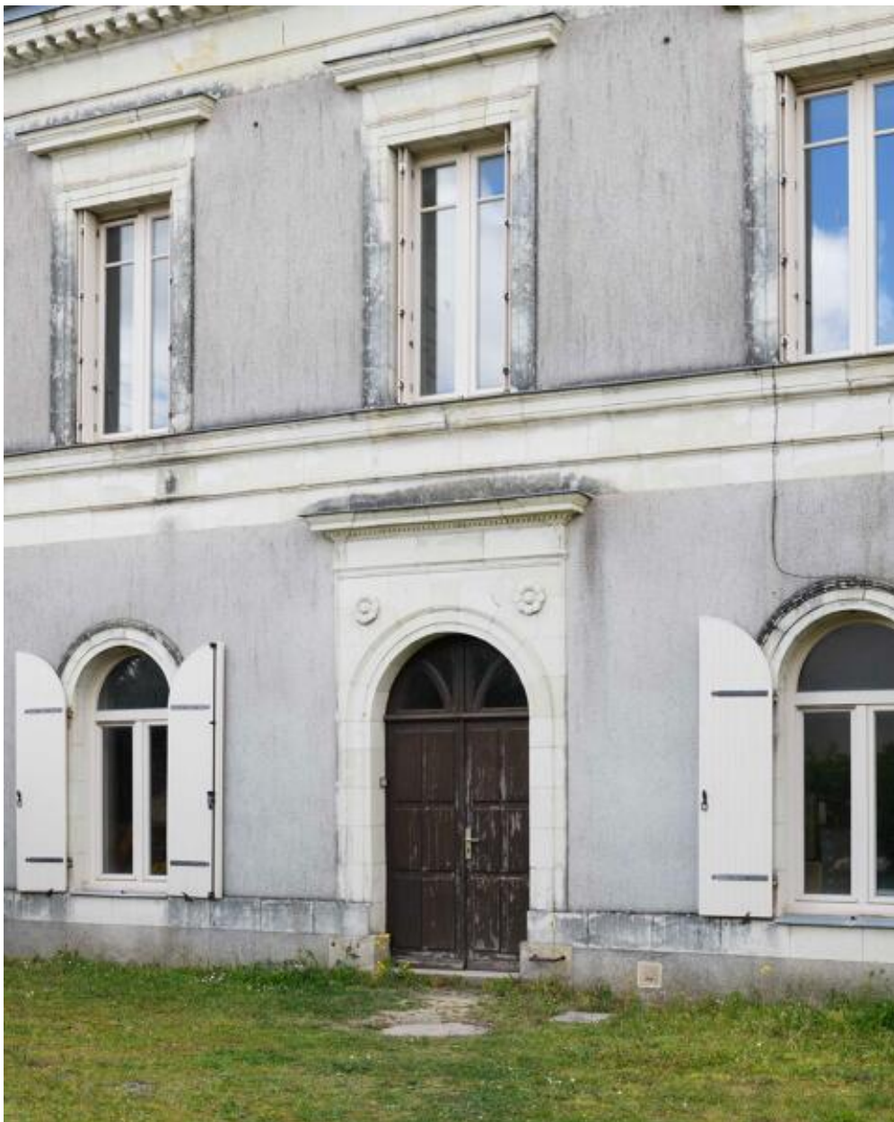
Partie centrale de la façade principale.
