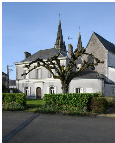
Façade principale. Phot. Armelle Maugin IVR52_20244900433NUCA
