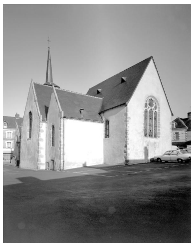
Vue d'ensemble depuis le sud-est : chœur, sacristie et chapelle sud. Phot. François Lasa IVR52_19855300003V
