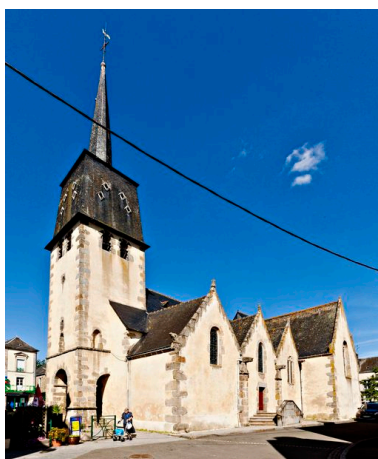
Vue d'ensemble depuis le sud-ouest en 2015. Phot. Yves Guillotin IVR52_20155300100NUCA
