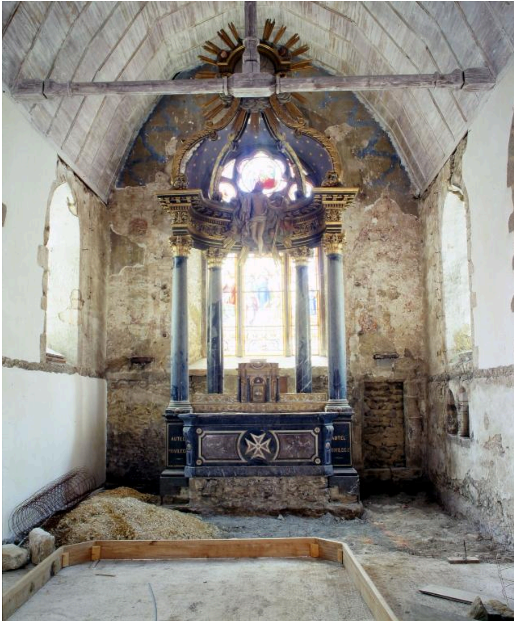
Vue d'ensemble du chœur, pendant la restauration de l'église.
