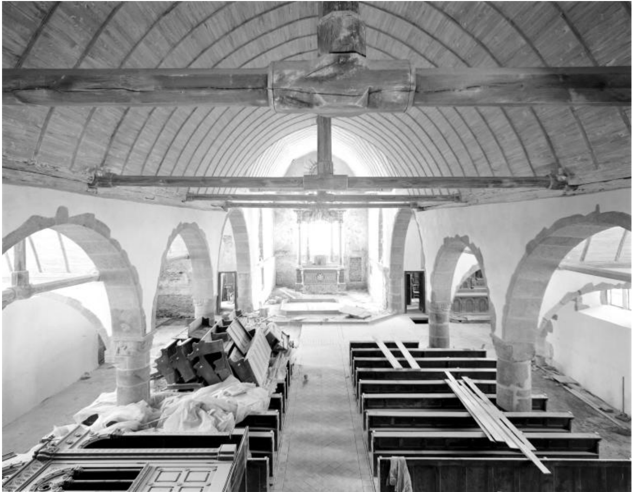
Vue de la nef et du chœur depuis la tribune, pendant la restauration de l'église.
