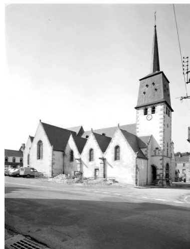
Vue d'ensemble depuis le nord-ouest. Phot. François Lasa IVR52_19855300120V
