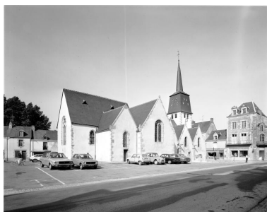
Vue d'ensemble depuis le nord-est. Phot. François Lasa IVR52_19855300121V
