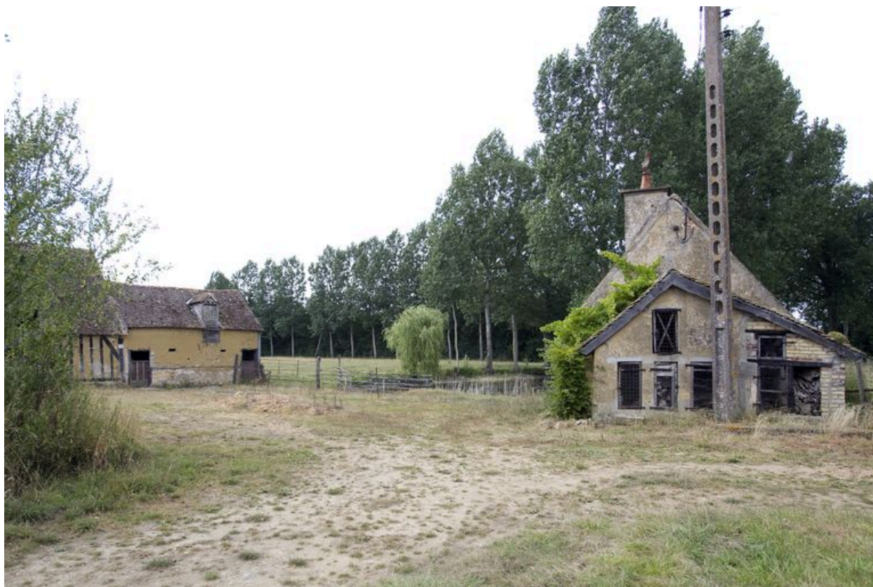
Ferme de type II : Le Mortier l'Âne, vue générale.
