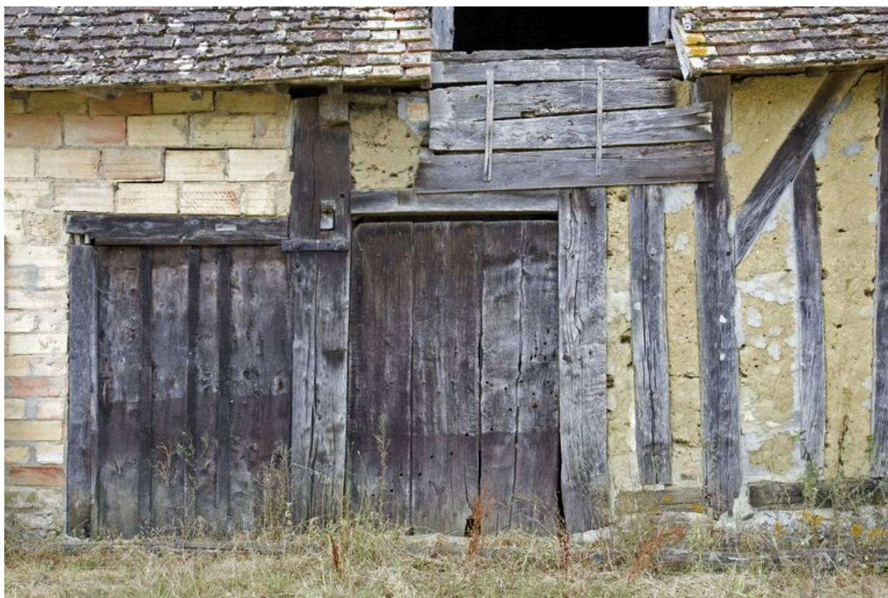
Étables de la ferme du Mortier l'Âne : détail de l'élévation sur cour.
