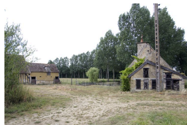
Ferme de type II : Le Mortier l'Âne, vue générale. Phot. François Lasa IVR52_20087201396NUCA
