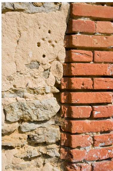
Logis de la Mandinière : détail du chambranle en briques de la porte. Phot. Yves Guillotin IVR52_20107202351NUCA
