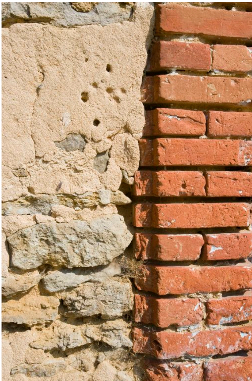
Logis de la Mandinière : détail du chambranle en briques de la porte.
