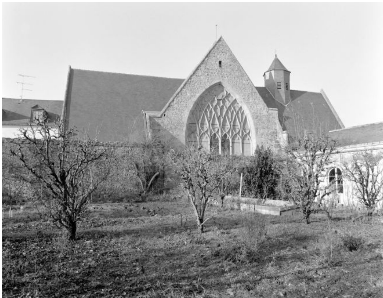
Eglise, chevet : vue d'ensemble depuis le jardin du presbytère.
