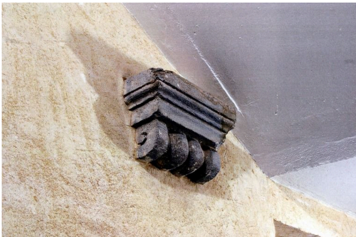
Couvent, bâtiment nord-ouest, cage d'escalier, premier étage, vue de détail : console.
