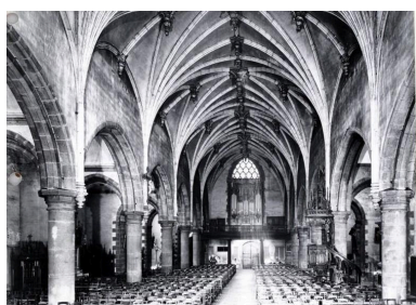
Eglise, nef : vue d'ensemble depuis le chœur. Phot. Jacques Le Callonnec IVR52_19835300009V
