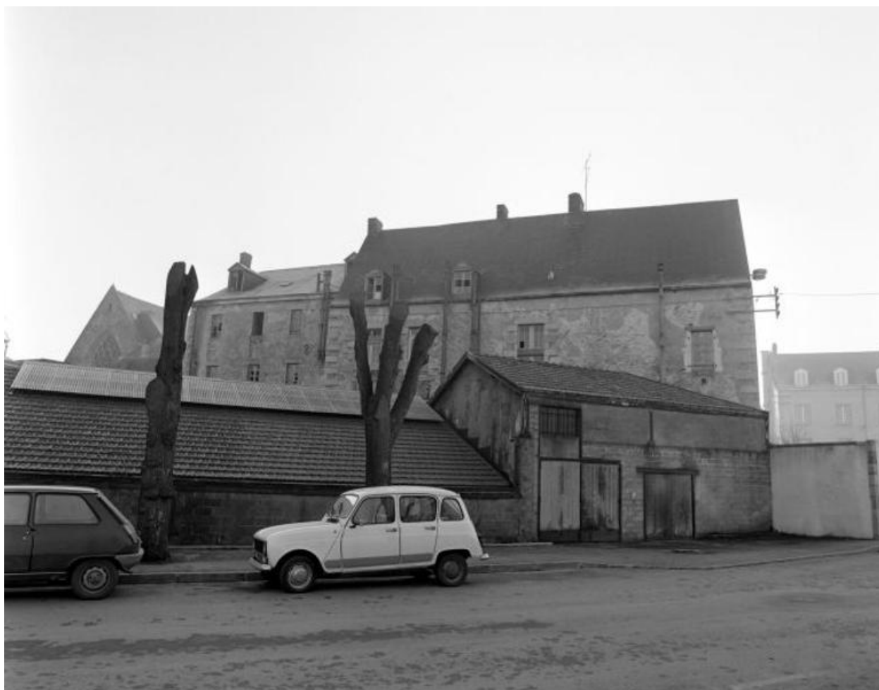
Couvent, corps de logis, aile en retour d'équerre nord-ouest, élévation extérieure : vue d'ensemble.
