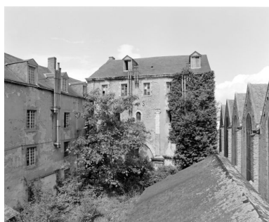
Couvent, élévations sud-ouest et nord-ouest sur cour : vue d'ensemble.
