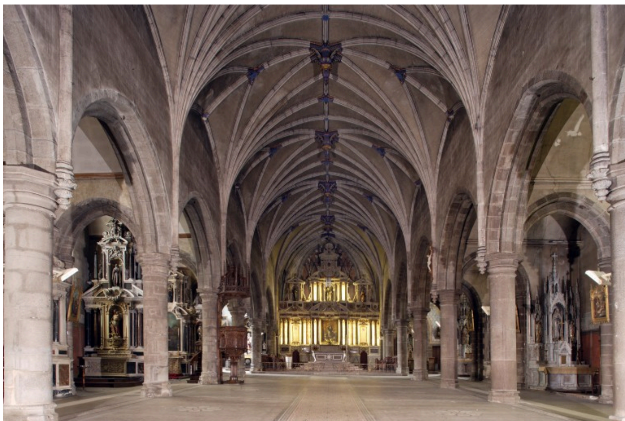
Eglise, nef : vue d'ensemble vers le chœur.
