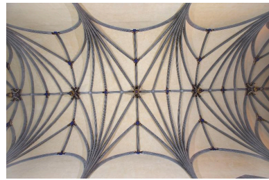
Eglise, nef, voûte après son nettoyage : vue géométrale. Phot. François Lasa IVR52_20065300194NUCA
