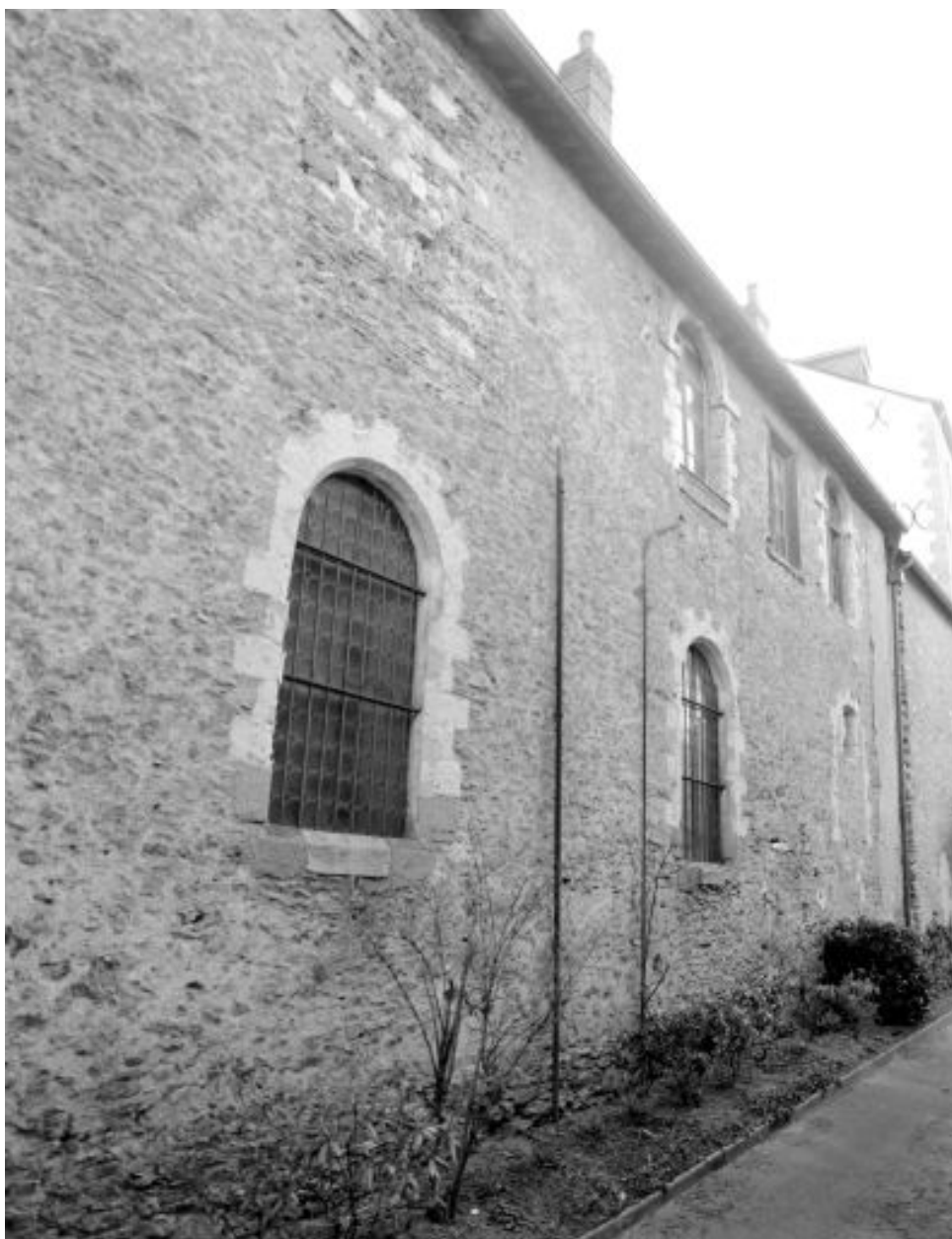
Eglise, élévation ouest : vue d'ensemble.
