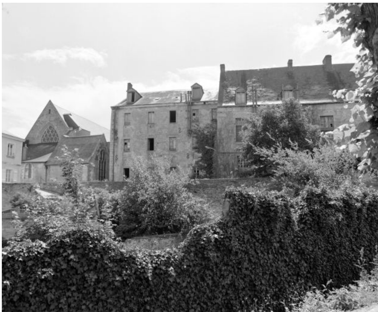
Vue prise de l'entrée de la caserne : à gauche pignon de l'entrée de l'église.
