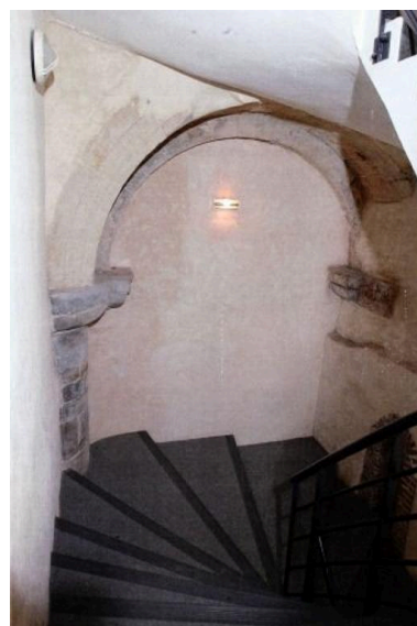
Couvent, bâtiment nord-ouest, cage d'escalier entre le rez-de-chaussée et le premier étage, vue de détail : arcade. Phot. François Lasa IVR52_20035300350NUCA
