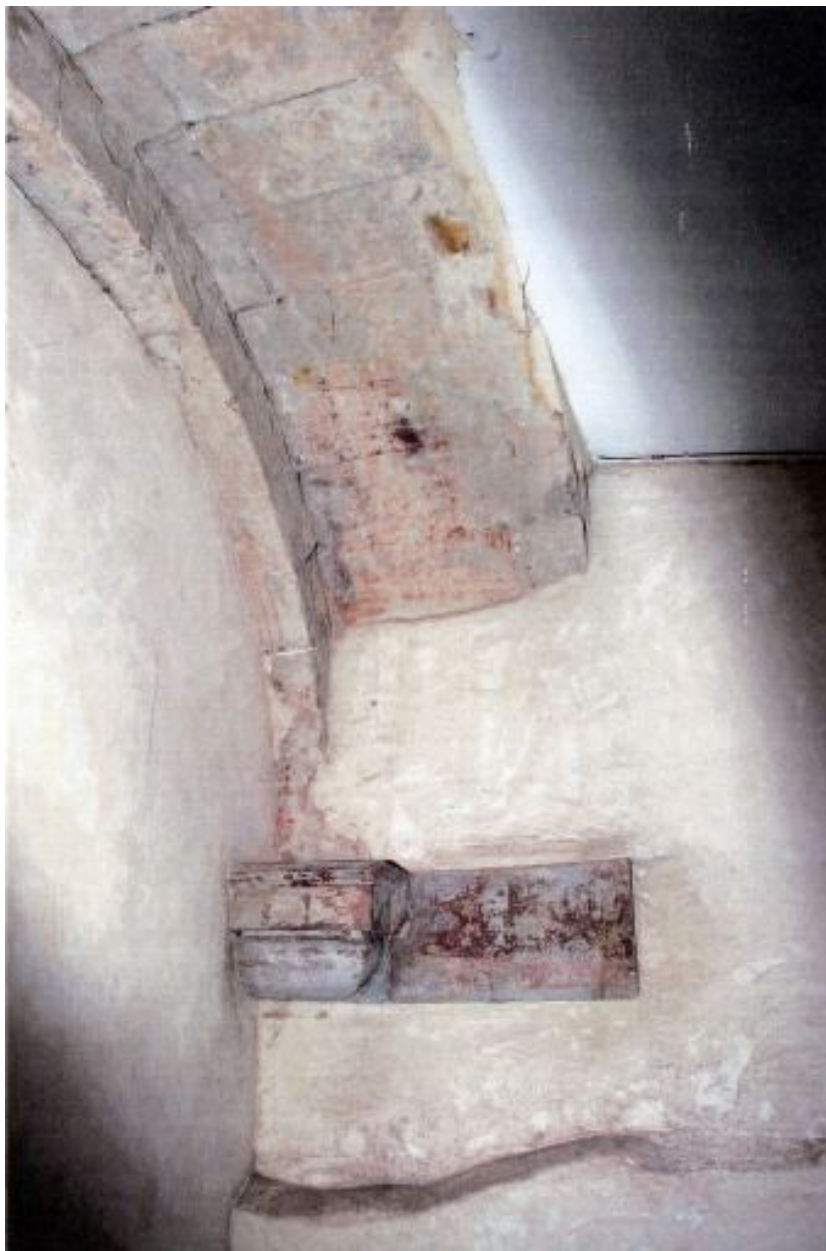
Couvent, bâtiment nord-ouest, cage d'escalier entre le rez-de-chaussée et le premier étage, arcade, vue de détail : chapiteau et arc.
