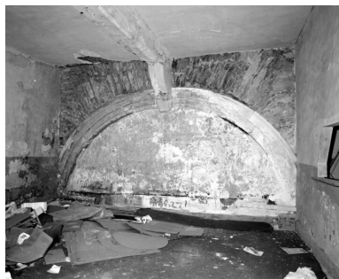
Couvent, aile nord-ouest, vue de détail : arcade. Phot. François Lasa IVR52_19985300147X
