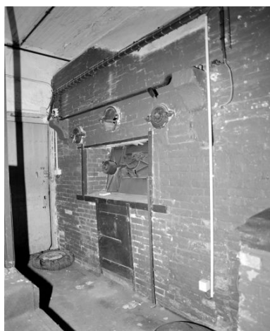
Couvent, aile nord-ouest, four à pains, vue de détail : partie gauche. Phot. François Lasa IVR52_19985300149X
