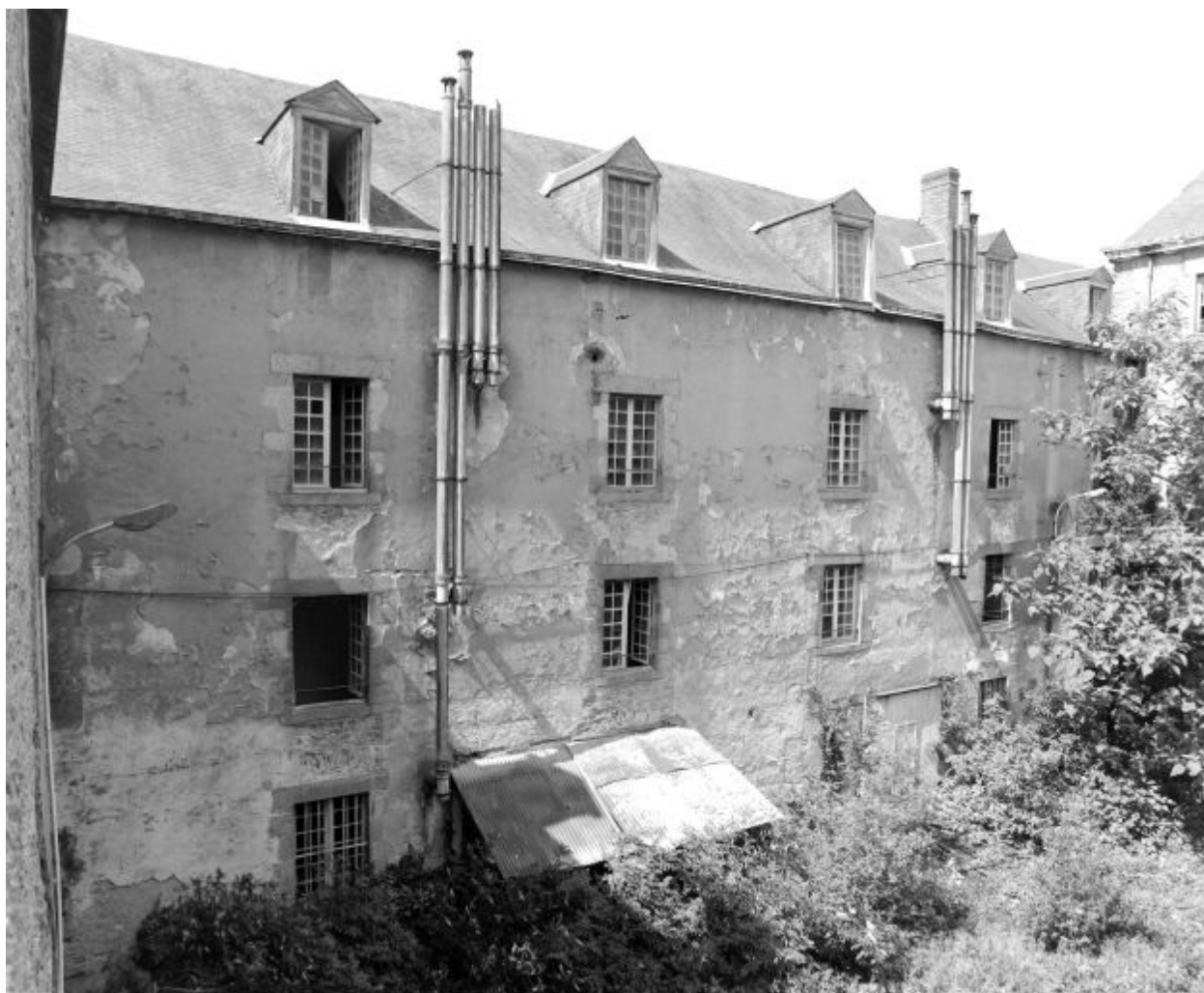
Couvent, élévation sud-ouest sur cour : vue d'ensemble.
