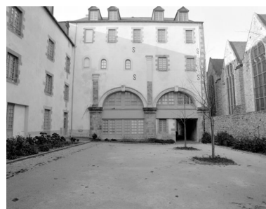
Couvent, élévation nord-ouest sur cour (après restauration) : vue d'ensemble.
