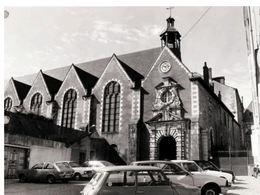
Eglise, élévation nord : vue d'ensemble. Phot. François Lasa IVR52_19855300304X
