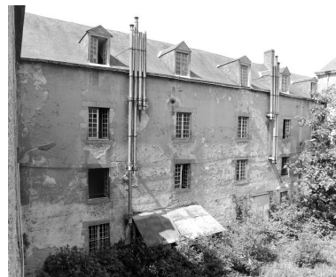
Couvent, élévation sud-ouest sur cour : vue d'ensemble.
