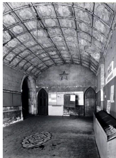
Eglise, vestibule : vue d'ensemble.
