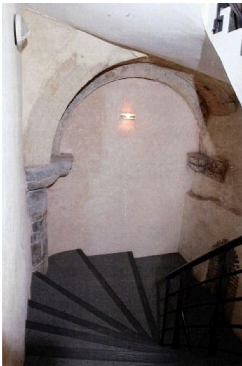
Couvent, bâtiment nord-ouest, cage d'escalier entre le rez-de-chaussée et le premier étage, vue de détail : arcade.
