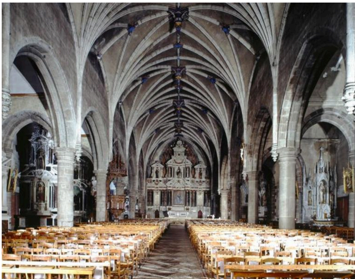
Eglise, nef : vue d'ensemble vers le chœur.
