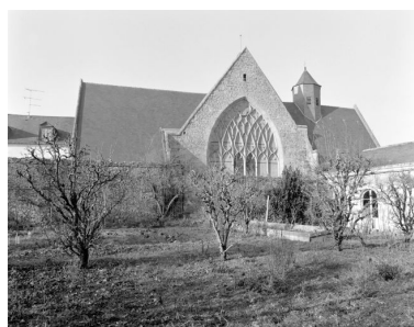
Eglise, chevet : vue d'ensemble depuis le jardin du presbytère. Phot. François Lasa IVR52_20035300135X
