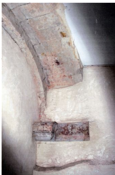
Couvent, bâtiment nord-ouest, cage d'escalier entre le rez-de-chaussée et le premier étage, arcade, vue de détail : chapiteau et arc. Phot. François Lasa IVR52_20035300352NUCA
