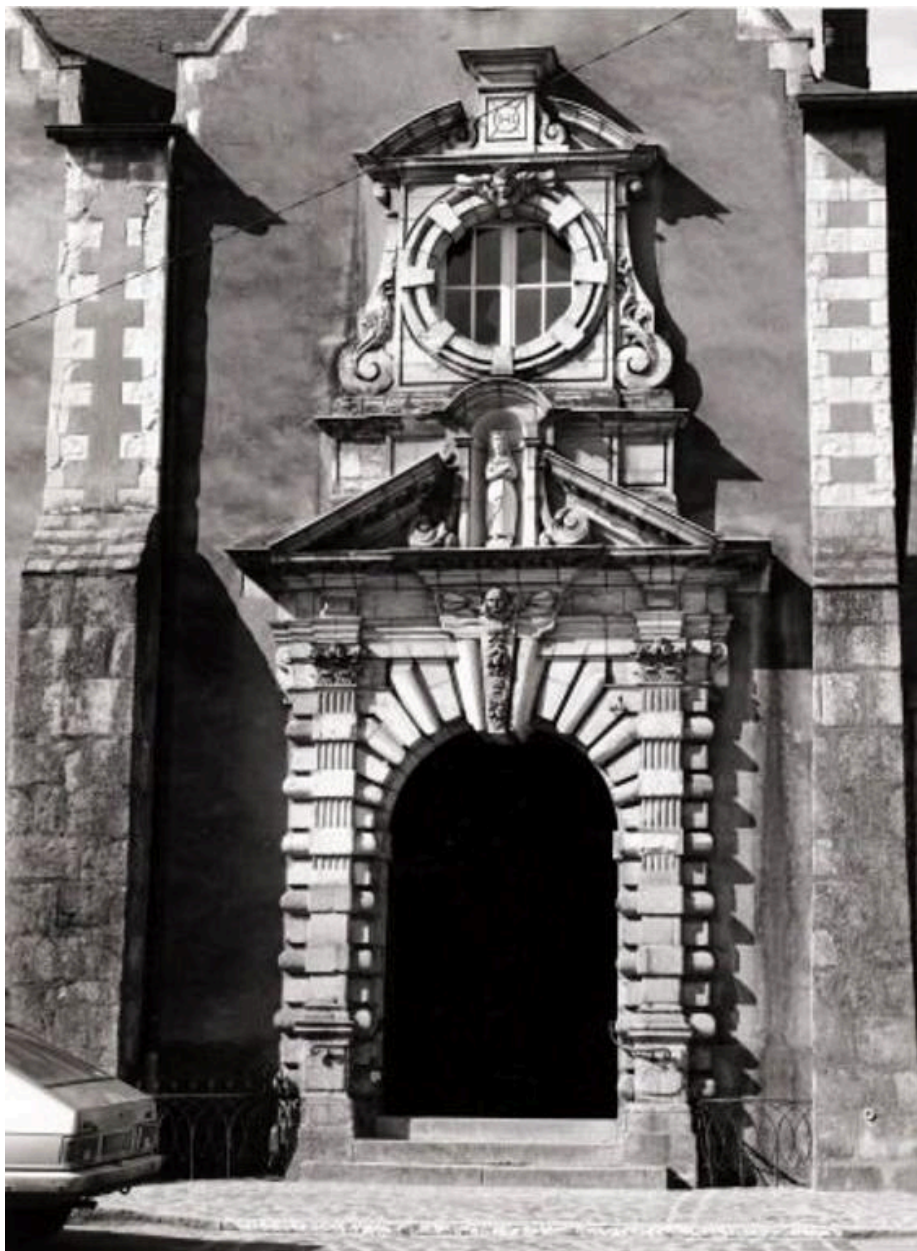
Eglise, portail : vue d'ensemble.
