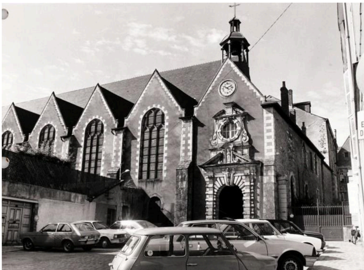
Eglise, élévation nord : vue d'ensemble.
