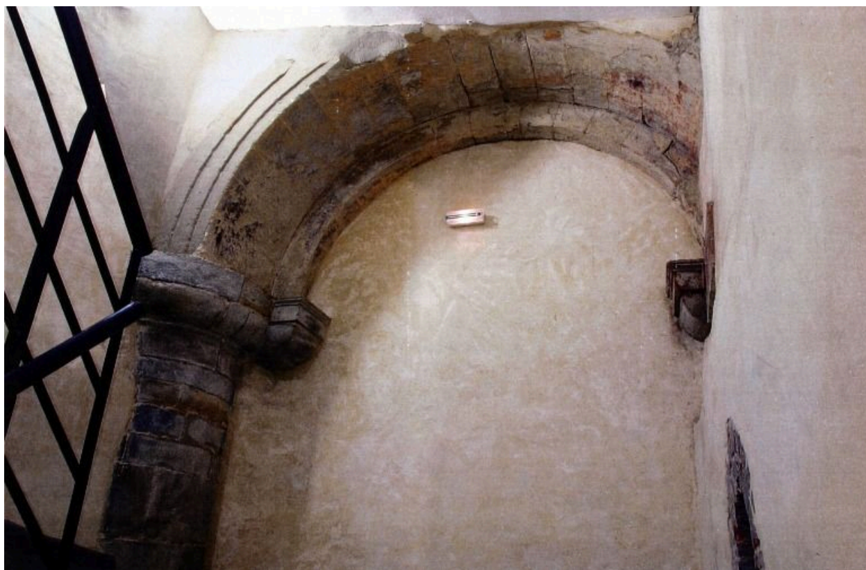
Couvent, bâtiment nord-ouest, cage d'escalier entre le rez-de-chaussée et le premier étage, vue de détail en contre-plongée : arcade.
