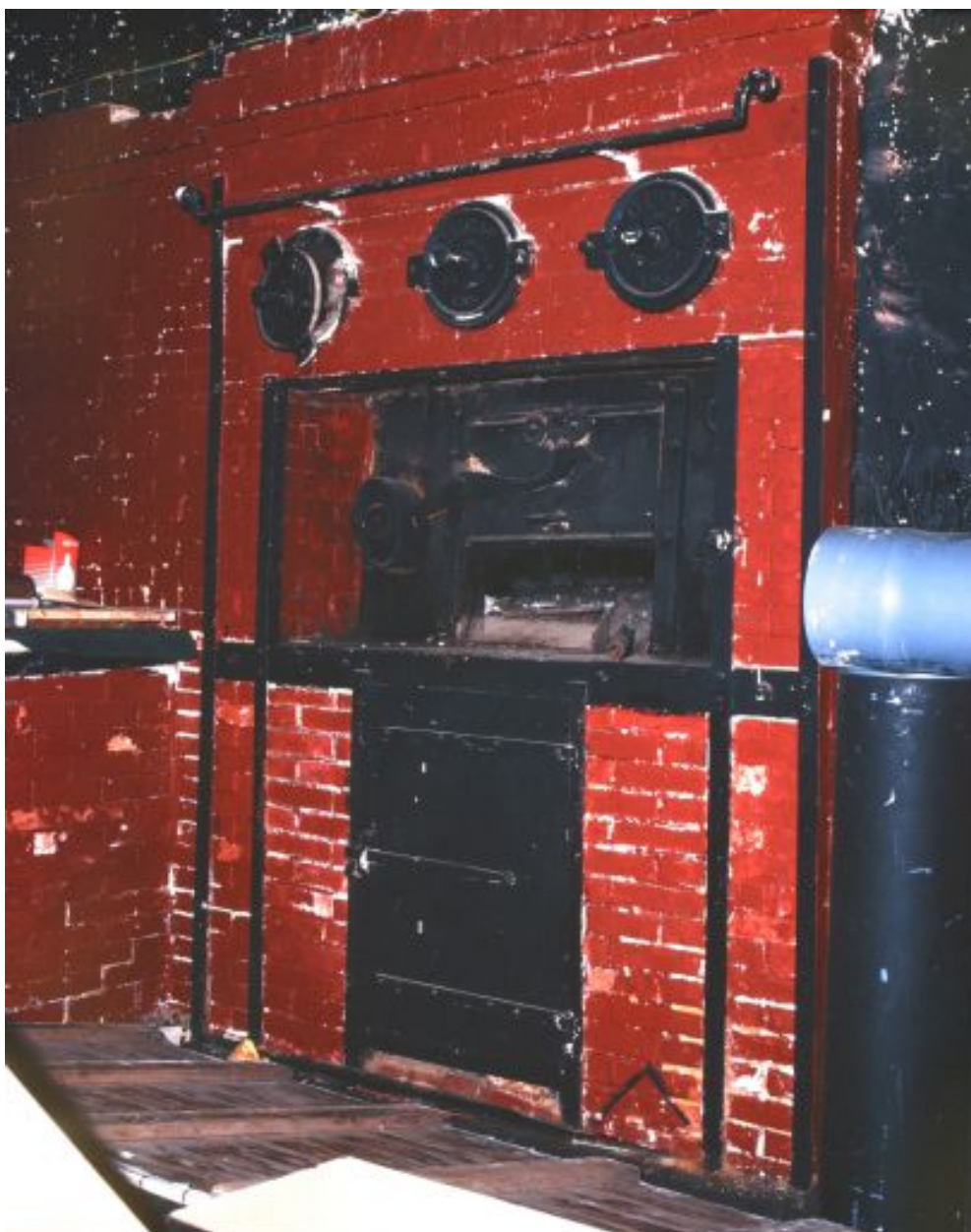
Couvent, aile nord-ouest, four à pains, vue de détail : partie droite.
