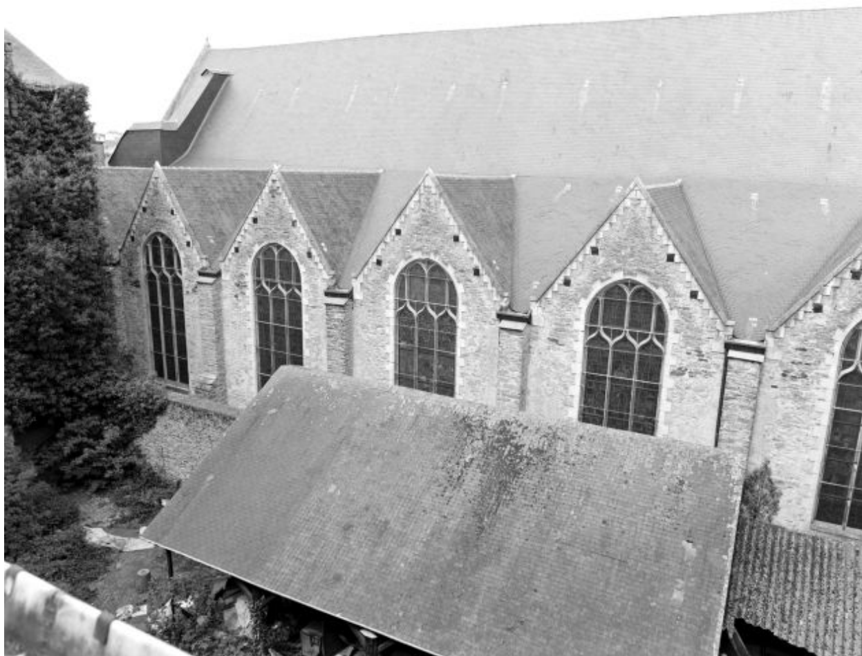
Eglise, bas-côté sud : vue d'ensemble.
