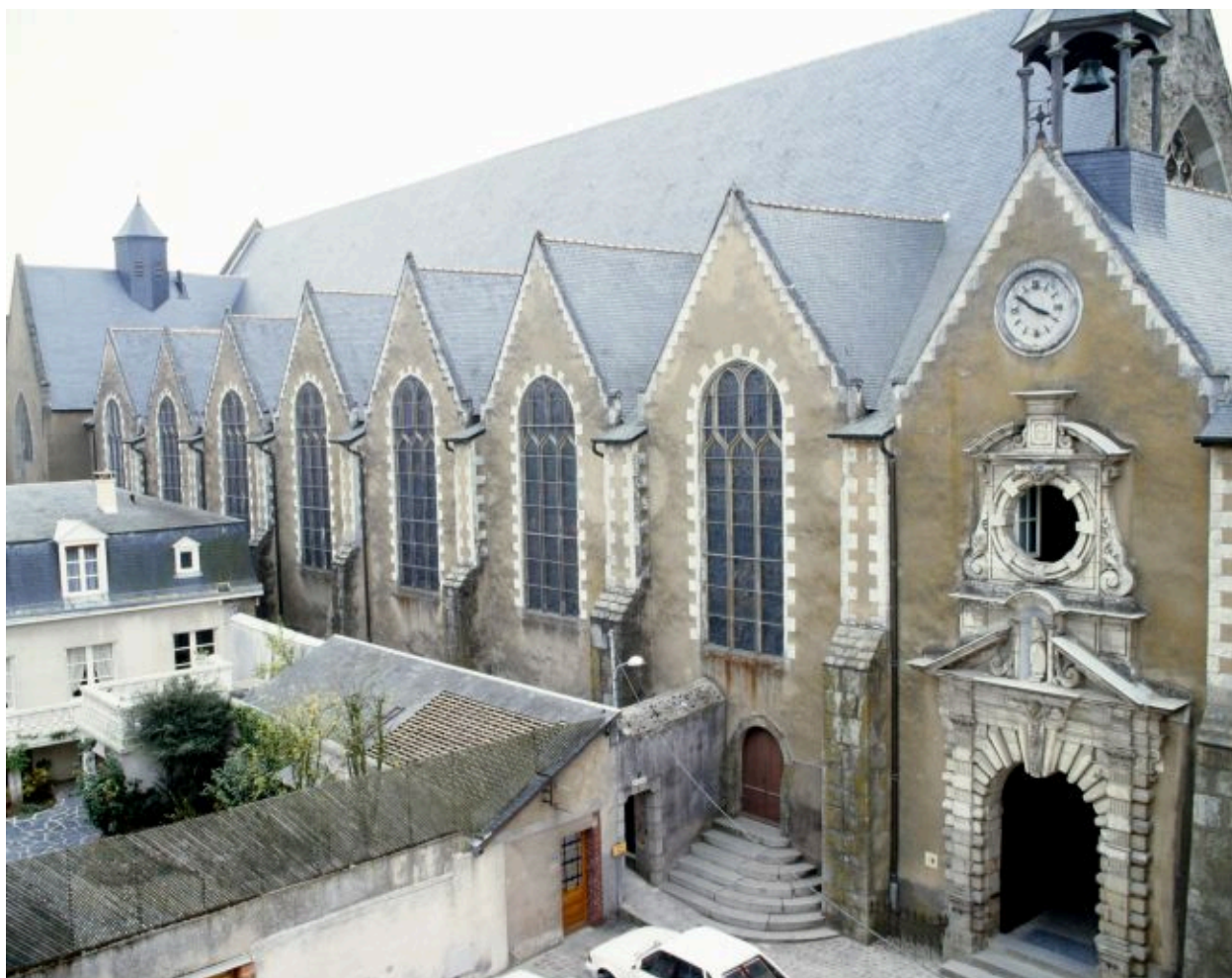
Eglise, élévation nord : vue d'ensemble.
