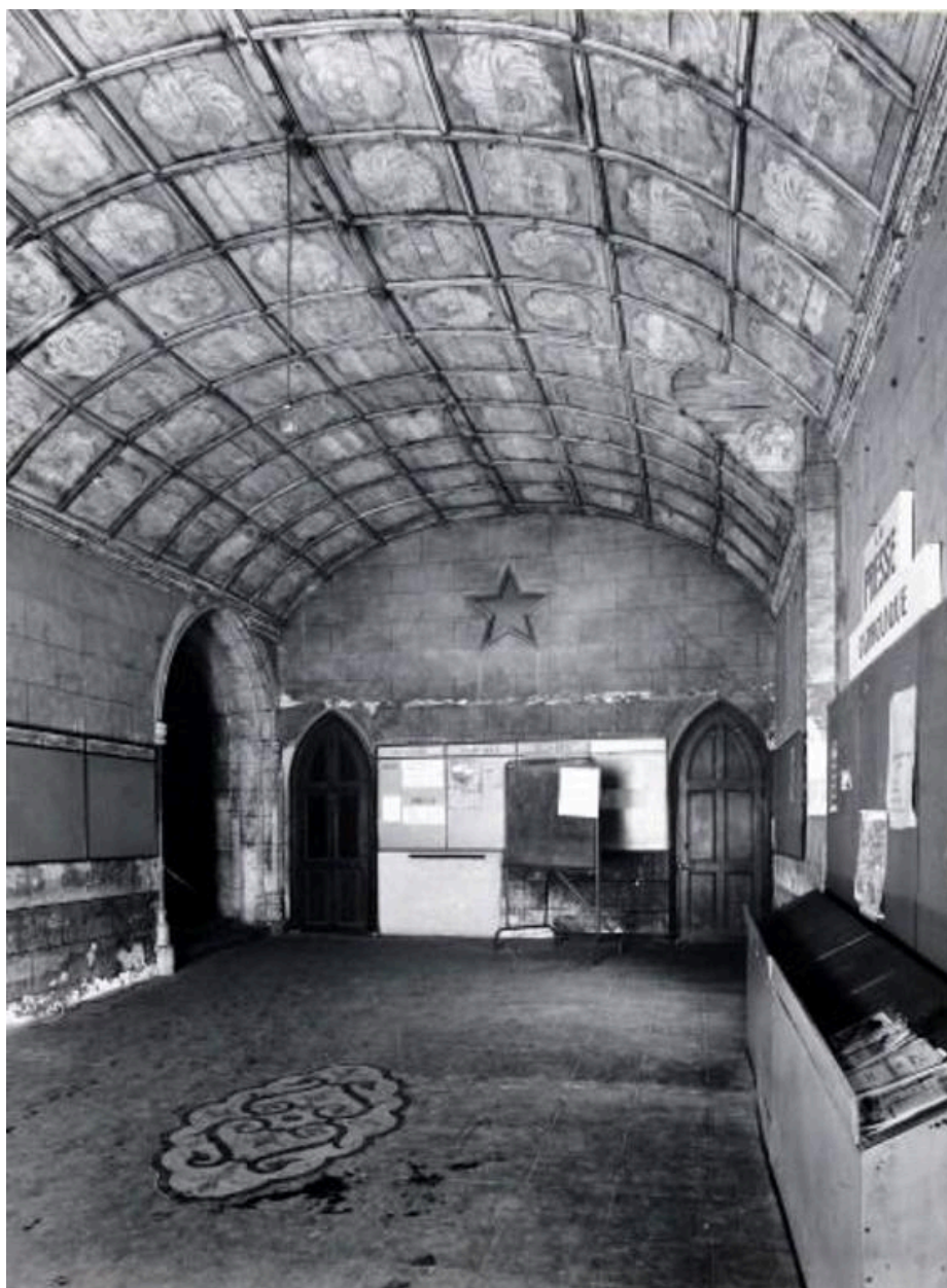
Eglise, vestibule : vue d'ensemble.
