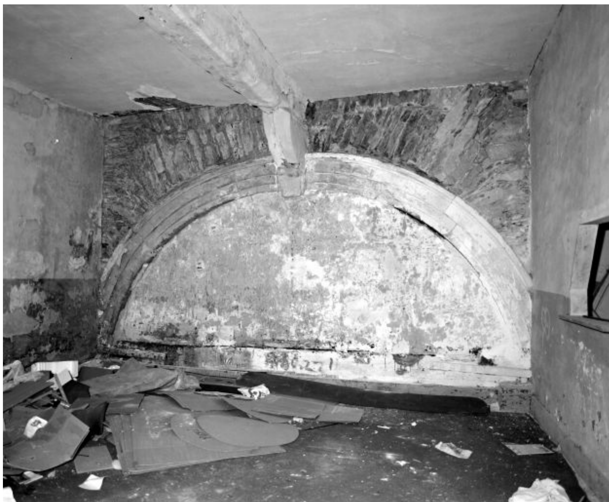
Couvent, aile nord-ouest, vue de détail : arcade.
