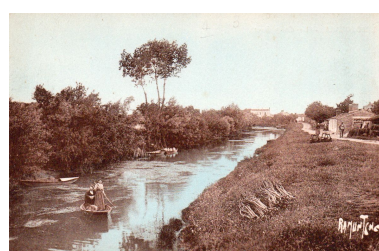
Le Contrebot vu depuis le pont du Quaireau à L'Île-d'Elle en direction de l'ouest, vers 1920. Phot. Yannis (reproduction) Suire IVR52_20198501086NUCA
