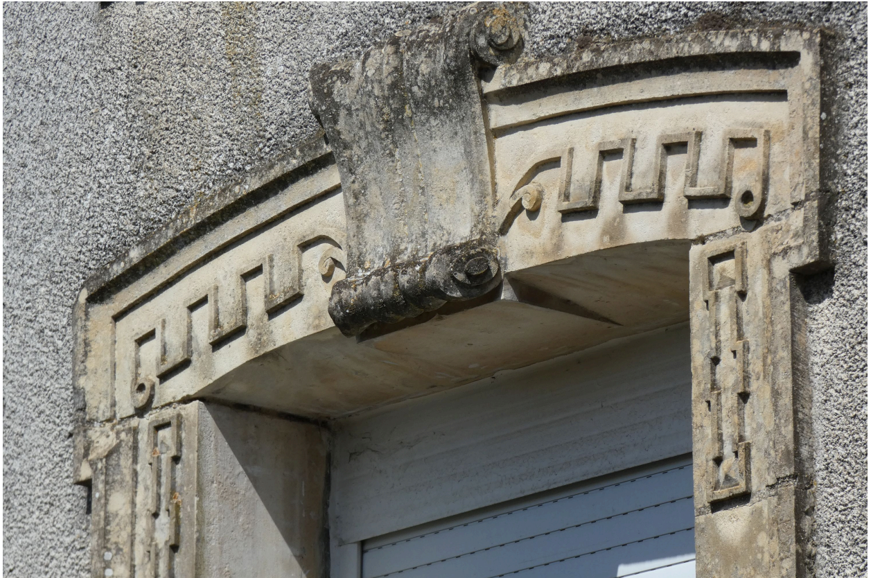
Détail du décor sculpté de la façade : enroulement, motifs géométriques.
