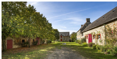
Les bâtiments depuis la cour. Phot. Pierre-Bernard Fourny IVR52_20235301650NUCA
