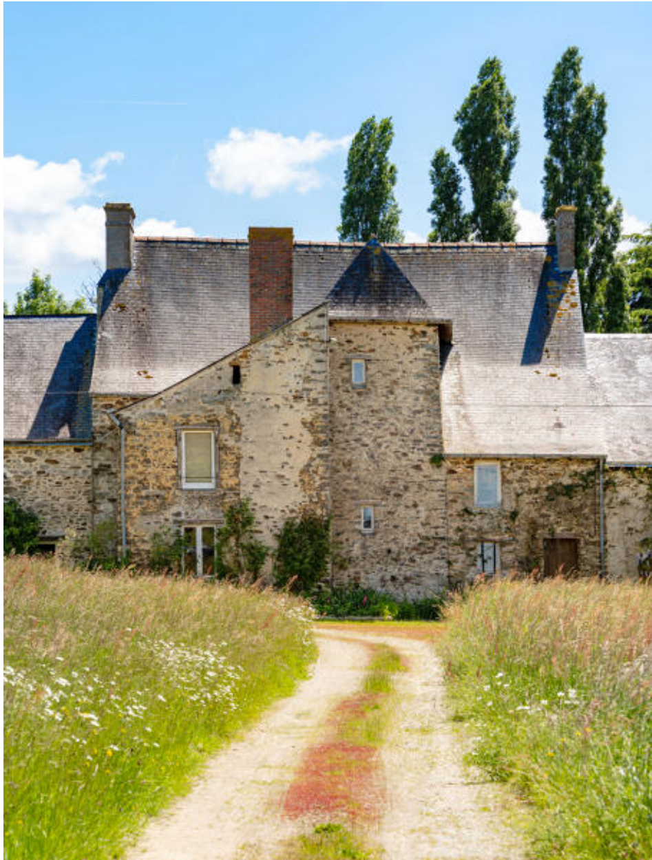
Le logis, élévation postérieure.
