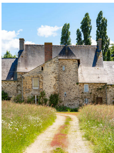
Le logis, élévation postérieure. Phot. Pierre-Bernard Fourny IVR52_20235301332NUCA
