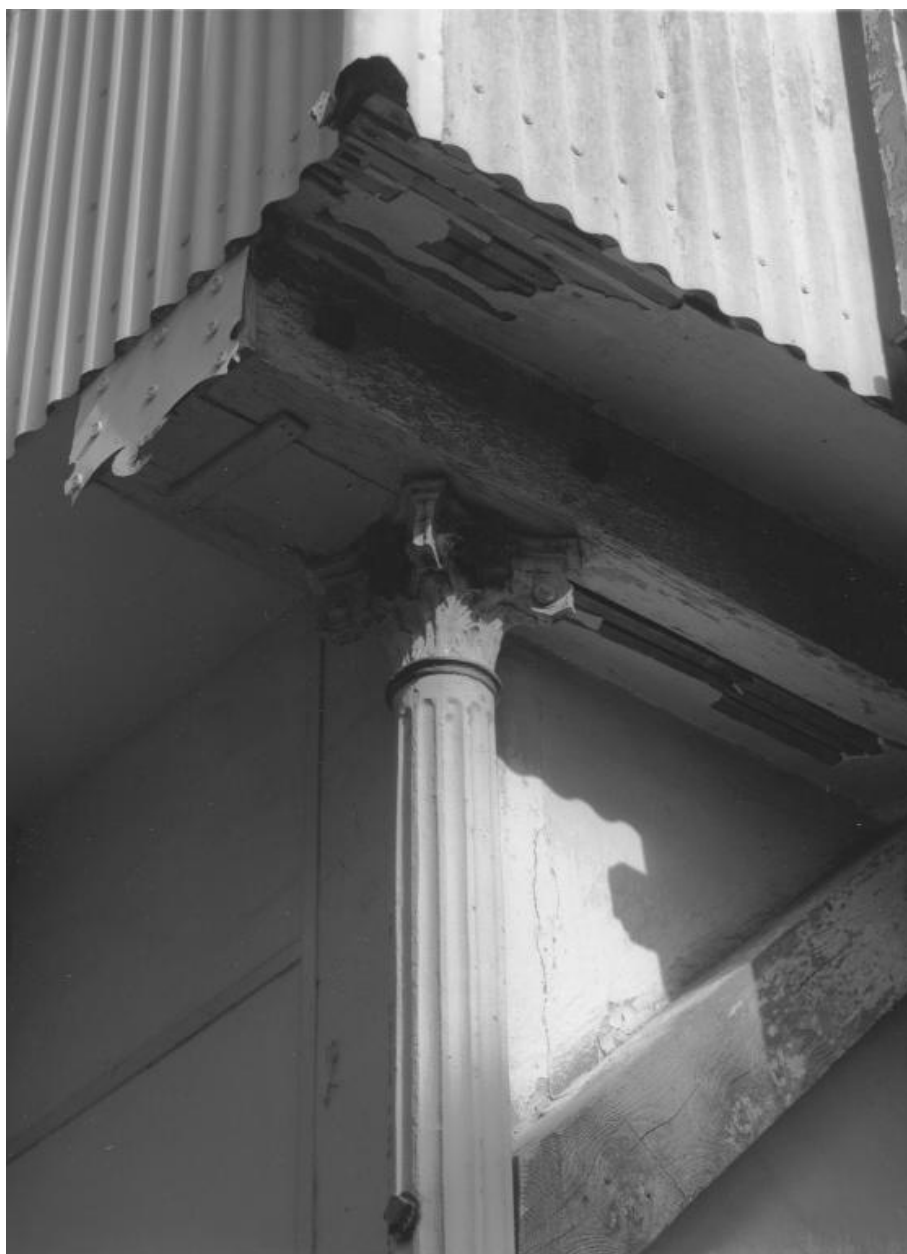
Détail d'une colonne en fonte de la villa L'Abri Andecavit.
