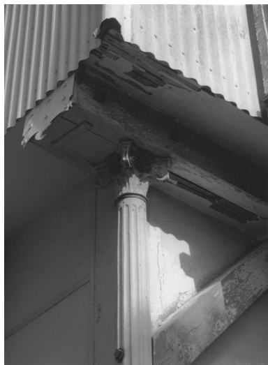
Détail d'une colonne en fonte de la villa L'Abri Andécavit.
