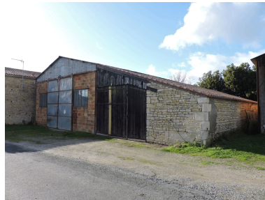
Les dépendances au nord du logis, vues depuis l'est. Phot. Yannis Suire IVR52_20218500849NUCA
