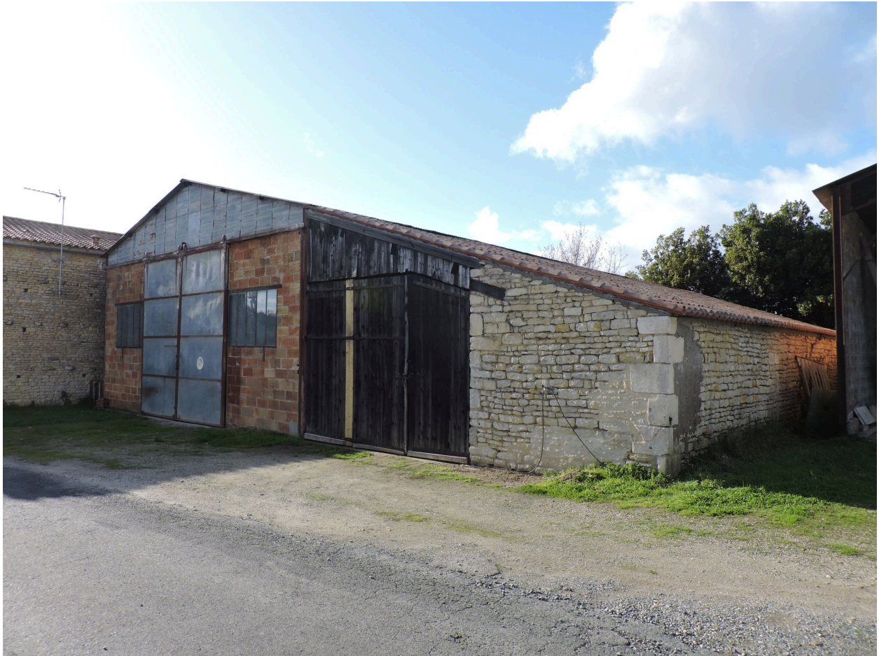
Les dépendances au nord du logis, vues depuis l'est.
