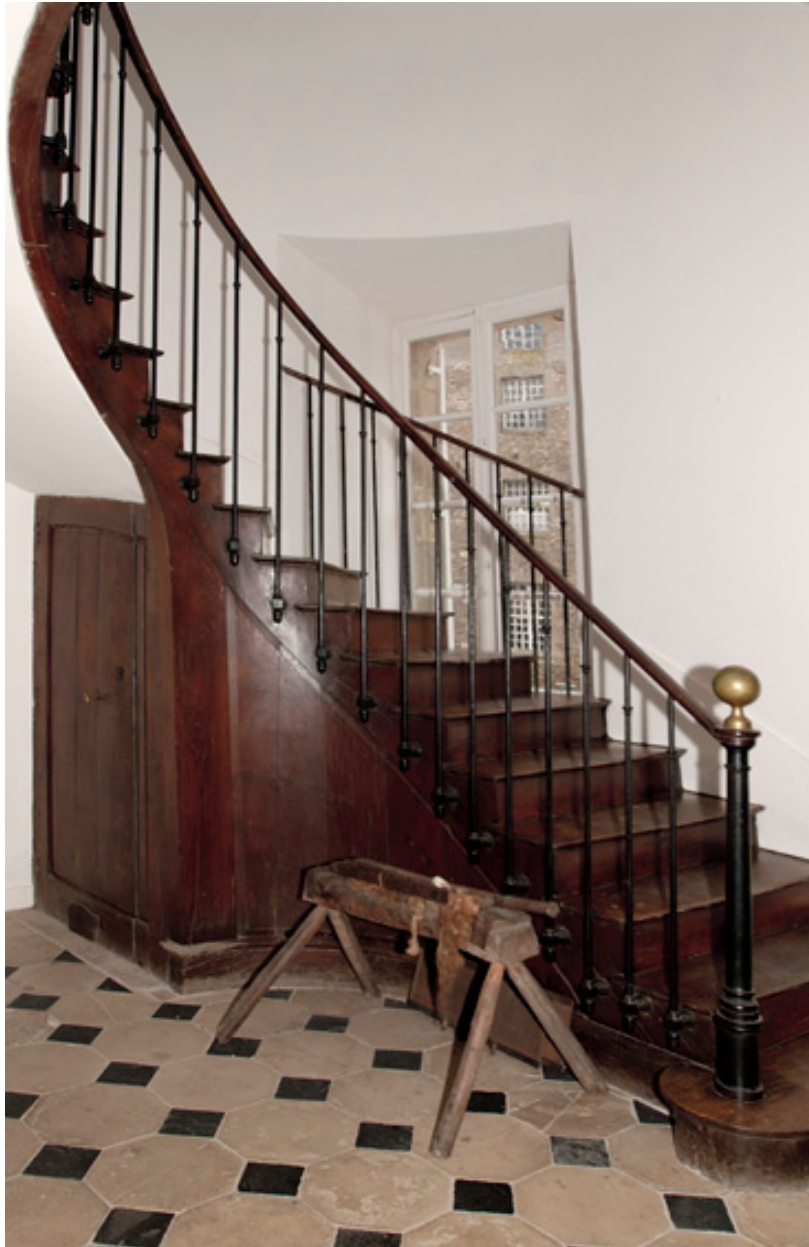
Escalier : départ depuis le rez-de-chaussée.
