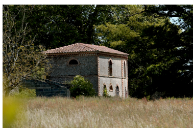
Bâtiment à usage de remise et d'étable, situé à l'extrémité de l'ancien jardin potager : vue d'ensemble depuis l'ouest. Phot. Bruno Rousseau IVR52_20064900986NUCA
