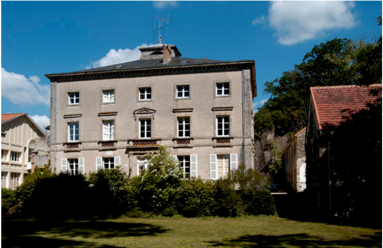
Logement patronal de l'usine textile dite filature de Gallard, façade sud (sur le parc).
