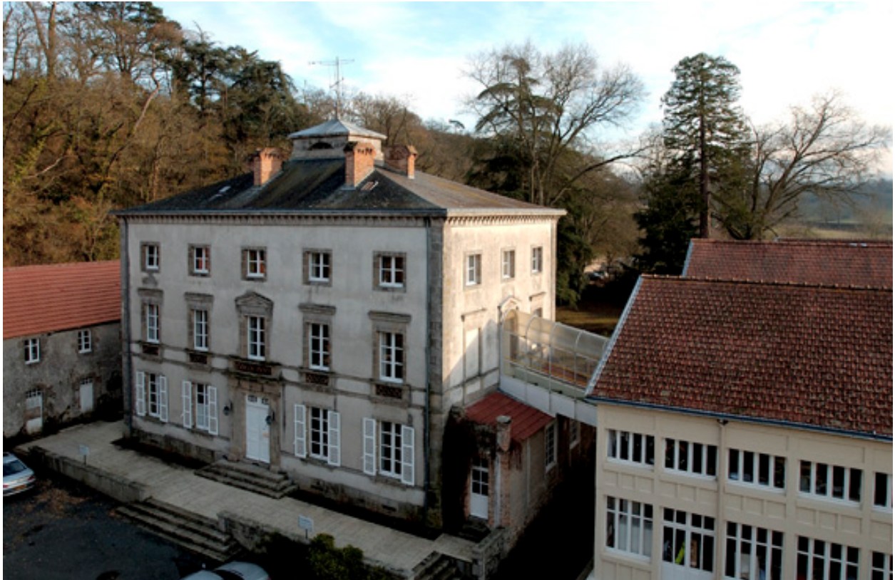
Vue générale du logement patronal de la filature de Gallard, depuis le 1er niveau de la filature
