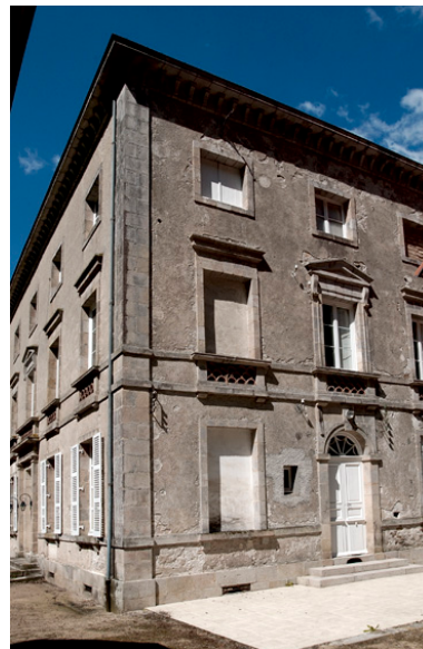
Vue générale depuis l'est. Phot. Bruno Rousseau IVR52_20064900960NUCA
