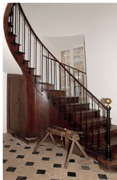
Escalier : départ depuis le rez-de-chaussée. Phot. Bruno Rousseau IVR52_20064900930NUCA
