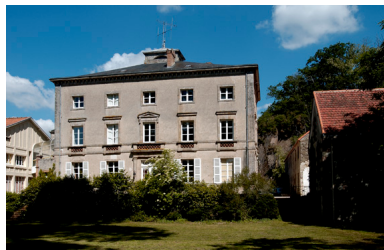
Logement patronal de l'usine textile dite filature de Gallard, façade sud (sur le parc). Phot. Bruno Rousseau IVR52_20064900962NUCA
