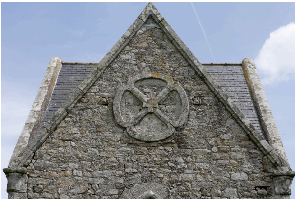
Chapelle. Détail du pignon ouest.
