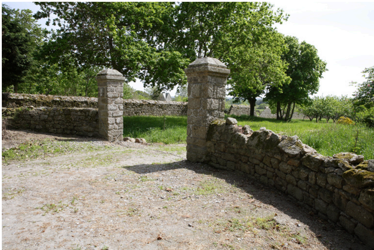
Cour. Vue du portail d'entrée.
