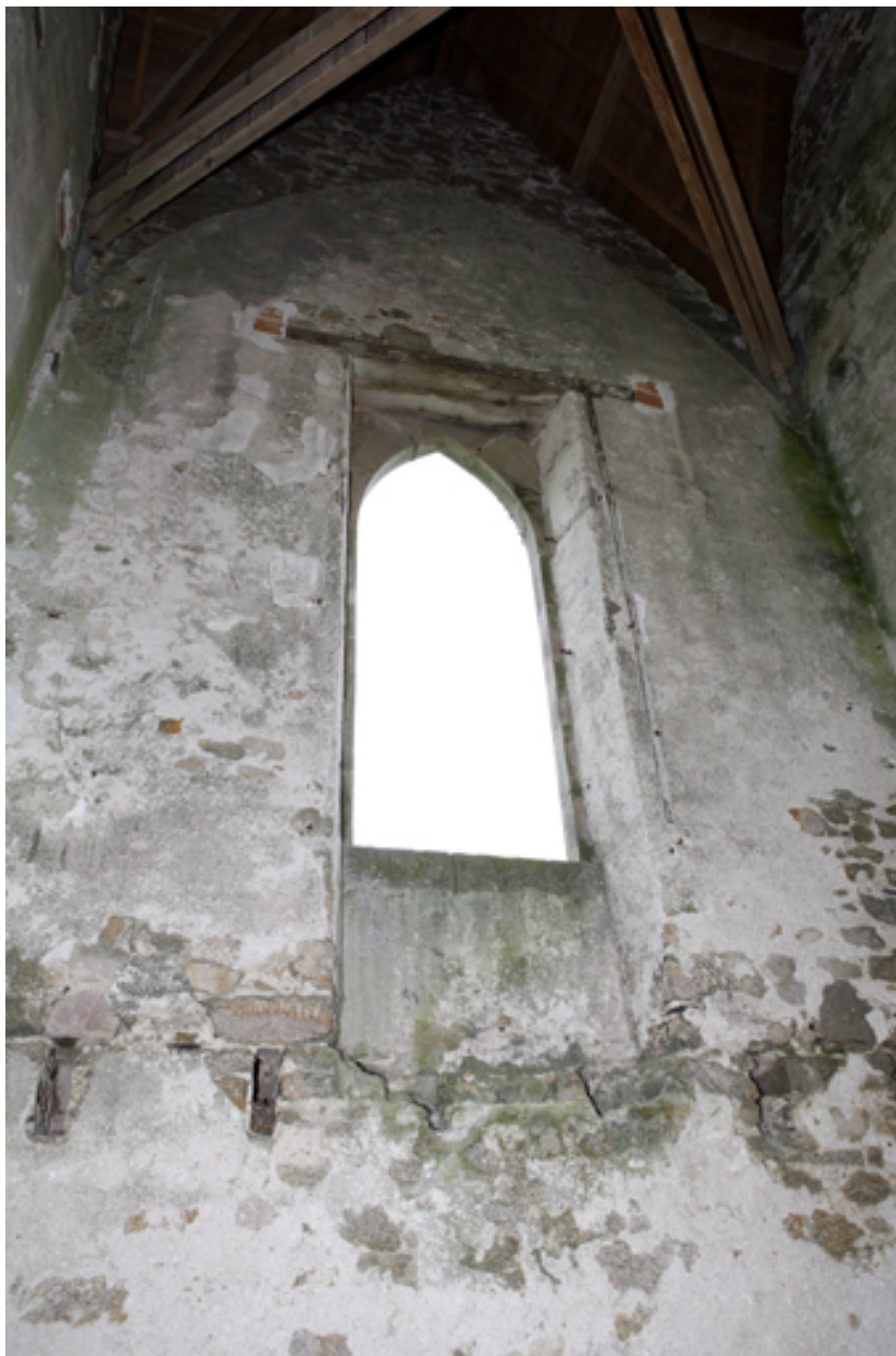
Chapelle. Détail de l'embrasure de la fenêtre nord.
