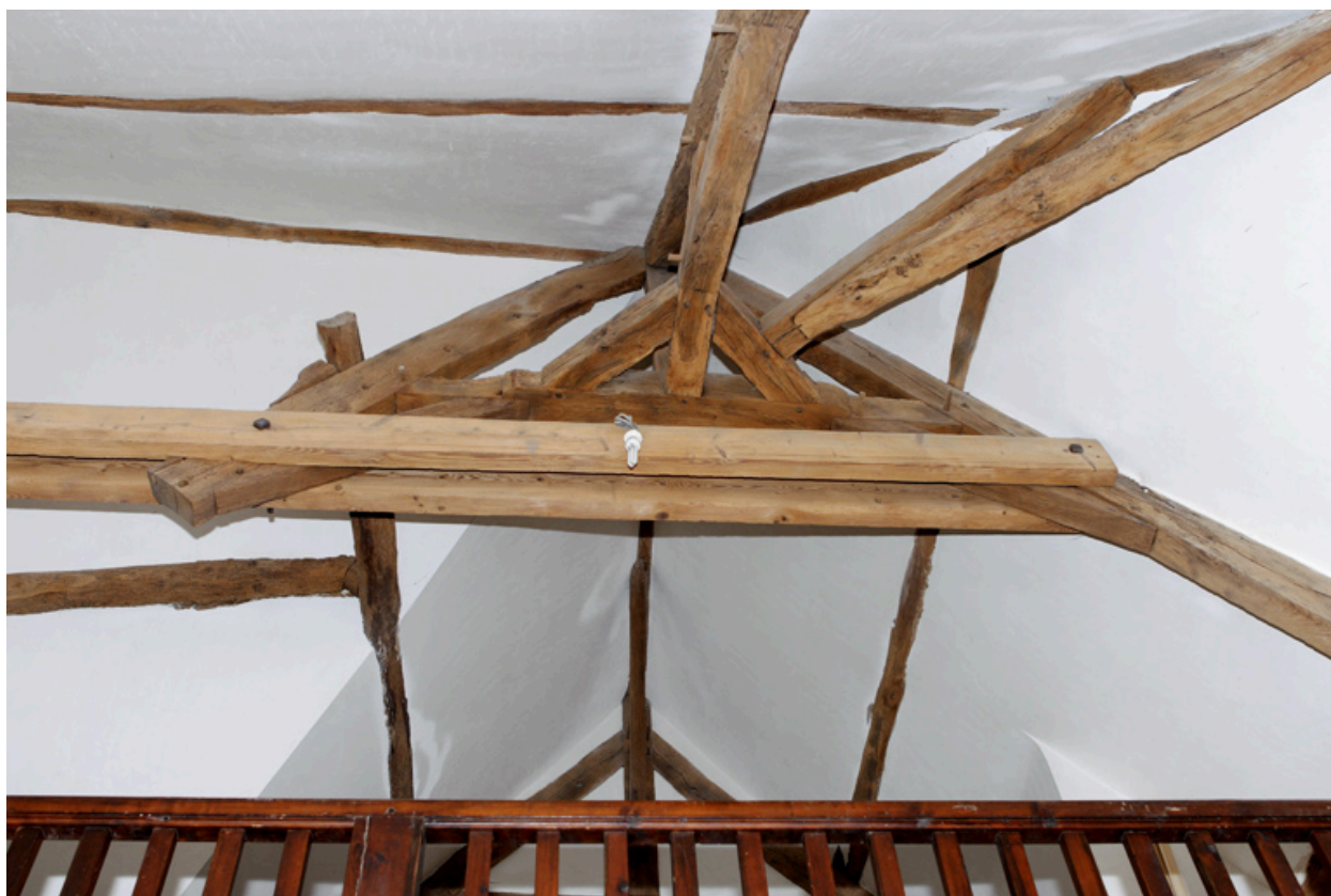
Logis. Aile sud. Détail de la charpente.
