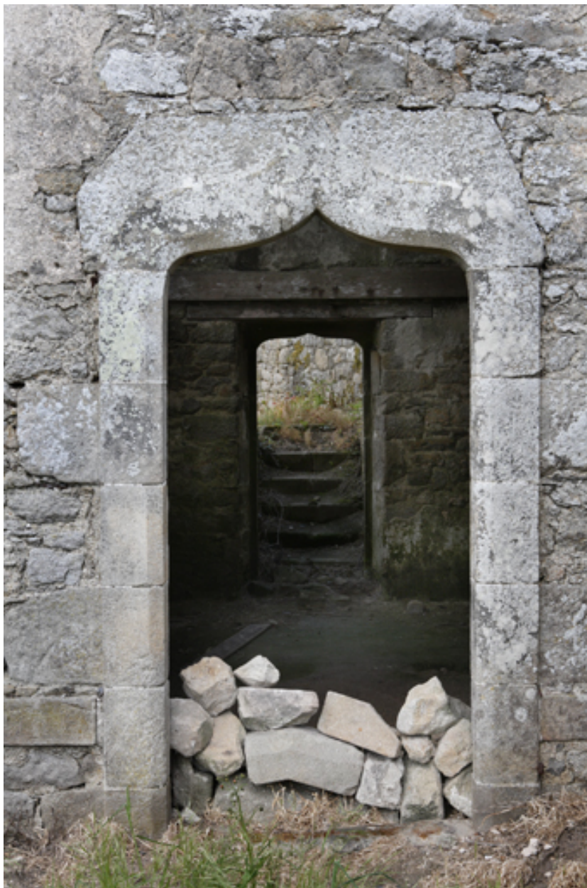
Chapelle. Détail de la porte sud.
