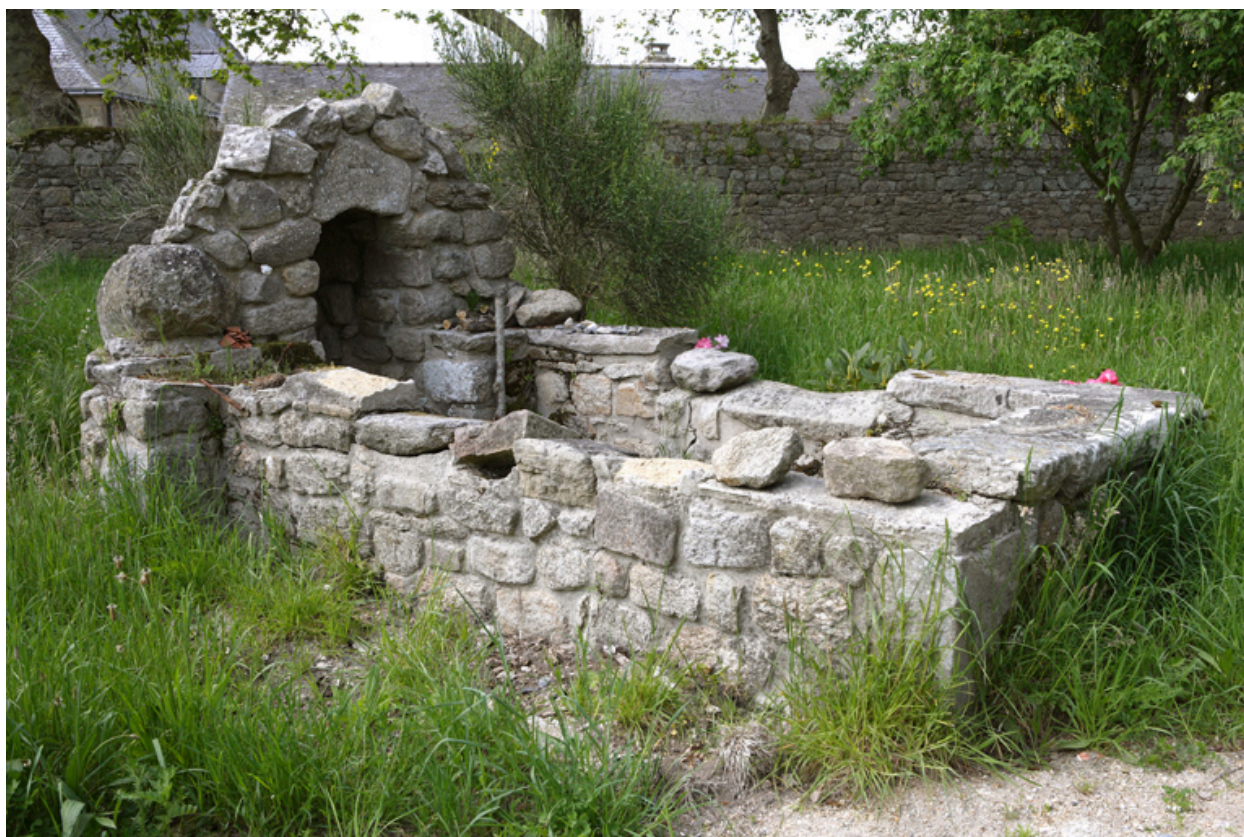
Cour. Vue de la fontaine.
