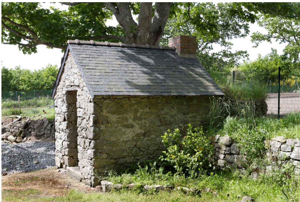
Cour. Vue du fouil.
