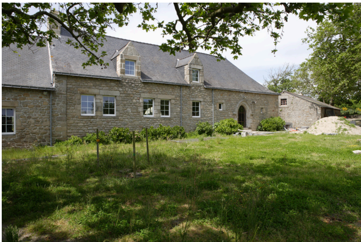
Logis. Aile est. Vue de la façade es depuis le sud-est.
