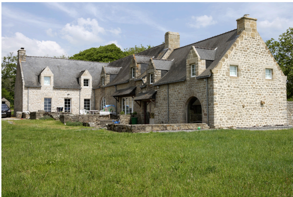
Logis. Vue d'ensemble depuis le sud-ouest.
