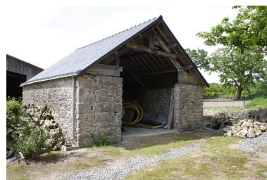
Cour. Vue de la remise. Phot. Denis Pillet IVR52_20084401607NUCA
