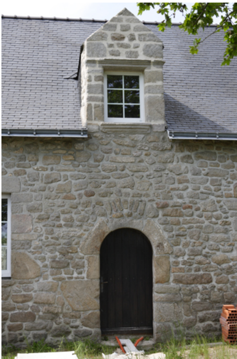
Logis. Aile est. Façade est. Détail de la porte et de la lucarne de gauche.
