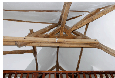
Logis. Aile sud. Détail de la charpente. Phot. Denis Pillet IVR52_20084401588NUCA
