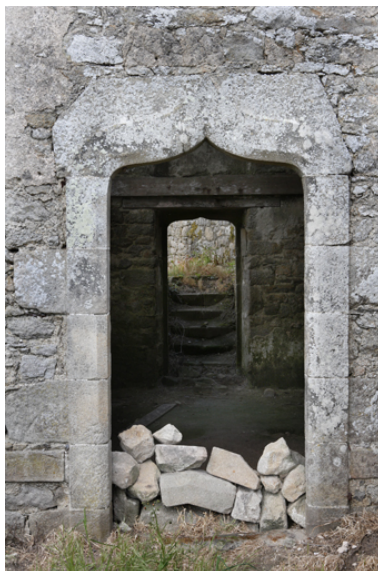
Chapelle. Détail de la porte sud. Phot. Denis Pillet IVR52_20084401599NUCA
