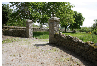
Cour. Vue du portail d'entrée. Phot. Denis Pillet IVR52_20084401604NUCA
