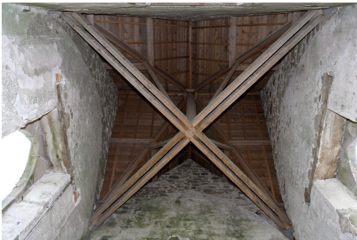
Chapelle. Détail de la charpente.
