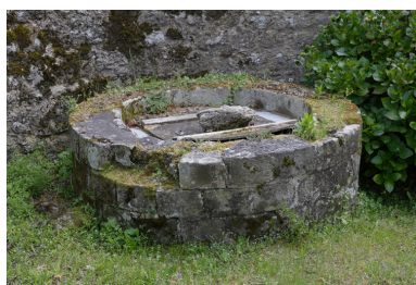
Cour. Détail du deuxième puits. Phot. Denis Pillet IVR52_20084401590NUCA
