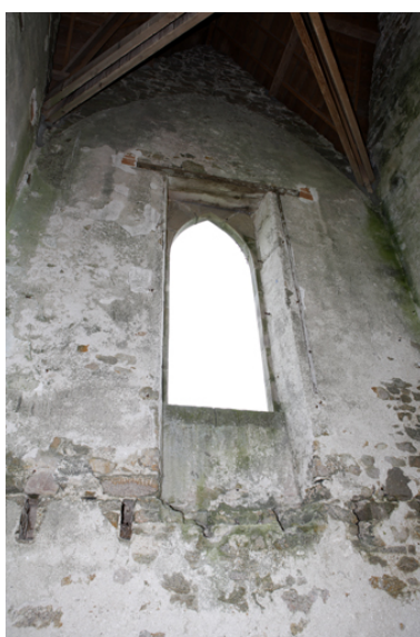
Chapelle. Détail de l'embrasure de la fenêtre nord. Phot. Denis Pillet IVR52_20084401597NUCA
