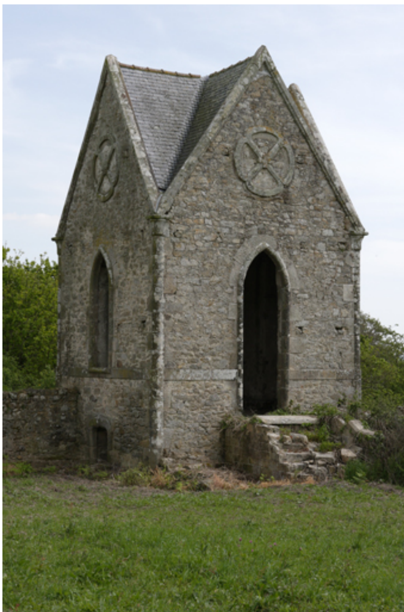
Chapelle. Vue d'ensemble depuis le nord-ouest.
