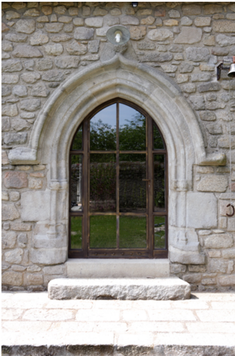
Logis. Aile est. Façade est. Détail de la porte en remploi.
