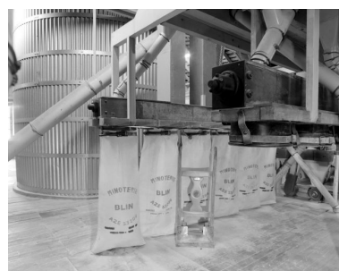
Comble à surcroît. L'ensacheur du remoulage. Phot. François Lasa IVR52_20025300552X
