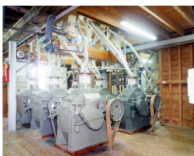
Premier étage, vu du nord-ouest : les broyeurs à cylindres. Phot. François Lasa IVR52_20025300548XA
