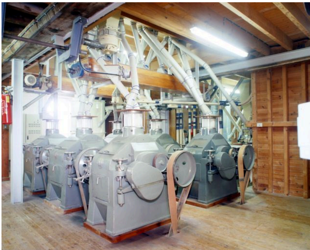
Premier étage, vu du nord-ouest : les broyeurs à cylindres.
