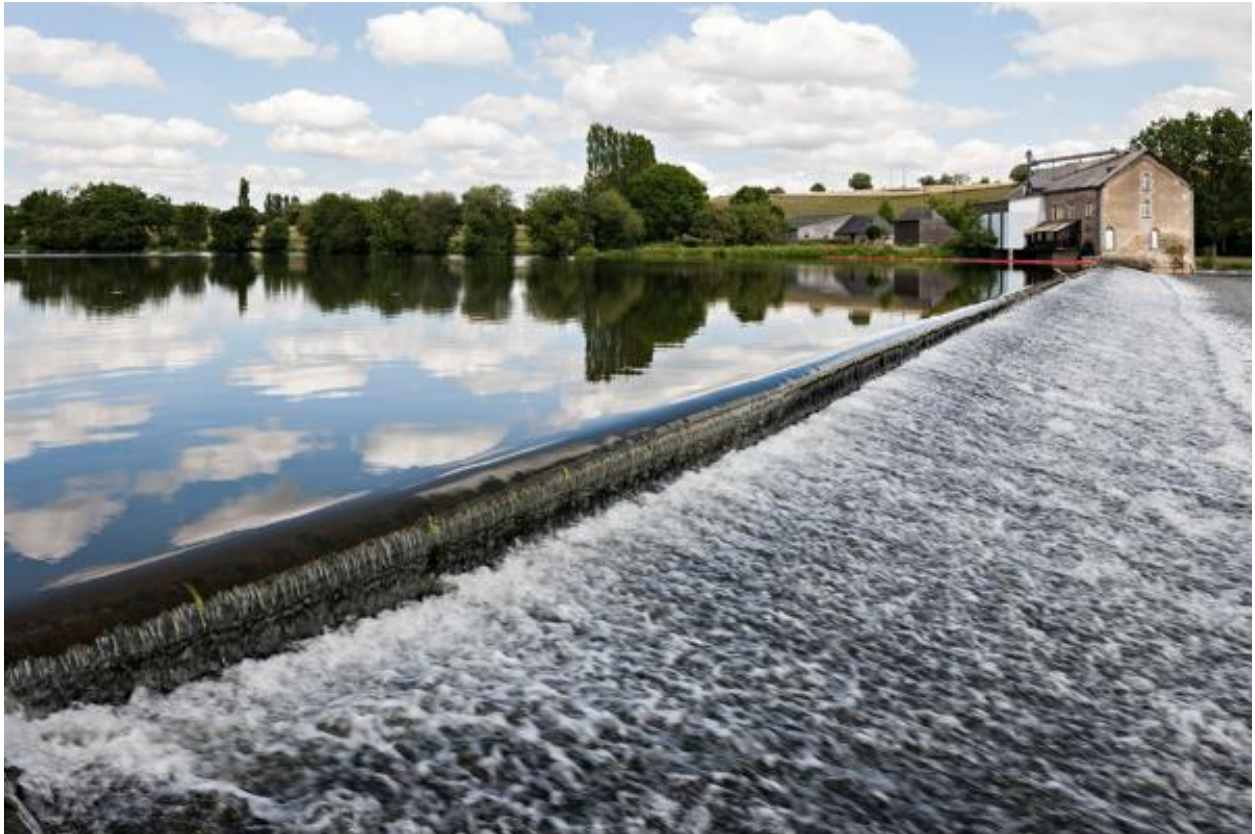
Vue du barrage et du moulin depuis le moulin de la Petite-Bavouze, situé rive droite.
