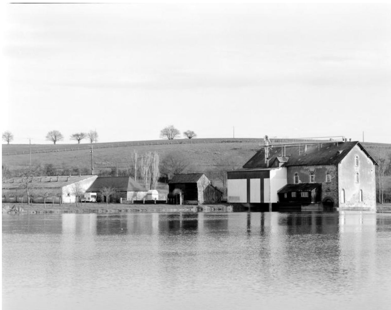
Vue du site du moulin depuis la rive droite en amont.
