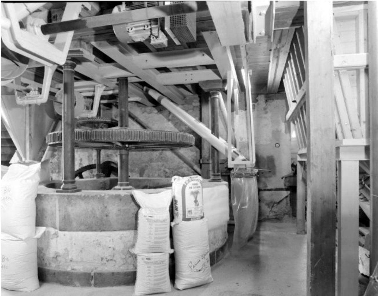
Rez-de-chaussée, partie est : la seconde poquerie contenant le système de transmission commandé par la roue de rive.
