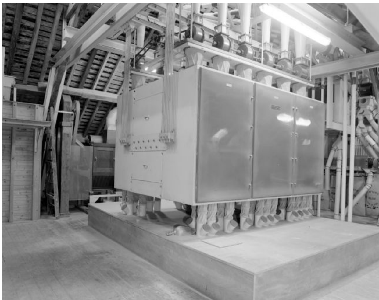
Le comble à surcroît, vu du nord-ouest : le plansichter
