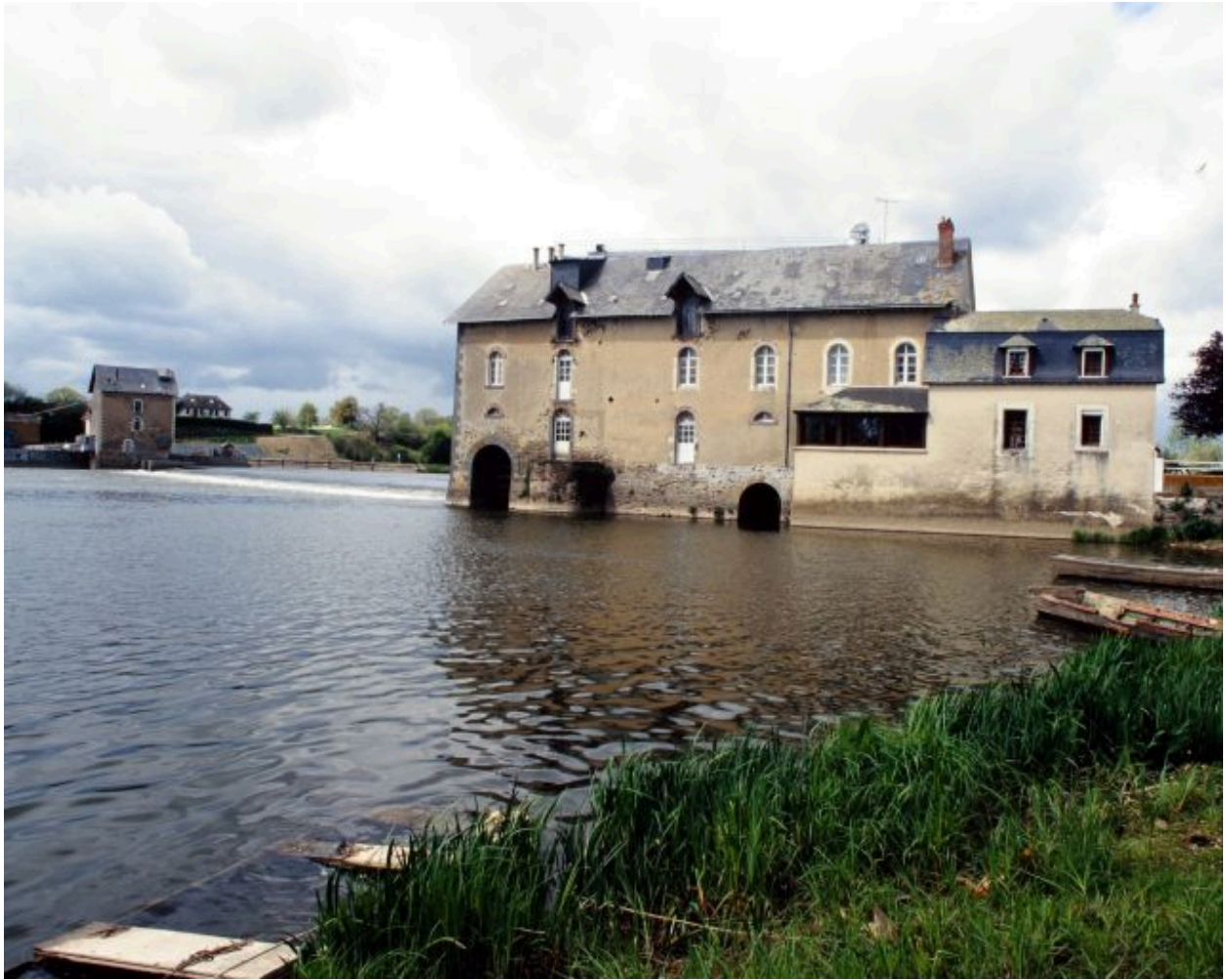
La façade sud, en aval. A droite, le logement du meunier.
