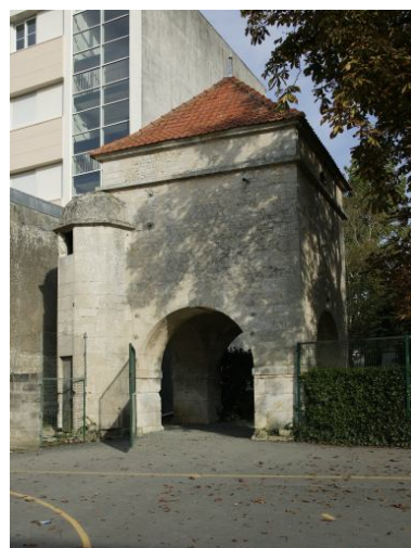
Vue d'ensemble prise de l'ouest, montrant l'escalier en vis, hors-oeuvre. Phot. Patrice Giraud IVR52_20068500103NUCA
