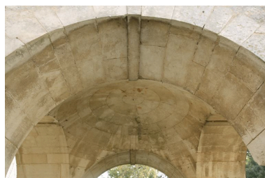
Coupole sur pendentifs supportant le pigeonnier. Phot. Patrice Giraud IVR52_20068500075NUCA
