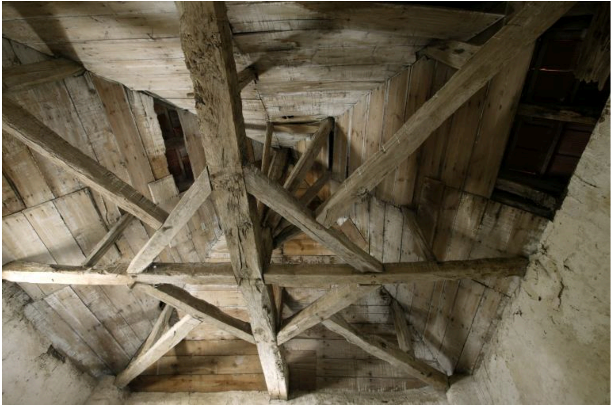
Vue de la charpente à enrayure.
