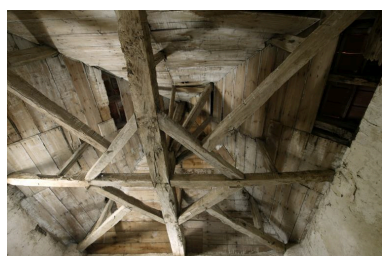
Vue de la charpente à enrayure. Phot. Patrice Giraud IVR52_20068500076NUCA
