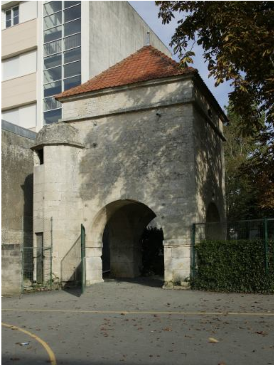
Vue d'ensemble prise de l'ouest, montrant l'escalier en vis, hors-oeuvre.
