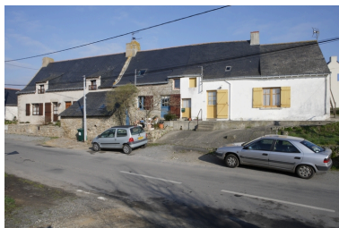
Vue d'ensemble depuis le sud-est. Phot. Denis Pillet IVR52_20084400065NUCA
