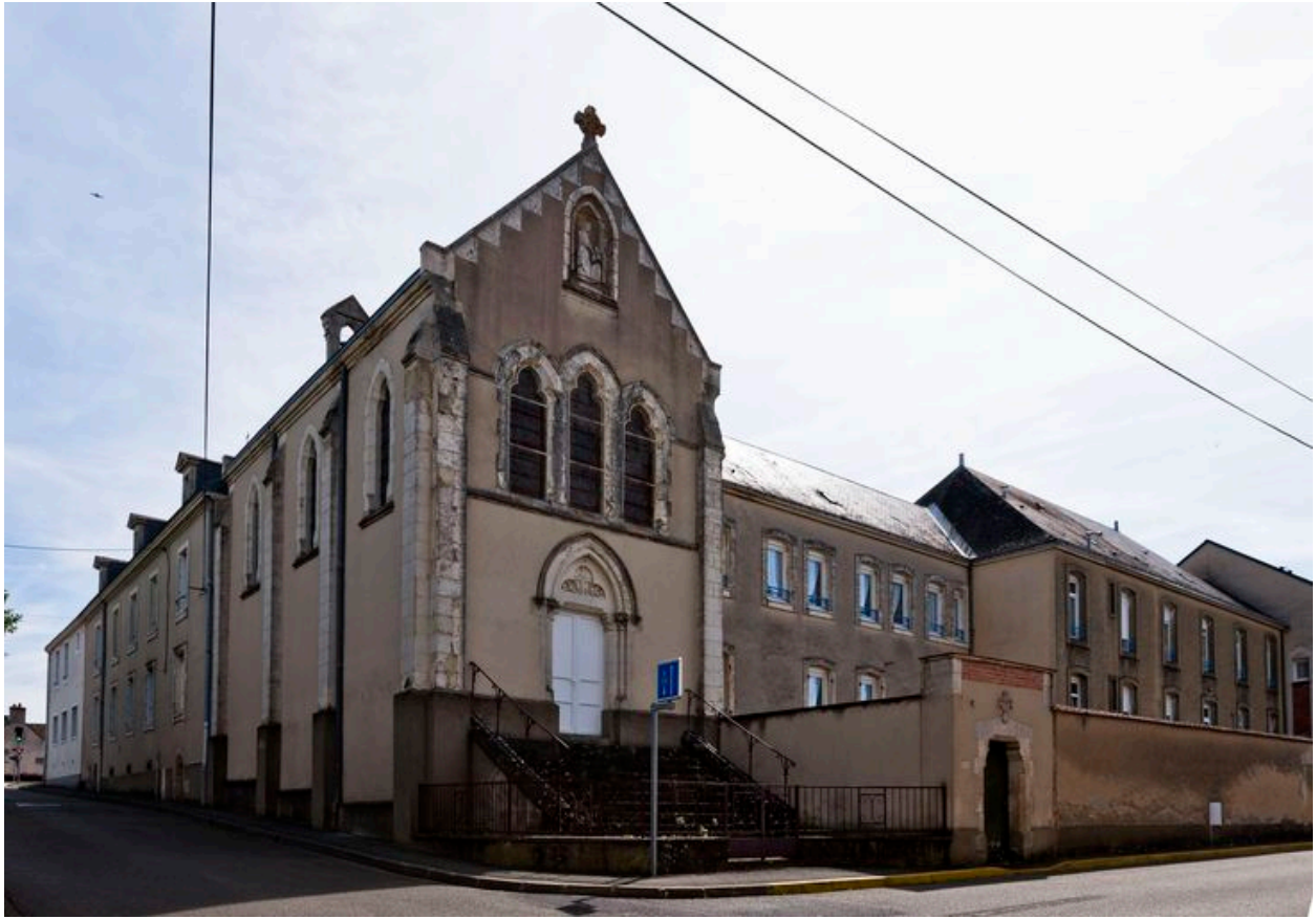
Vue d'ensemble de l'hospice et de sa chapelle.
