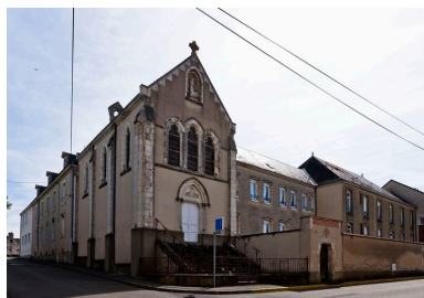
Vue d'ensemble de l'hospice et de sa chapelle. Phot. Yves Guillotin IVR52_20157201391NUCA
