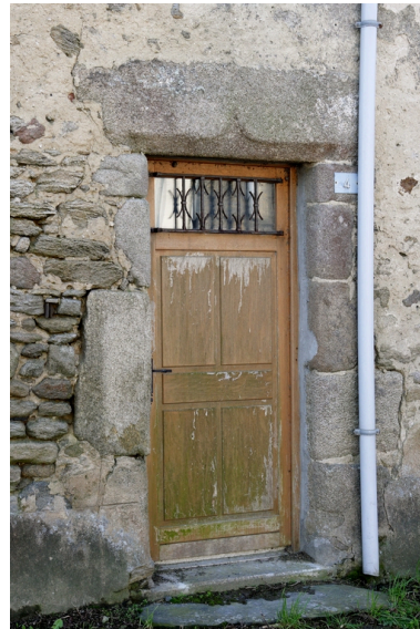
Détail de la porte du n° 6 rue des Trois-Frères-Lelan. Phot. Denis Pillet IVR52_20084400292NUCA
