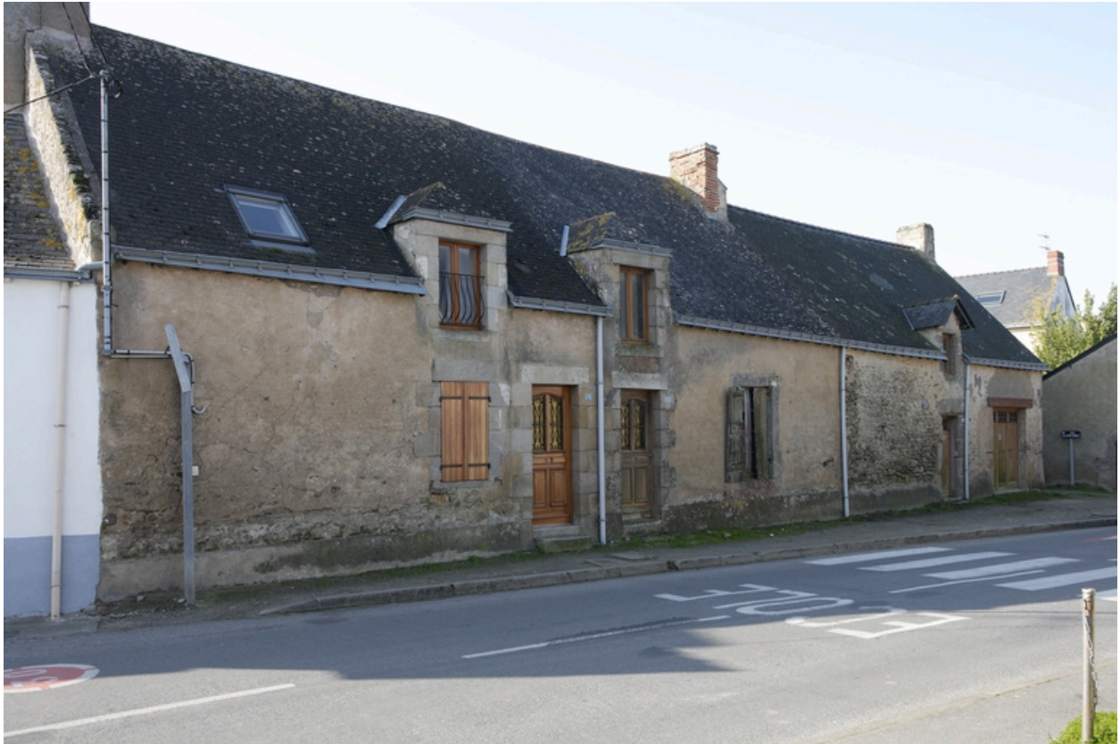
Vue des n° 6 et n° 8 rue des Trois-Frères-Lelan.
