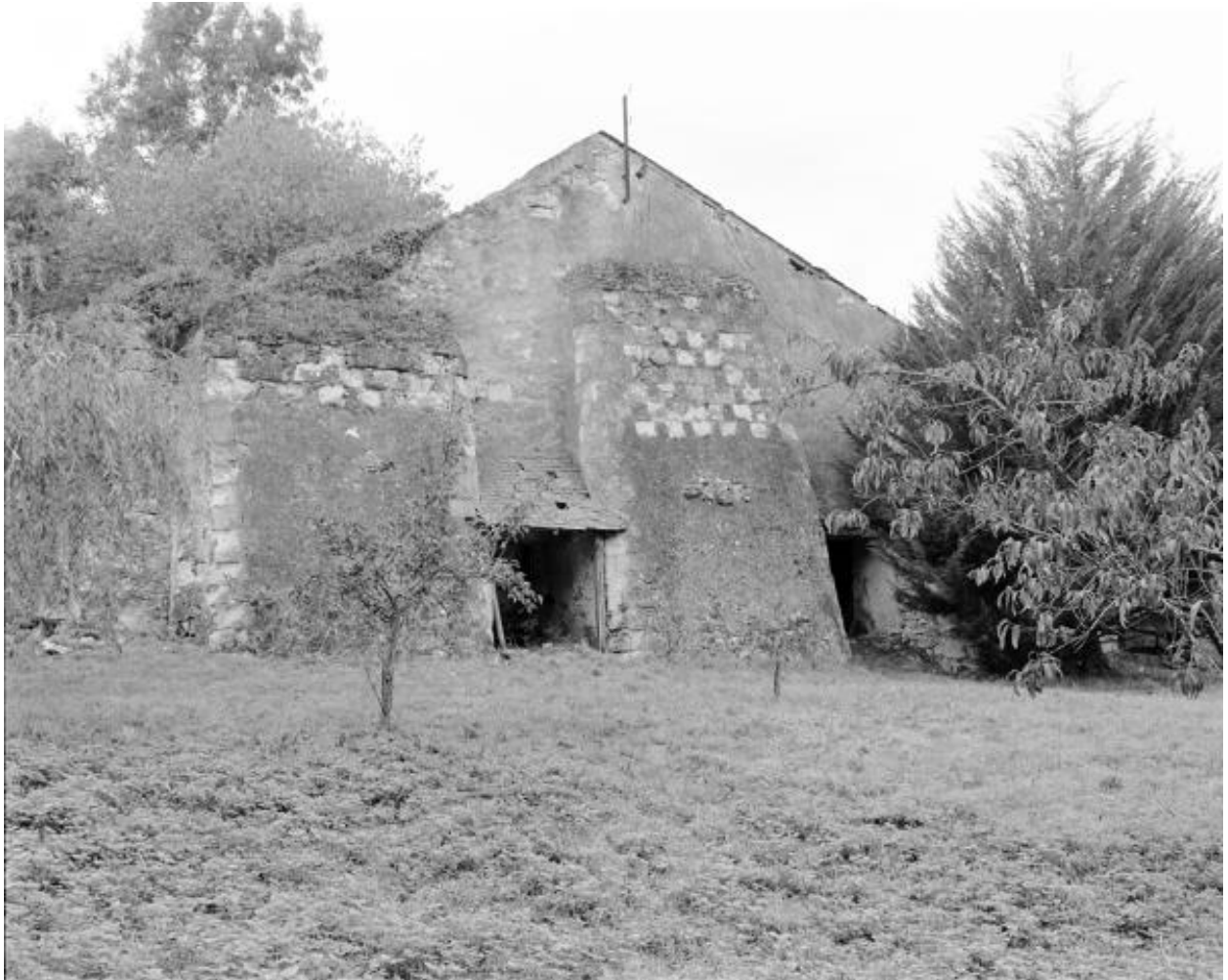
Bâtiment de stockage à contreforts, charbonnière est (parcelle 115), face sud-est, chaufournerie de Maison-Blanche, Montjean-sur-Loire.
