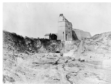
Élévateur et carrière de la chaufournerie de Pincourt, vue depuis l'est, four de Sainte Barbe, Montjean-sur-Loire. Photographie de la fin du XIXème siècle, A.D. Maine-et-Loire, collection iconographique de Célestin Port, carton 32, n°467. Phot. Bruno Rousseau IVR52_19854901997X
