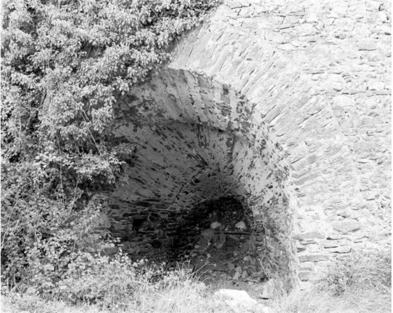
Masse de four en tour à enveloppes concentriques, ébraisoir sud, four à chaux du Lièvre, Montjean-sur-Loire.
