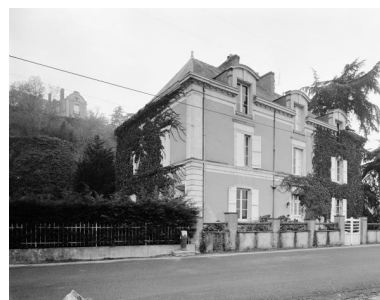
Maison de maître-chaufournier, chaufournerie du Rivage, faces nord et est (33 quai Mr. Provost), Montjean-sur-Loire. Phot. Bruno Rousseau IVR52_19854901810V
