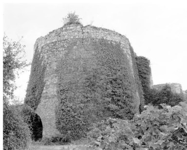
Four en tour nue, vue depuis le sud, four à chaux du Lièvre, Montjean-sur-Loire. Phot. Bruno Rousseau IVR52_19854901746X
