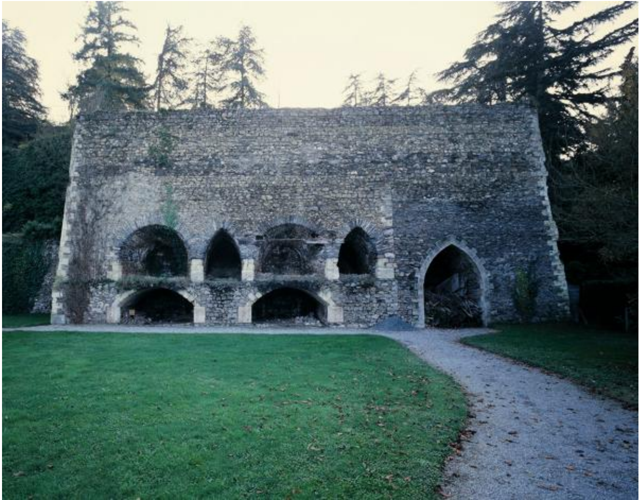
Fours en massif pyramidal, fours à chaux de la Tranchée, face nord.
