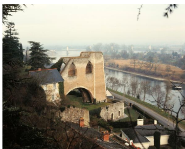
Chevalement du puits de la Tranchée, fours de la Tranchée, Montjean-sur-Loire. Phot. Bruno Rousseau IVR52_19924901163XA
