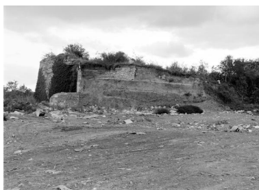
Four en tour à rampe postérieure, vu depuis l'est, four à chaux du Lièvre, Montjean-sur-Loire. Phot. Bruno Rousseau IVR52_19854901749X
