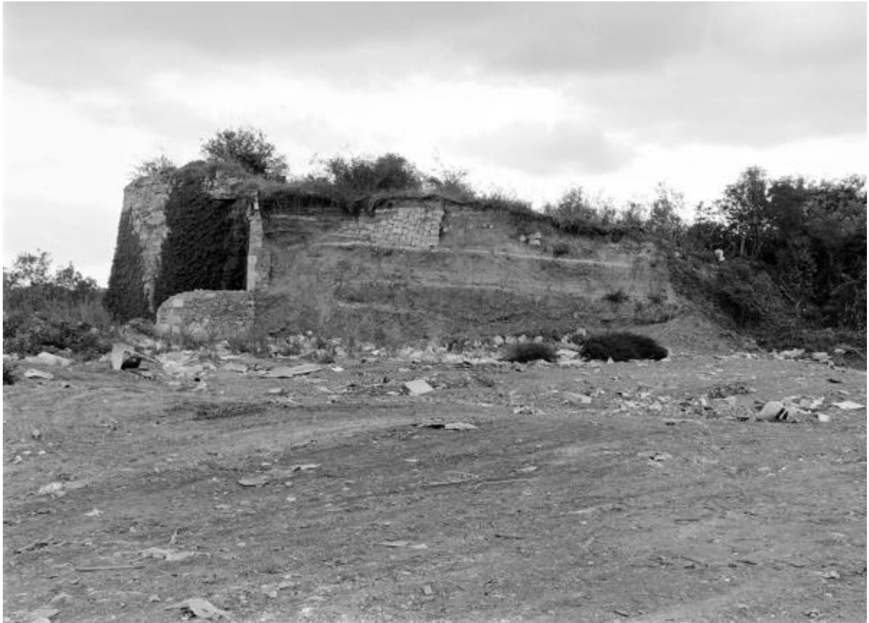
Four en tour à rampe postérieure, vu depuis l'est, four à chaux du Lièvre, Montjean-sur-Loire.
