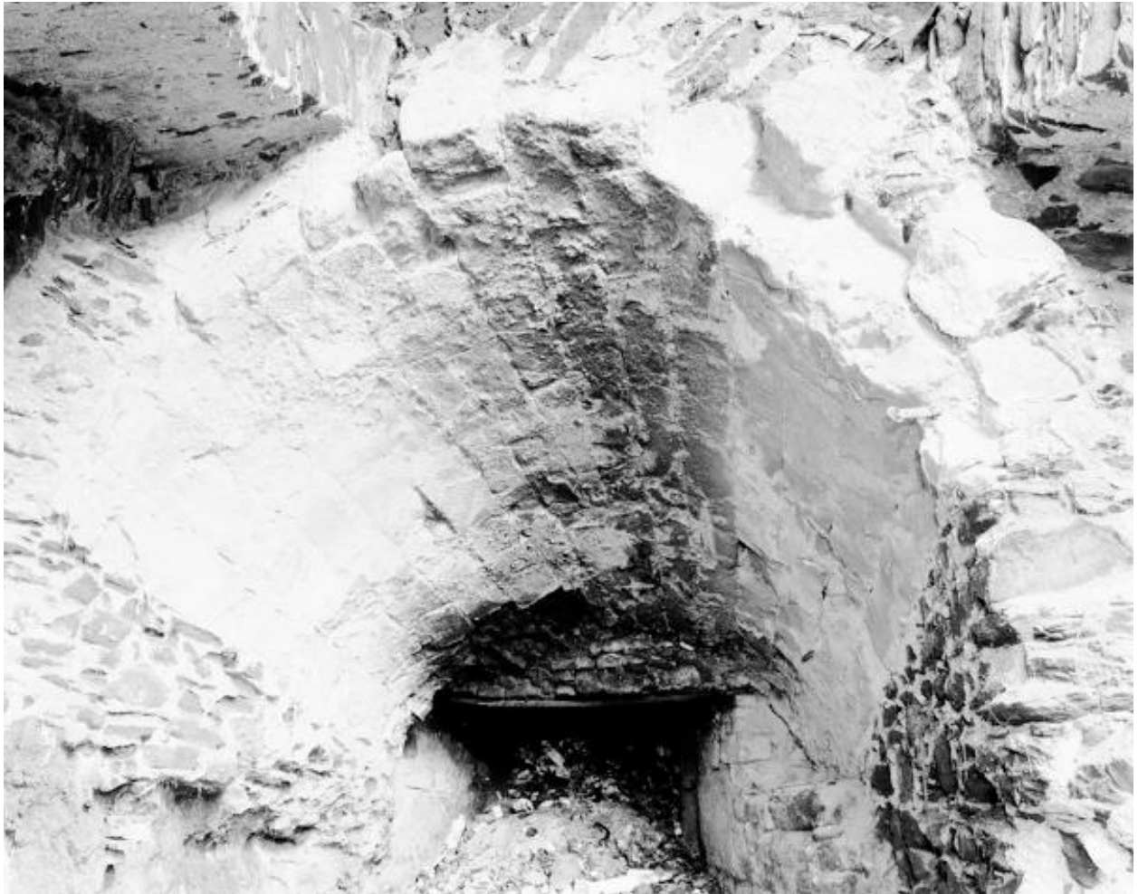
Ebraisoir (est) couvert d'une voûte en canonnière appareillée en panache, en tuffeau de taille, four à chaux de Maison-Blanche, Montjean-sur-Loire.
