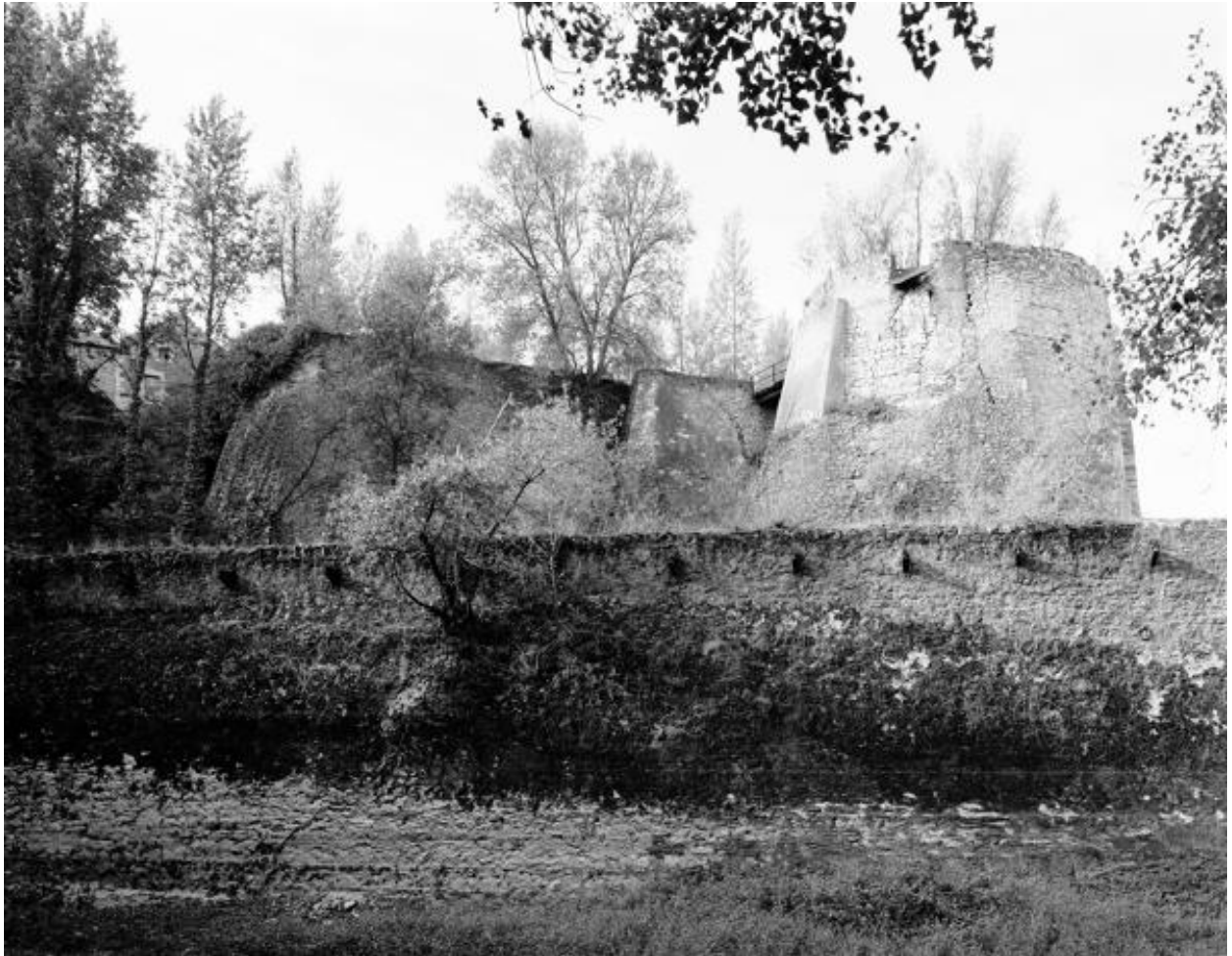
Four en tour avec contreforts, vue d'ensemble depuis le nord-est, au premier plan, quai bordant le ruisseau du Petit-Fourneau, au second plan, à droite le four de l'Union, à gauche le four de la Jalousie, Maison-Blanche, Montjean-sur-Loire.
