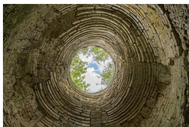
Chambre de combustion du four à chaux de Jalousie, vue verticale de bas en haut, Maison-Blanche, Montjean-sur-Loire. Phot. Armelle Maugin IVR52_20194900838NUCA
