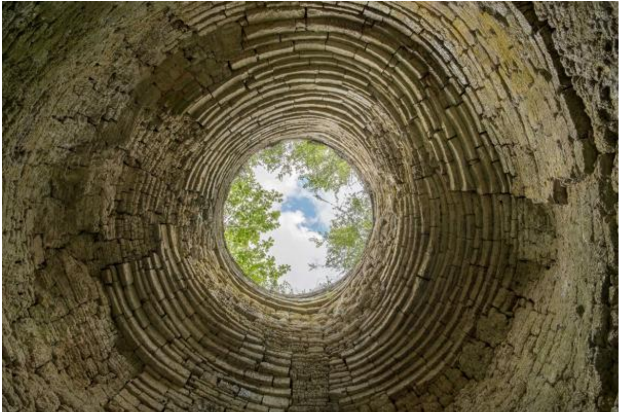
Chambre de combustion du four à chaux de Jalousie, vue verticale de bas en haut, Maison-Blanche, Montjean-sur-Loire.
