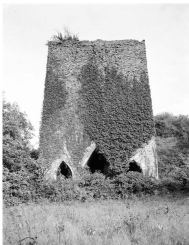
Four à chaux de Sainte Barbe, face ouest, Montjean-sur-Loire. Phot. Bruno Rousseau IVR52_19854901755V
