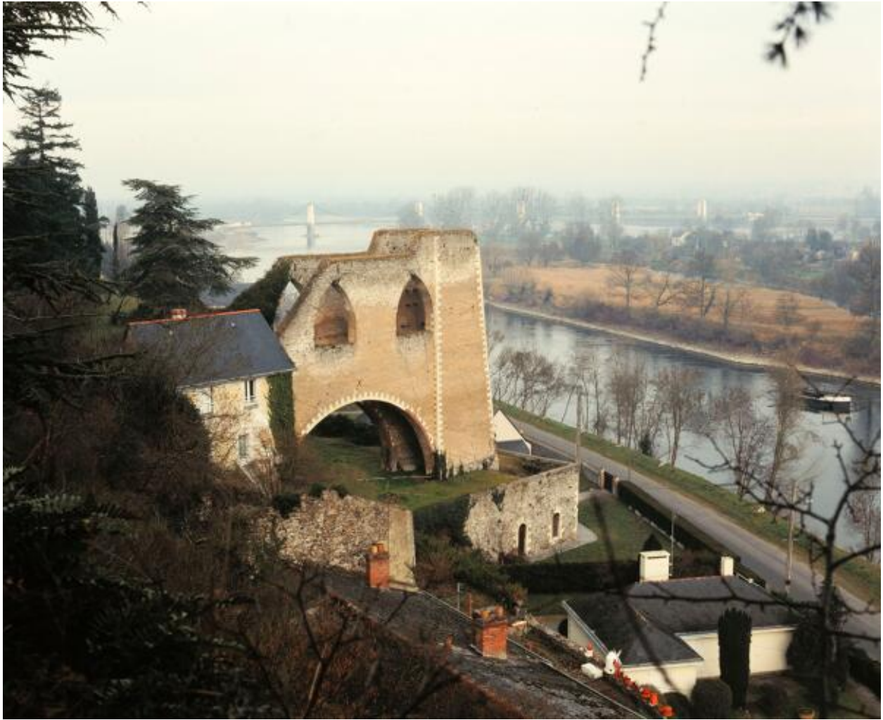
Chevalement du puits de la Tranchée, fours de la Tranchée, Montjean-sur-Loire.
