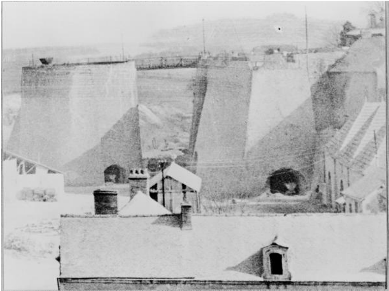
Four en tour adossé à une falaise (à droite) et four isolé, relié à une plateforme par une passerelle (à gauche), vue depuis l'Ouest, fours de l'Union et de Clermont, Maison-Blanche, Montjean-sur-Loire. Détail d'une vue d'ensemble de Valentin Laroute, vers 1920, collection privée Maurice Chrétien.
