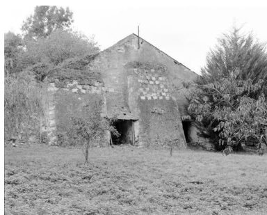
Bâtiment de stockage à contreforts, charbonnière est (parcelle 115), face sud-est, chaufournerie de Maison-Blanche, Montjean-sur-Loire. Phot. Bruno Rousseau IVR52_19854901725X
