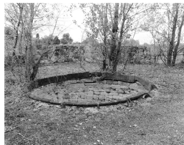
Cerclage de gueulard en fonte, plateforme du massif, four à chaux de Clermont depuis l'est, Maison-Blanche, Montjean-sur-Loire. Phot. Bruno Rousseau IVR52_19854901718X
