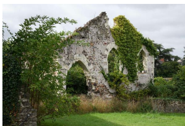
Vue d'ensemble du bâtiment renfermant la machine d'extraction du puits de charbon dit du Village, Montjean-sur-Loire. Phot. Armelle Maugin IVR52_20244900783NUCA
