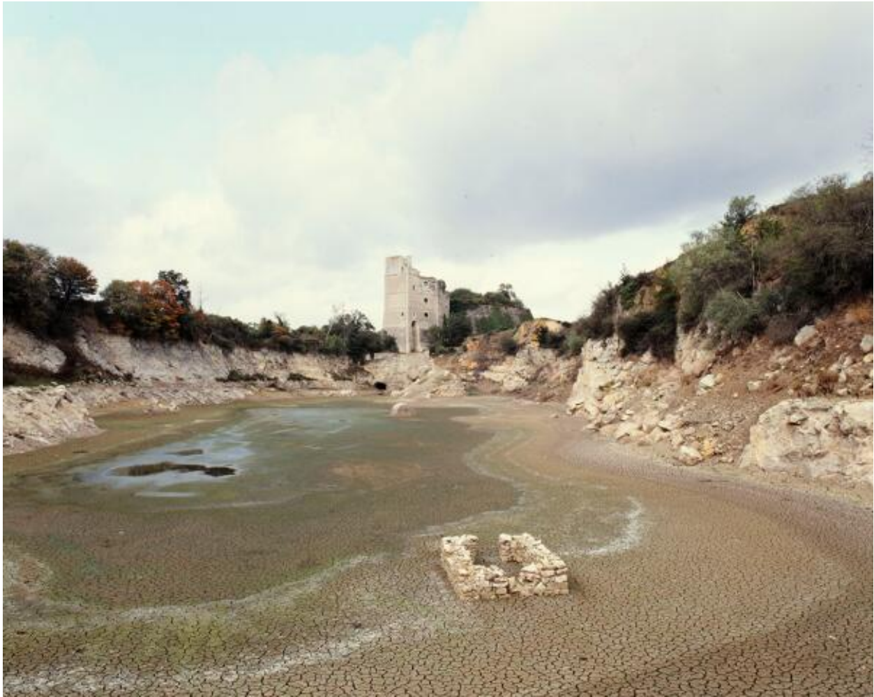
Élévateur et carrière de la chauxfournerie de Pincourt, vue depuis l'est, four de Sainte Barbe, Montjean-sur-Loire.
