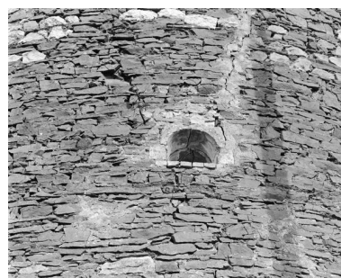
Bouche d'aération sud-ouest du four du Lapin destinée à activer la combustion au niveau du "ventre" du four, détail du parement en moellons schisto-gréseux, Montjean-sur-Loire. Phot. Bruno Rousseau IVR52_19854901736X
