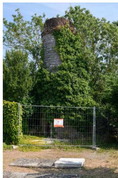
Vue d'ensemble de la cheminée d'aération des puits de mine de charbon, cimetièrre, Montjean-sur-Loire. Phot. Armelle Maugin IVR52_20244900503NUCA
