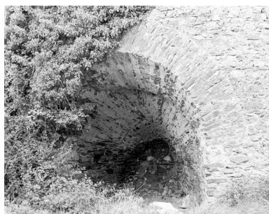
Masse de four en tour à enveloppes concentriques, ébraisoir sud, four à chaux du Lièvre, Montjean-sur-Loire. Phot. Bruno Rousseau IVR52_19854901747X
