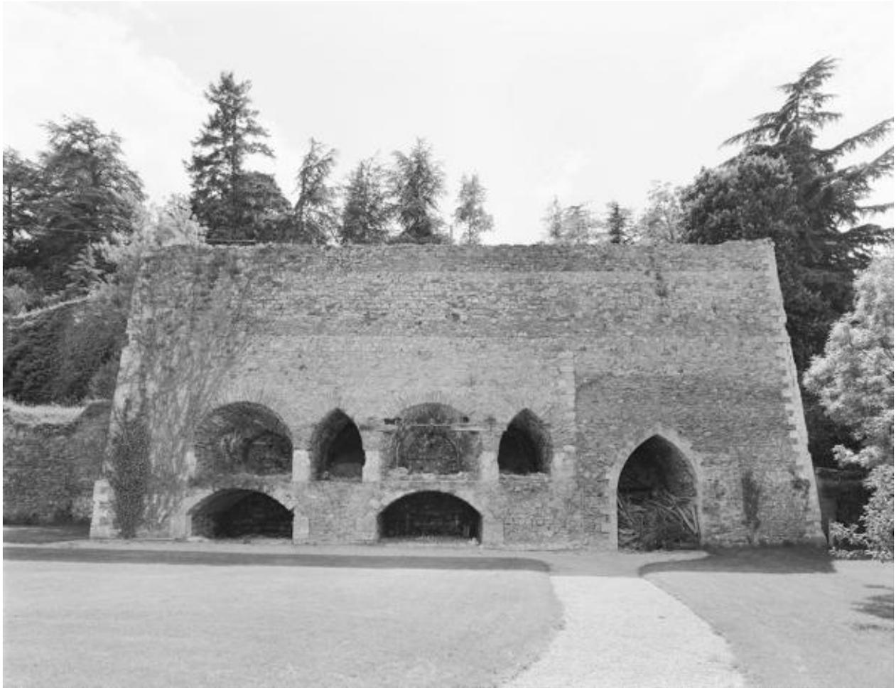
Fours en massif pyramidal, fours à chaux de la Tranchée, face nord, Montjean-sur-Loire.
