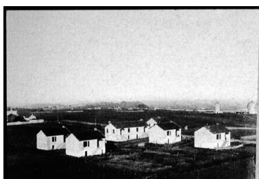
Cité ouvrière de la chaufournerie de Châteaupanne, située près du four Cathelinais au sud-ouest de Maison-Blanche sur le plateau. Photographie, vers 1930, collection privée, Montjean-sur-Loire. Phot. Bruno Rousseau IVR52_19864900767X
