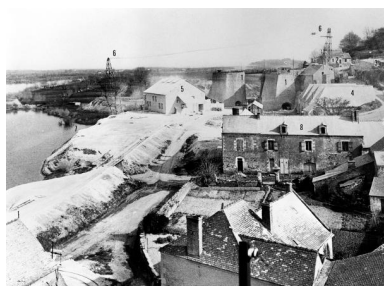
Vue d'ensemble de la chaufournerie depuis l'ouest, Maison-Blanche, Montjean-sur-Loire. Cliché de Valentin Laroute, vers 1920, collection privée de Maurice Chrétien. Phot. Bruno Rousseau IVR52_19864900585X
