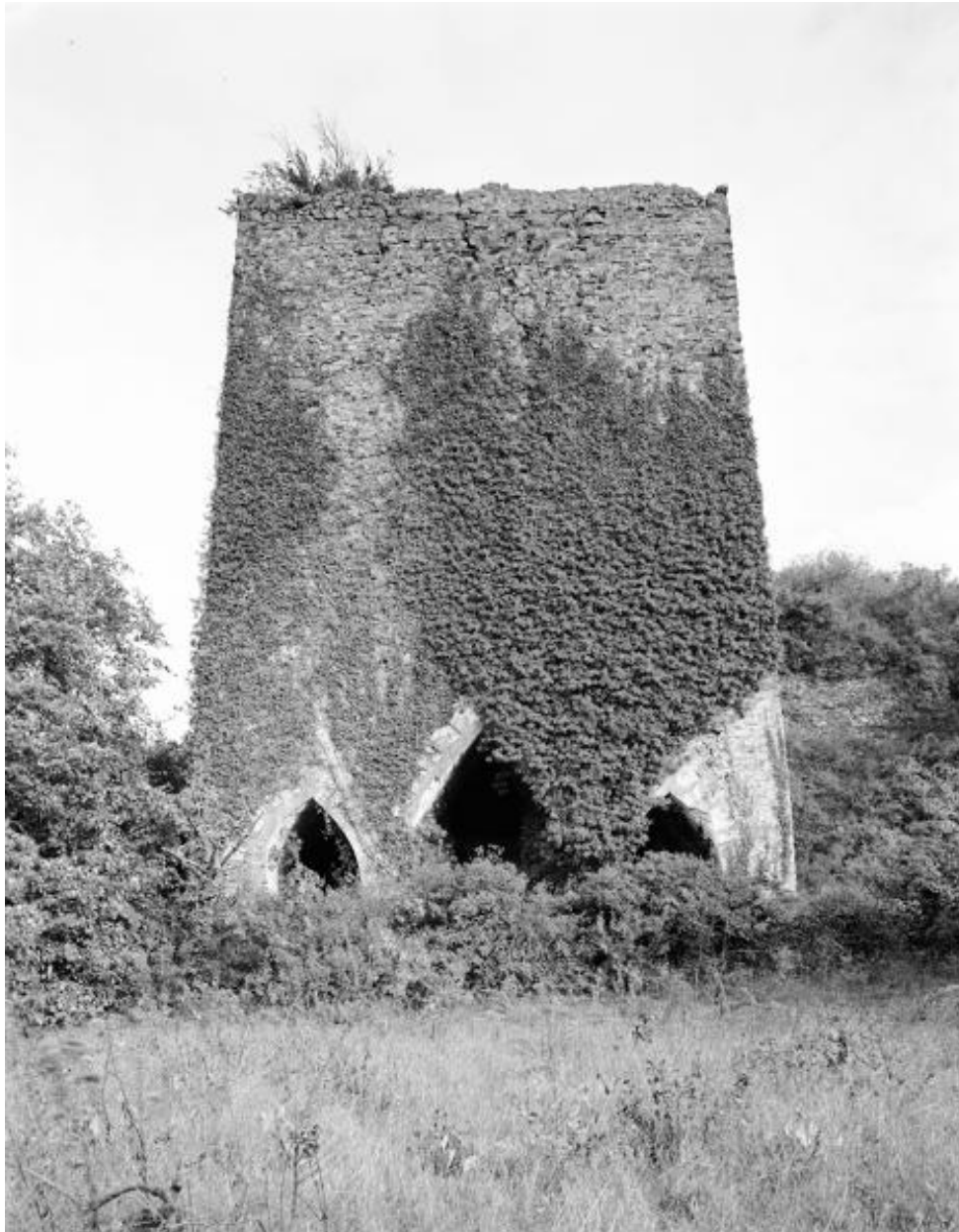
Four à chaux de Sainte Barbe, face ouest, Montjean-sur-Loire.
